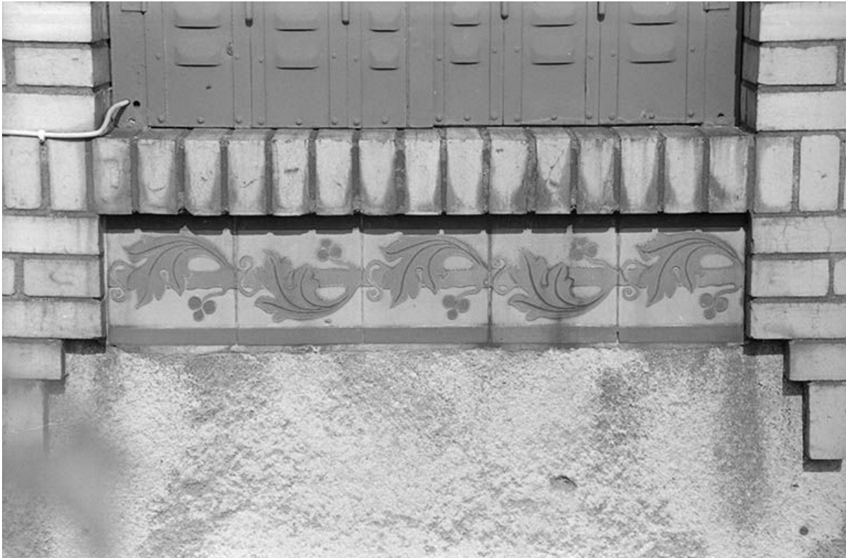
Carreaux en céramique polychrome sous l'appui d'une baie du logement " du directeur ". 71, Écuisses, 66.76 route du Canal, lieudit : la Rompey
