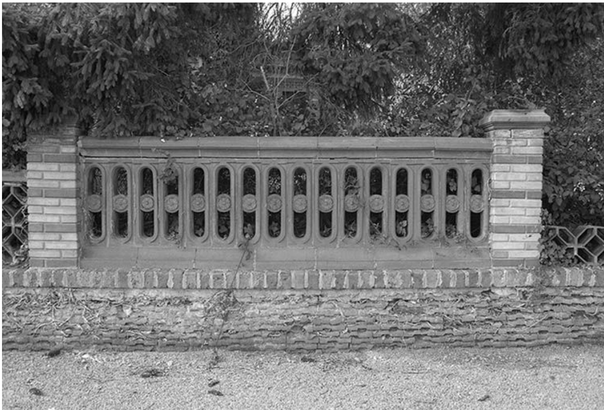
Mur de clôture constitué d'éléments en céramique produits par les établissements Perrusson & Desfontaines (73-74 route du Canal).
