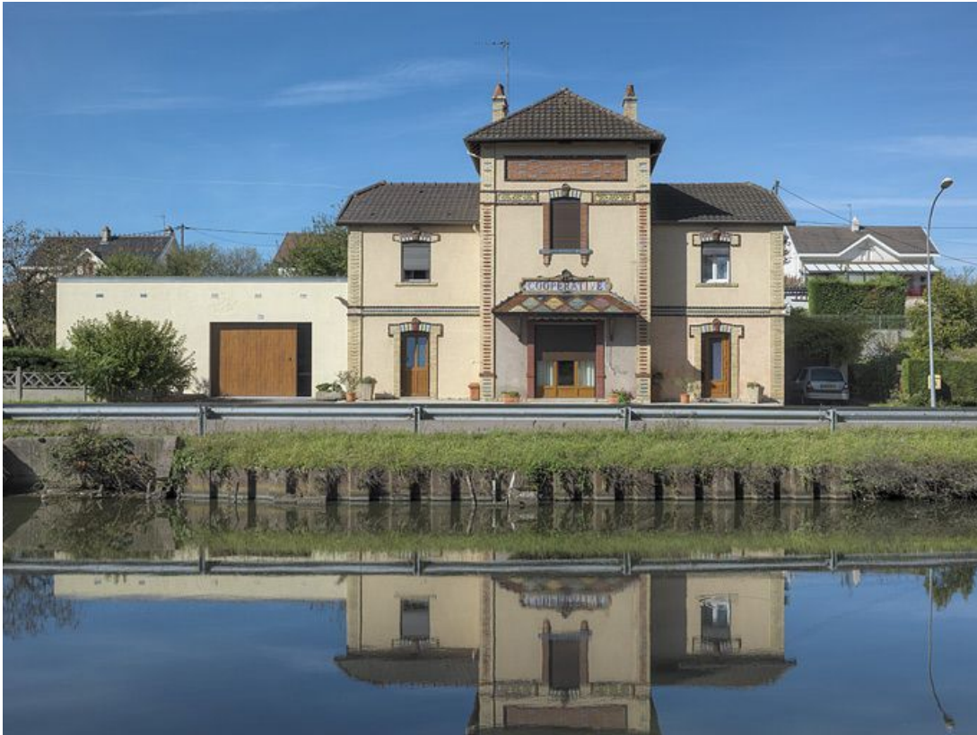
Un des pavillons de la cité Perrusson rive gauche. 71, Écuisses, 66.76 route du Canal, lieudit : la Rompey
