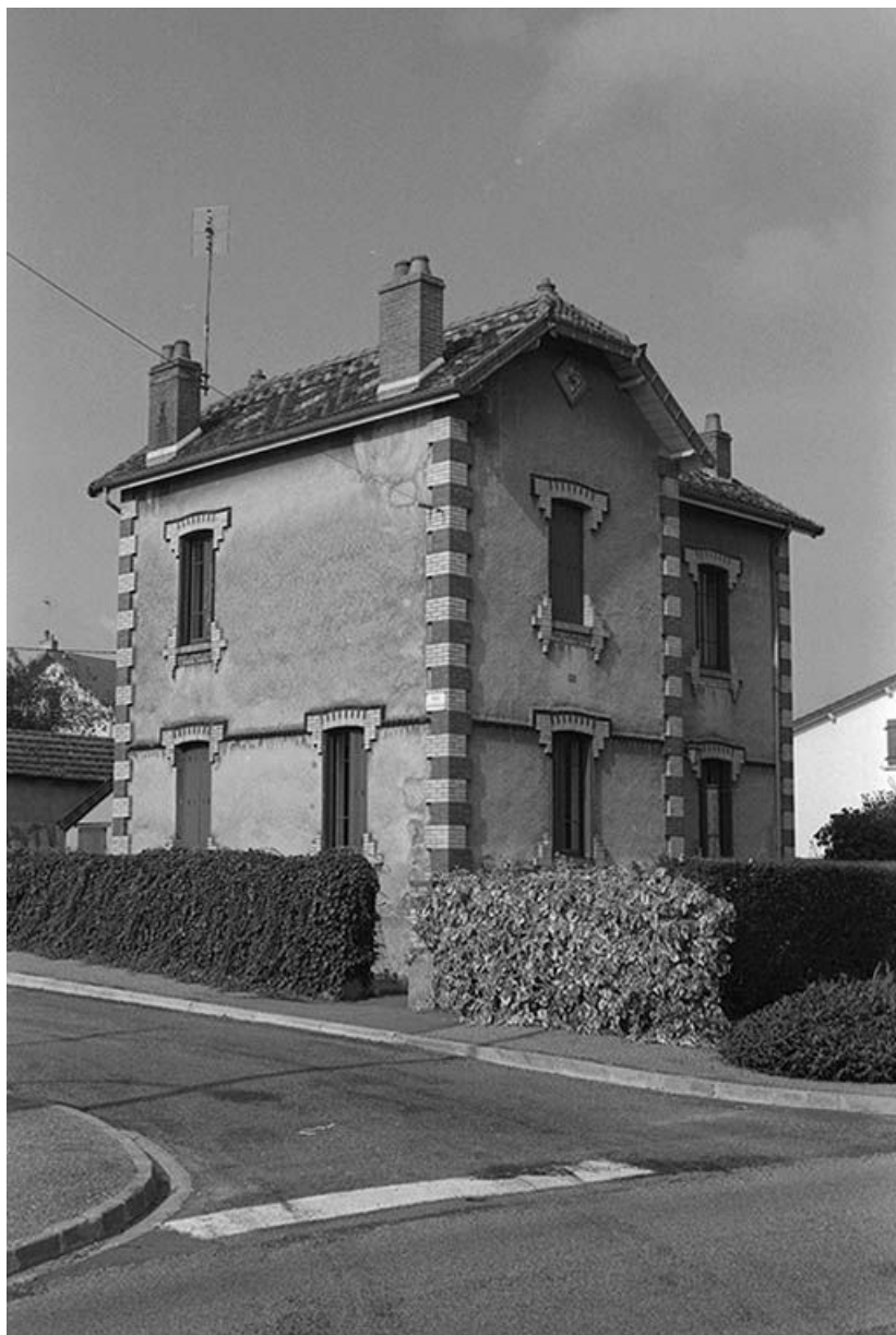
Logement " du directeur " construit vers 1930, vu du sud.
