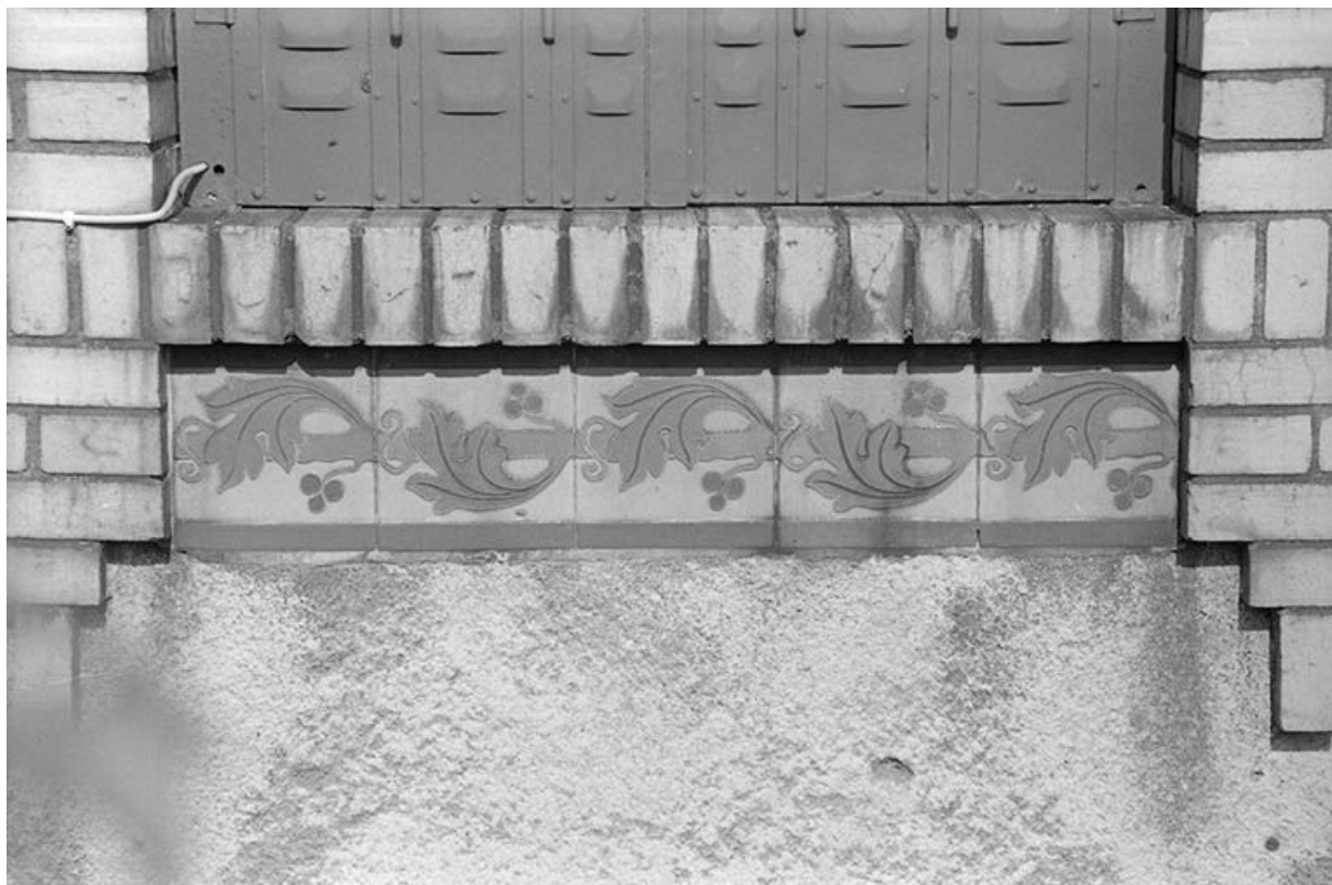
Carreaux en céramique polychrome sous l'appui d'une baie du logement " du directeur ".
