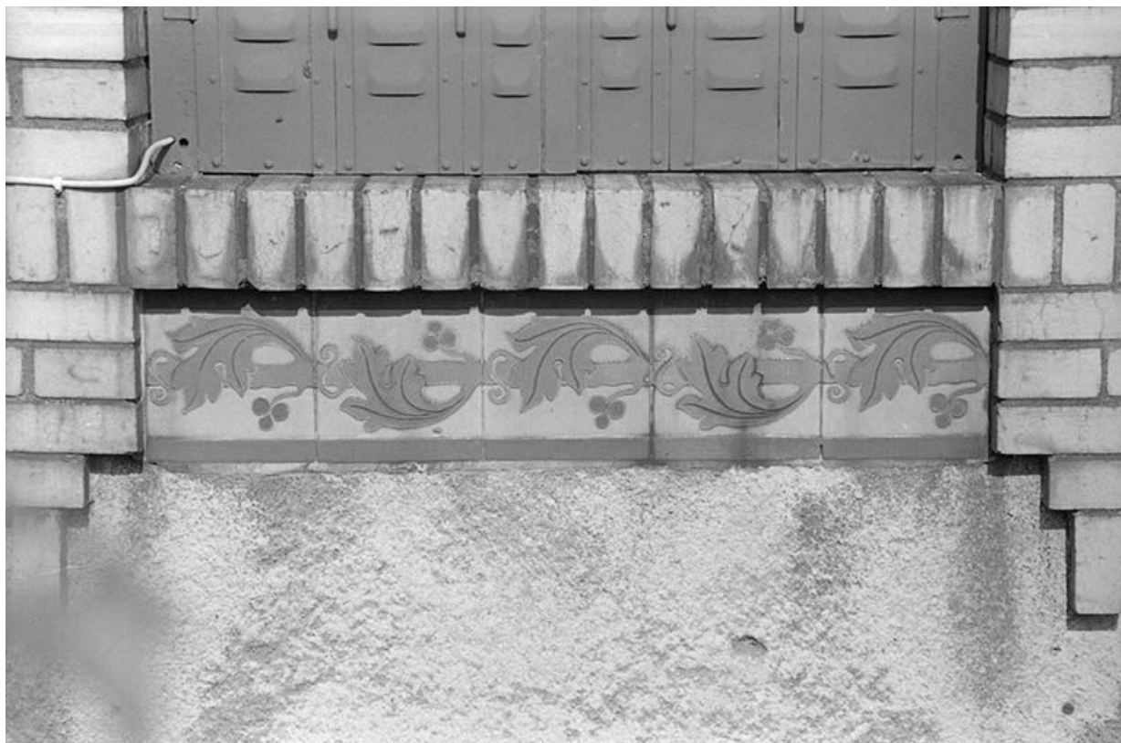
Carreaux en céramique polychrome sous l'appui d'une baie du logement " du directeur ".
