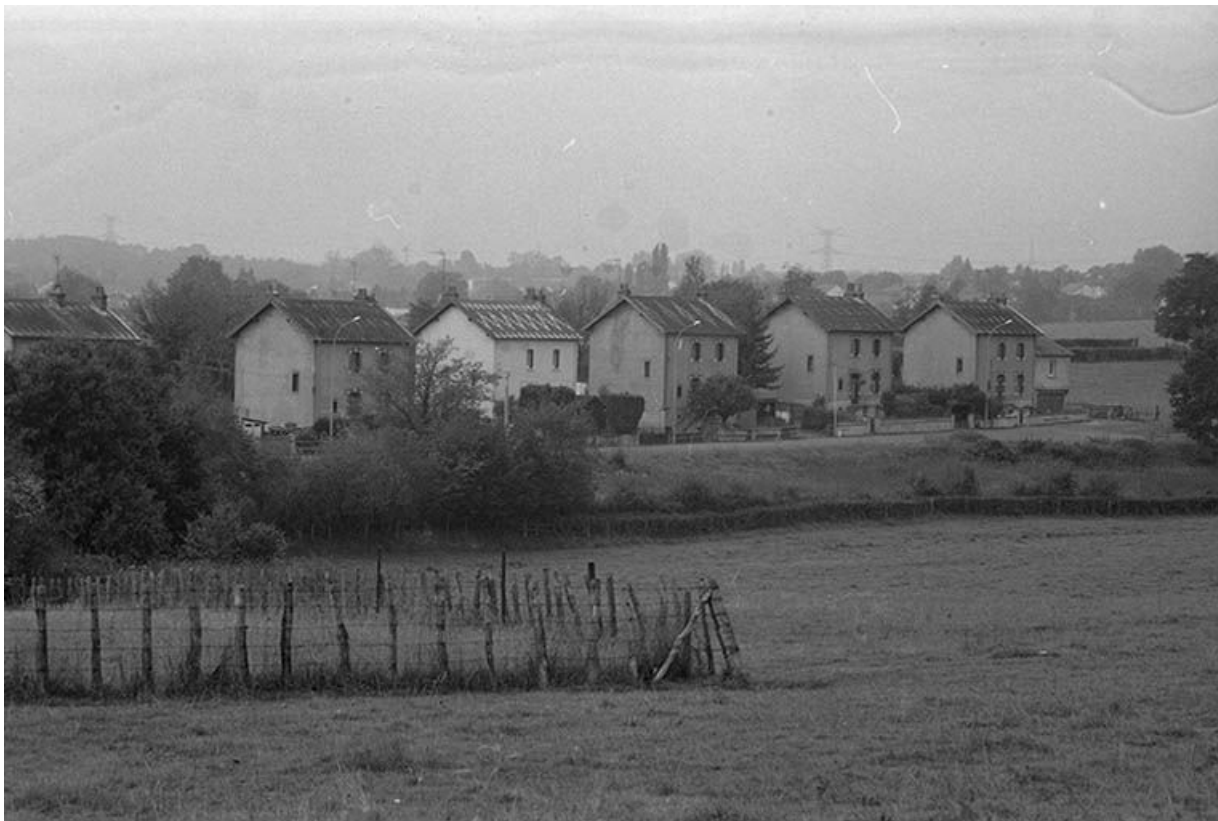
Bâtiments à un seul logement construits en 1933-35 rue Gabriel Desfontaines, vus depuis les écuries du Château Perrusson (au nord).
