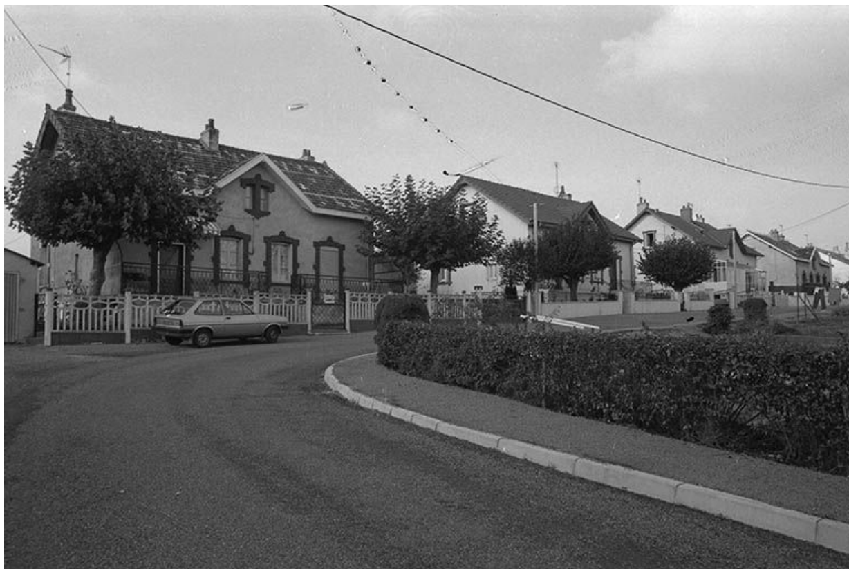
Bâtiments à deux logements construits à la fin du XIXe siècle, rue Jean-Baptiste Perrusson, (premiers bâtiments au sud). 71, Écuisses, 66.76 route du Canal, lieudit : la Rompey
