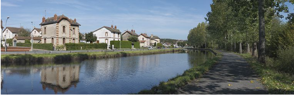
Vue d'ensemble des pavillons de la cité Perrusson rive gauche.
