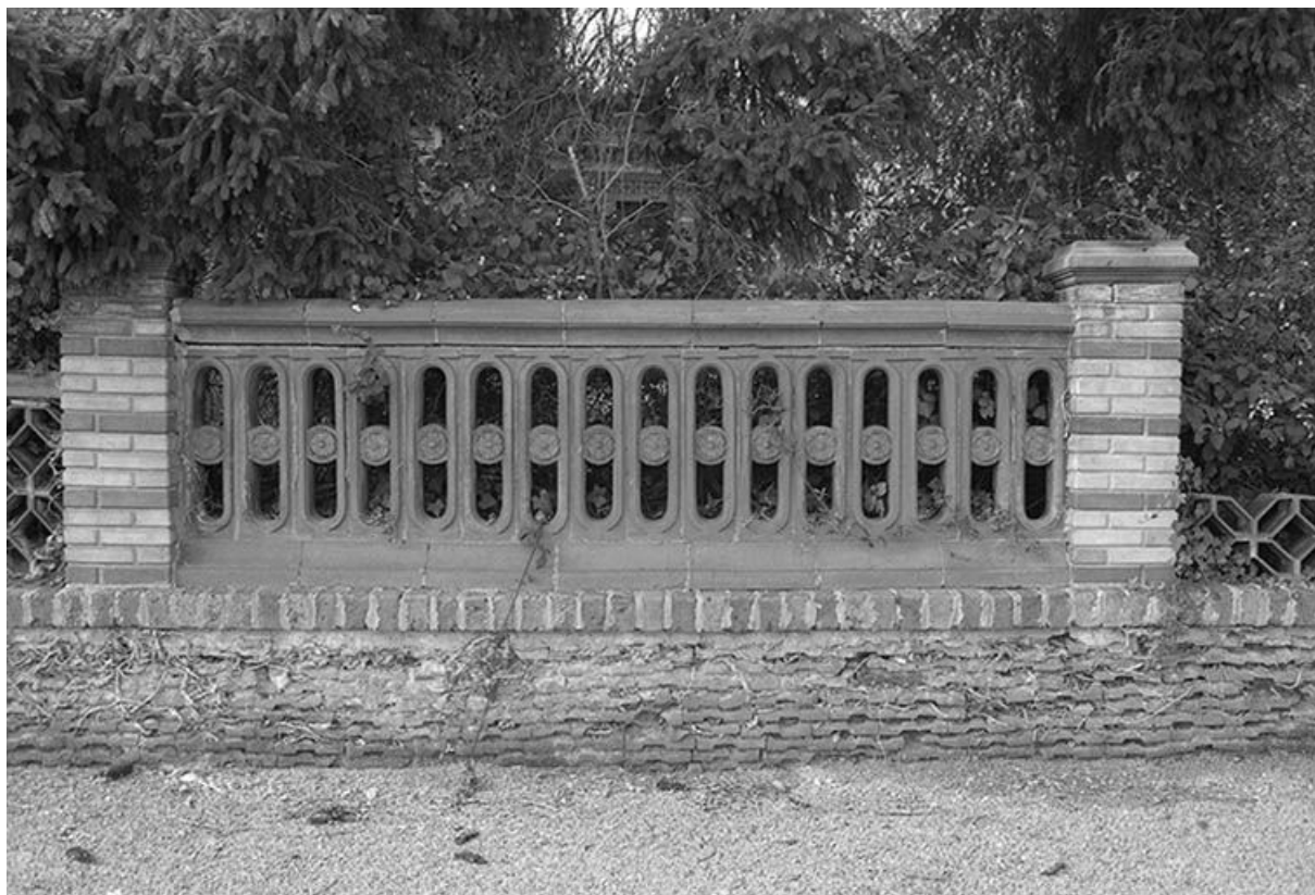
Mur de clôture constitué d'éléments en céramique produits par les établissements Perrusson & Desfontaines (73-74 route du Canal).
