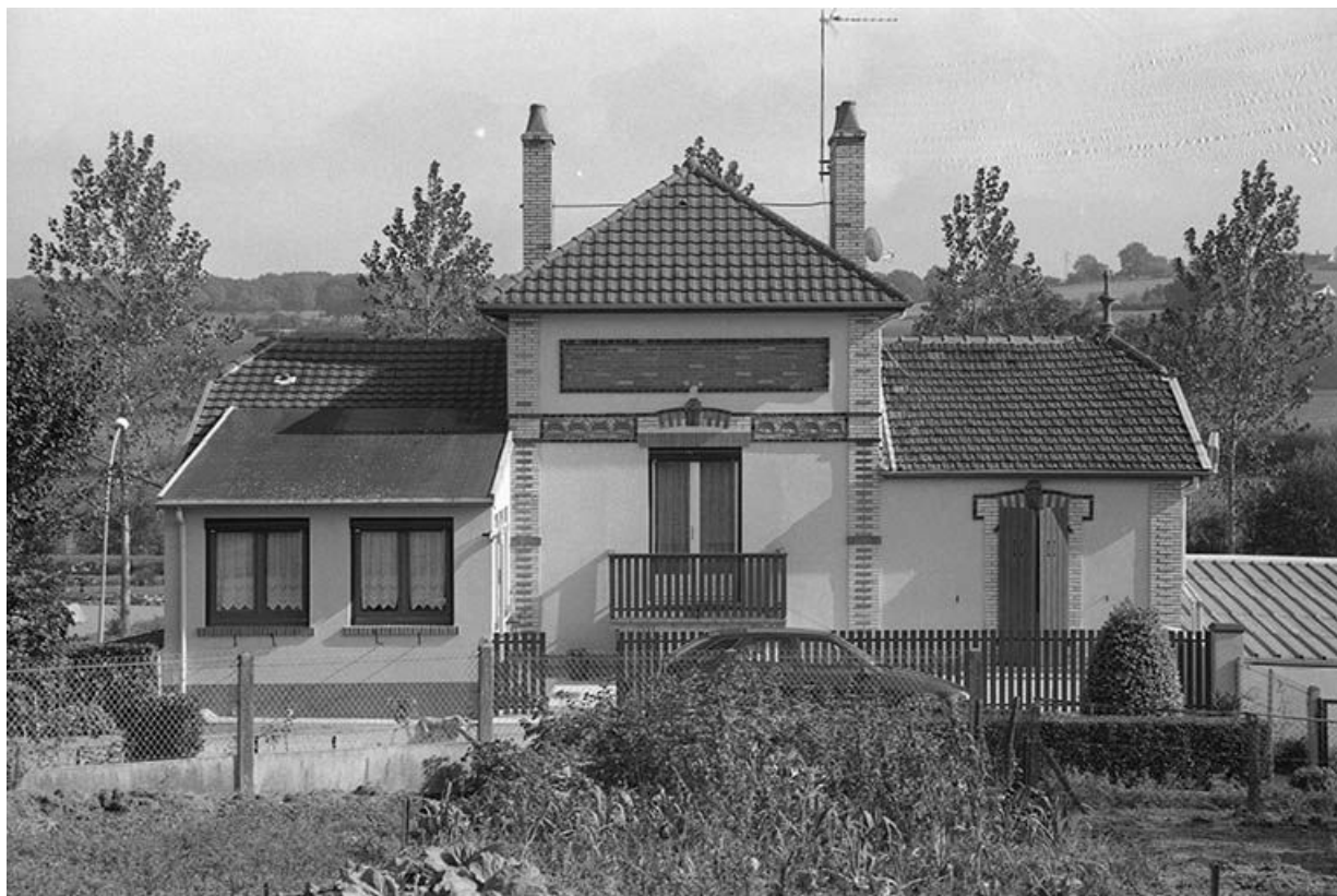
Façade postérieure (rue J.-B. Perrusson) de l'ancienne boulangerie-épicerie coopérative (façade de l'épicerie). 71, Écuisses, 66.76 route du Canal, lieudit : la Rompey
