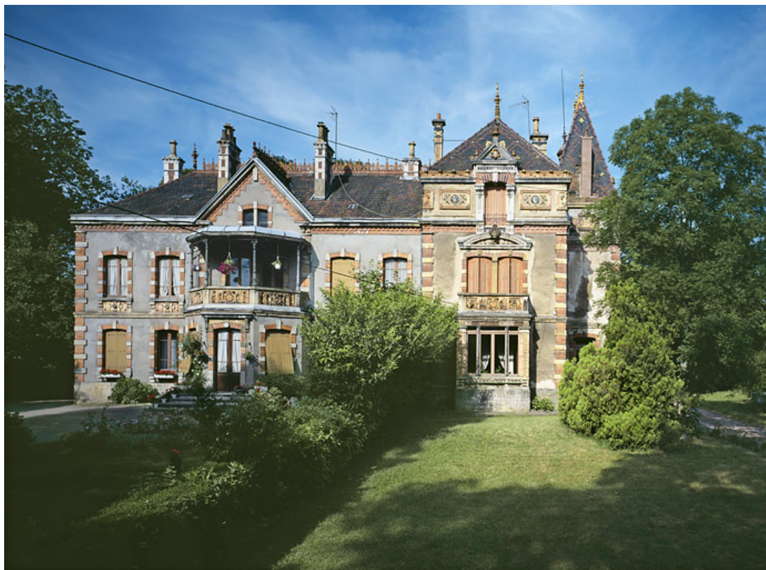
Façade antérieure vue depuis le parc du pavillon Desfontaines.
