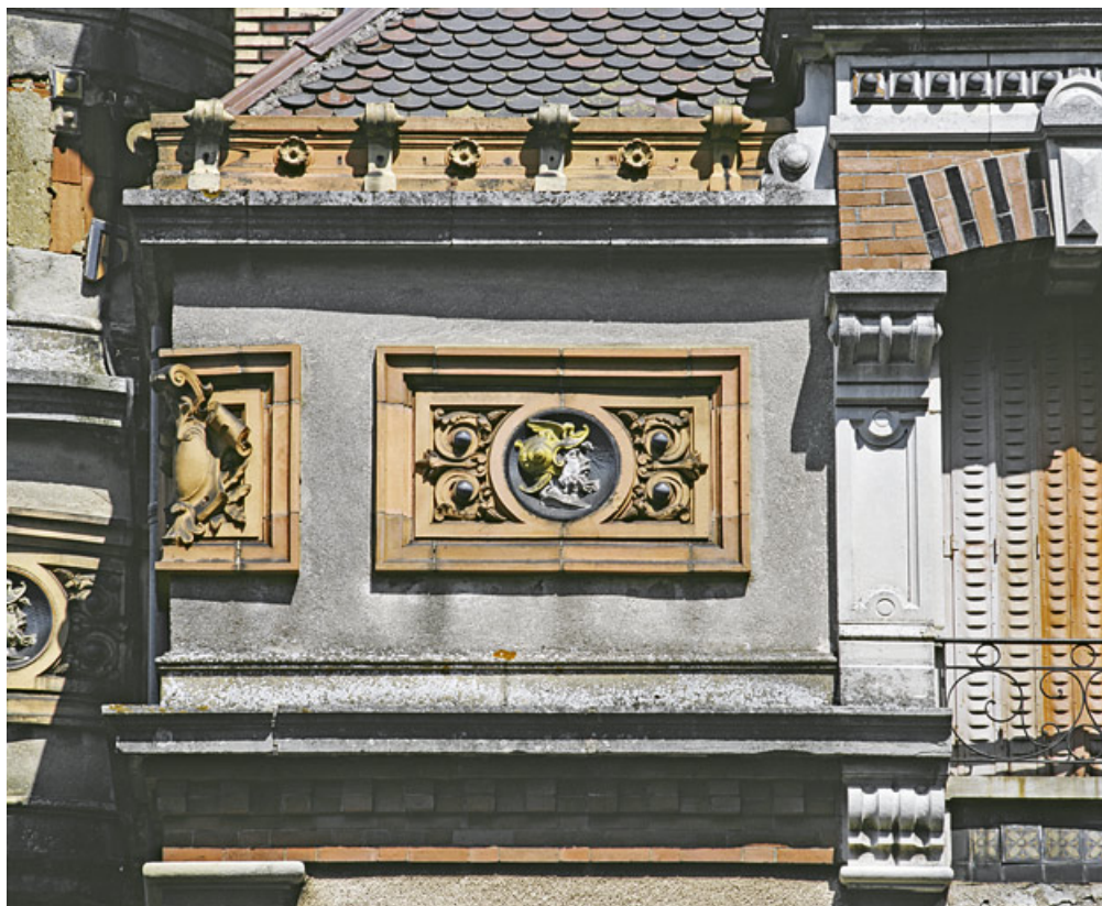
Panneau de céramique de l'étage-attique du pavillon Desfontaines.
