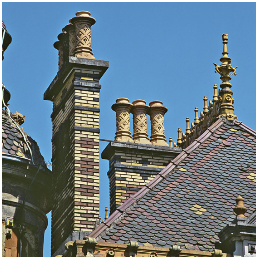
Détail de la toiture du pavillon Desfontaines.
