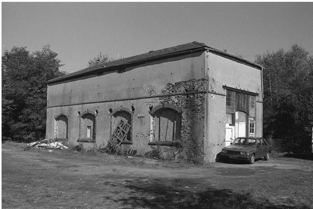
Salle des machines, vue du sud-ouest.
