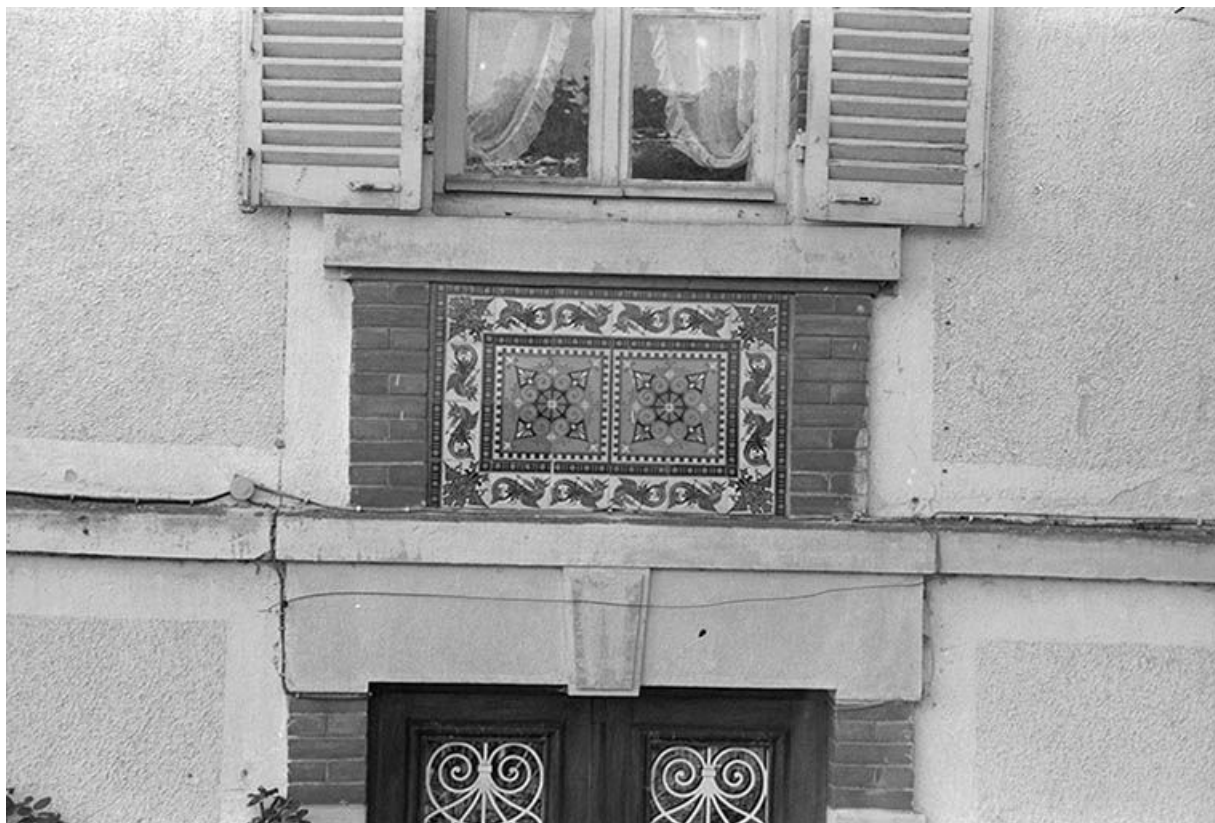
Détail de la façade est : allège de la baie du premier étage (carreaux de grès cérame produits par les Ets Perrusson d'Écuisses). 71, Écuisses, lieudit : la Première Ecluse
