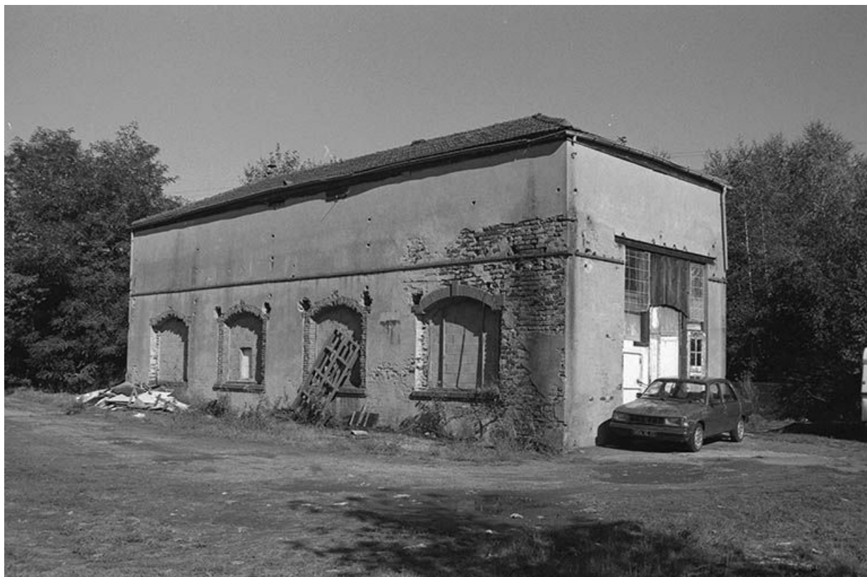
Salle des machines, vue du sud-ouest.
