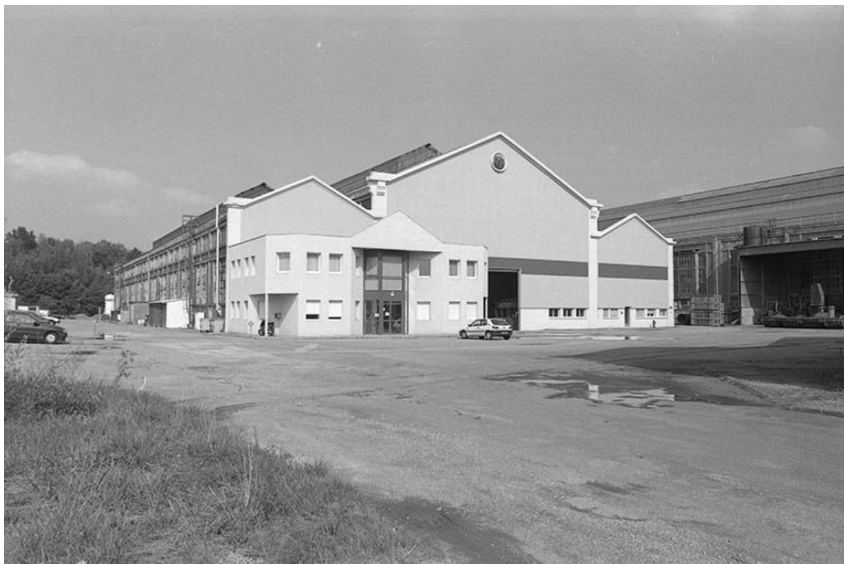
Façade antérieure de la fonderie de bronze, vue de l'ouest.
