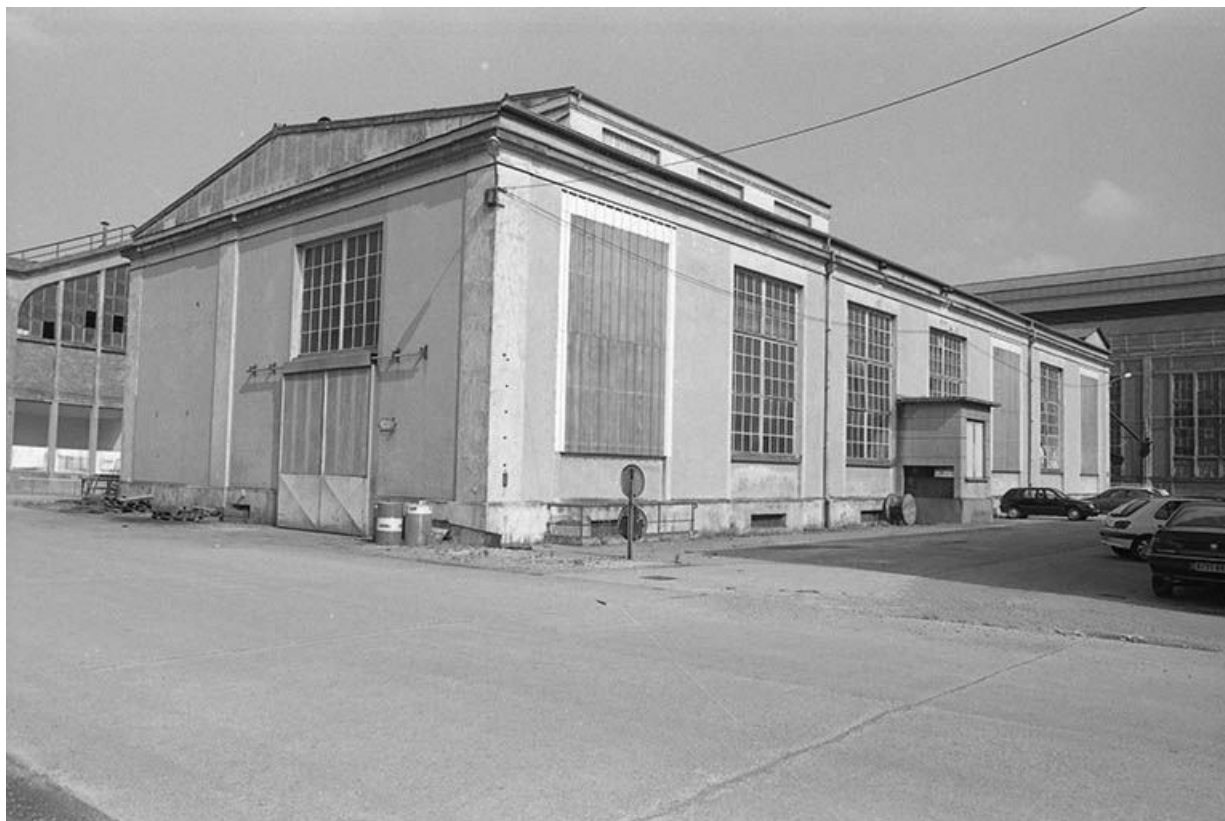
Sous-station électrique, vue de l'ouest. 71, Montchanin, lieudit : Usine Henri-Paul
