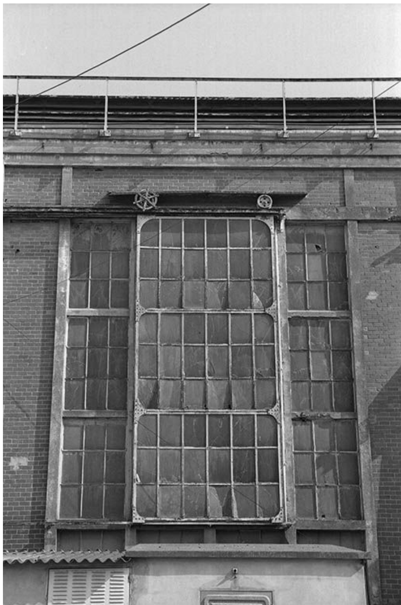
Détail d'une baie et de son mécanisme de châssis roulant, travée A, mur ouest de la fonderie de fonte. 71, Montchanin, lieudit : Usine Henri-Paul
