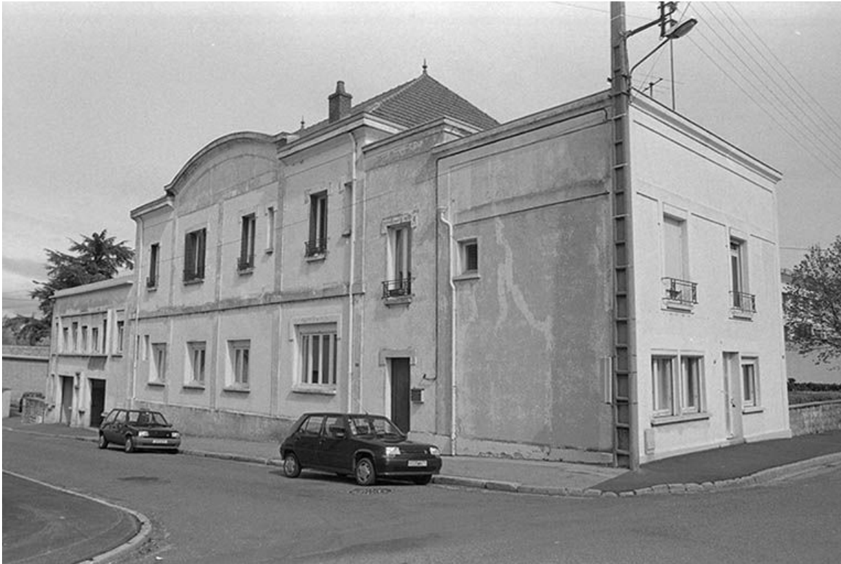
Vue de la façade sur rue vue depuis le carrefour des rue des Prés et de Ciry (de droite à gauche : le logement, les bureaux, le garage).
