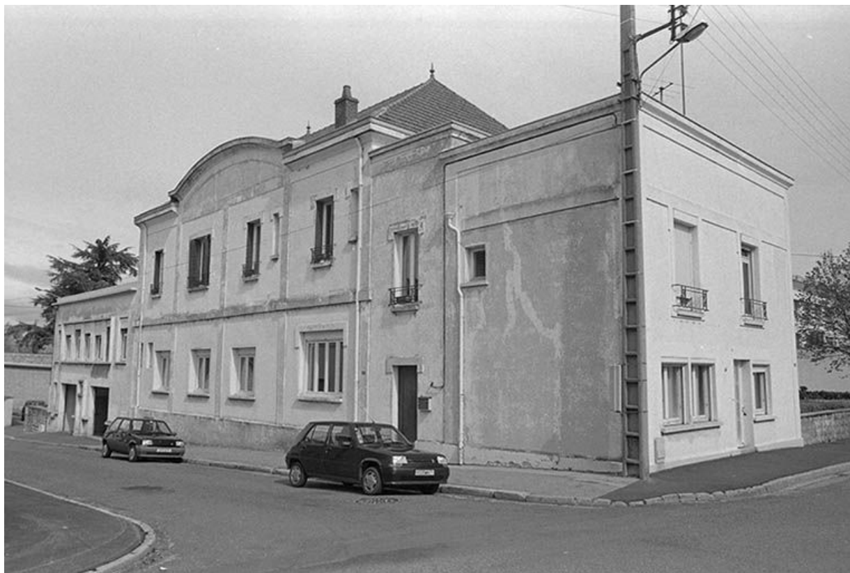
Vue de la façade sur rue vue depuis le carrefour des rue des Prés et de Ciry (de droite à gauche : le logement, les bureaux, le garage).
