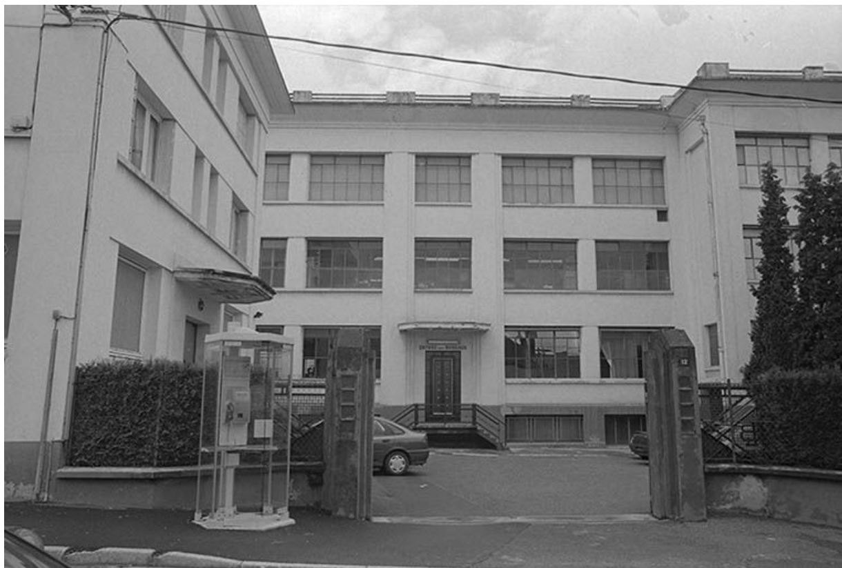
Vue des ateliers construits en 1948 (et logements), vus depuis la rue des Prés. 71, Montceau-les-Mines, 12 rue des Prés
