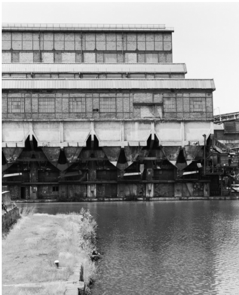
Au premier plan, port et trémies de chargement des péniches.
