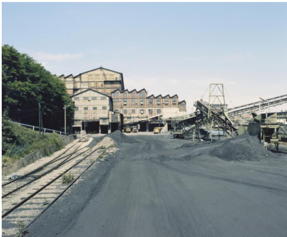
Voie ferrée desservant le lavoir des Chavannes pour le transport des produits lavés et bandes transporteuses de l'usine d'agglomérés, vue prise au sud du lavoir.
