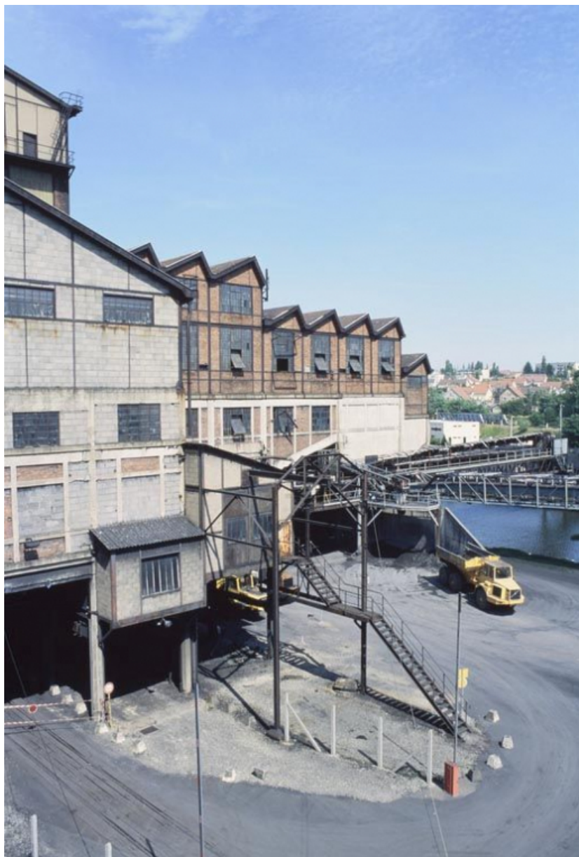
Le lavoir des Chavannes, vu depuis la rampe d'accès au lavoir (sud). 71, Montceau-les-Mines, 40 quai du Nouveau port, lieudit : les Chavannes
