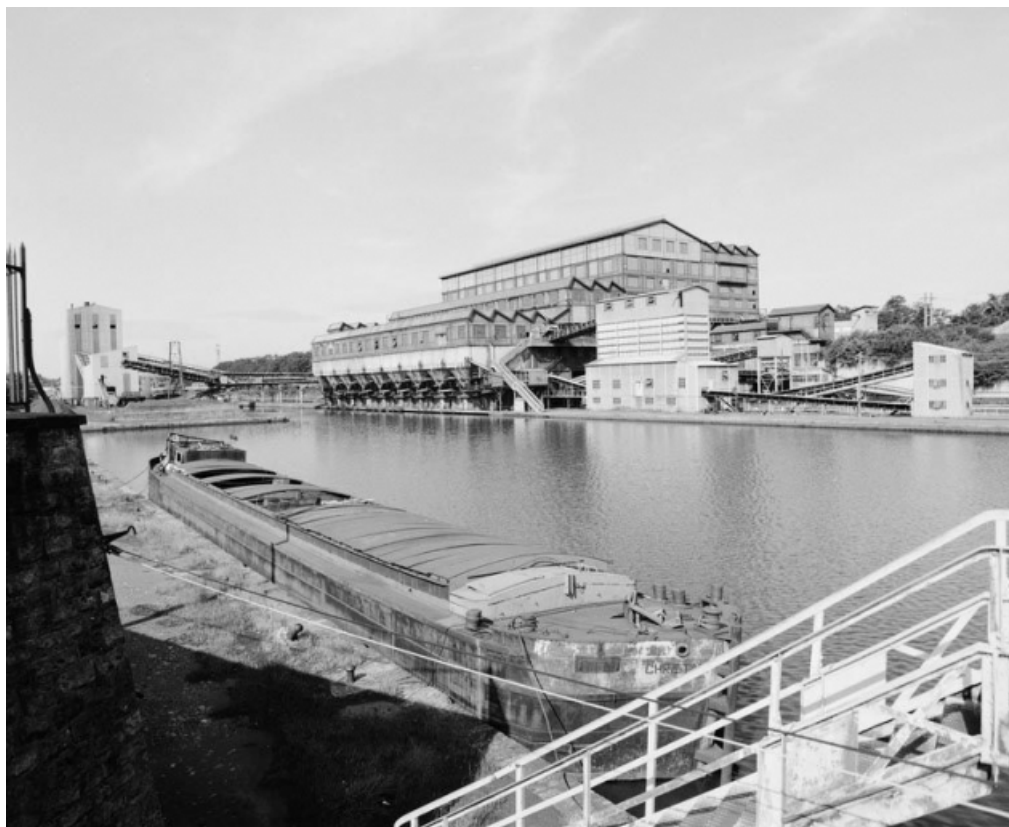
Vue de trois quarts depuis la passerelle du canal.
