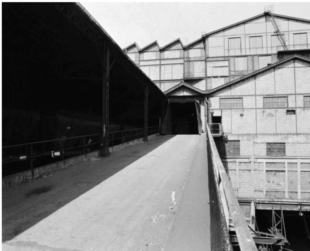
La rampe d'accès au lavoir des Chavannes.
