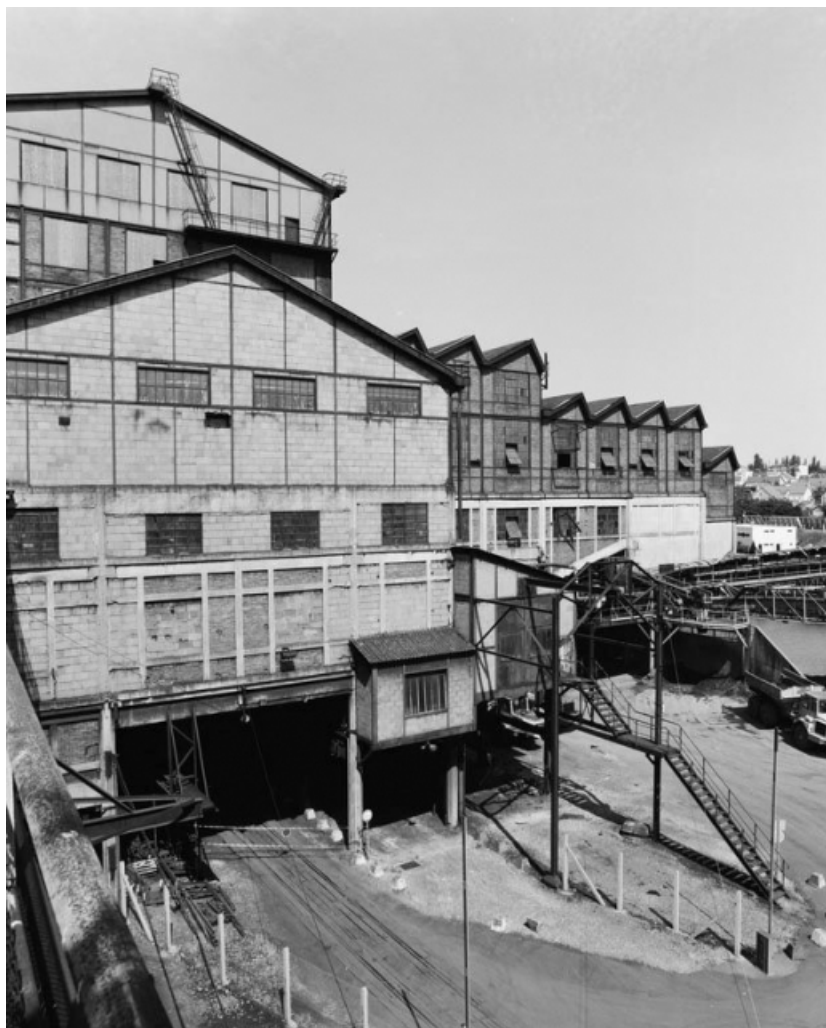
Le lavoir des Chavannes, vu depuis la rampe d'accès au lavoir (sud). 71, Montceau-les-Mines, 40 quai du Nouveau port, lieudit : les Chavannes
