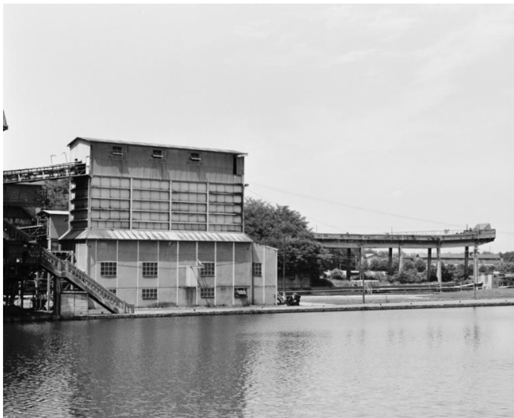
Silos (à gauche) et estacade de rebroussement des wagons après déchargement des produits bruts. 71, Montceau-les-Mines, 40 quai du Nouveau port, lieudit : les Chavannes
