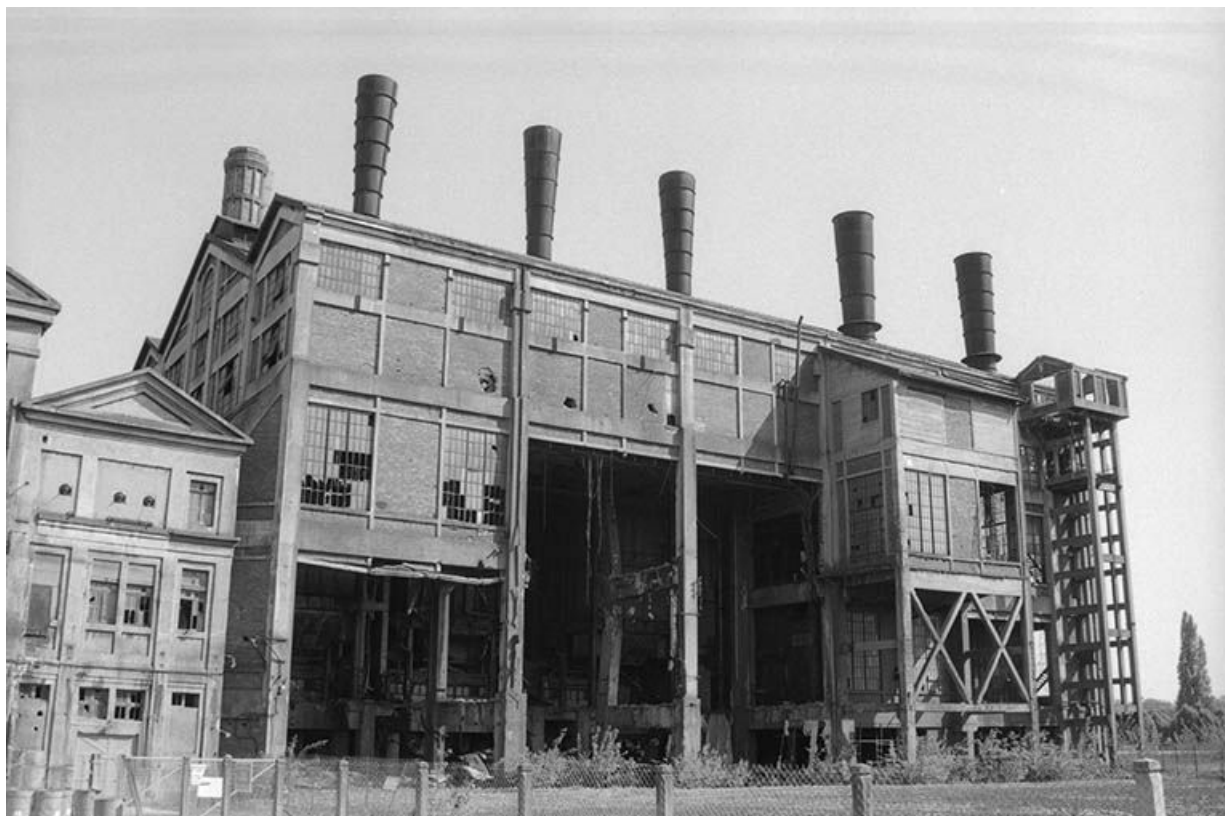
La chaufferie de Lucy II construite en 1923-1924, façade ouest.
