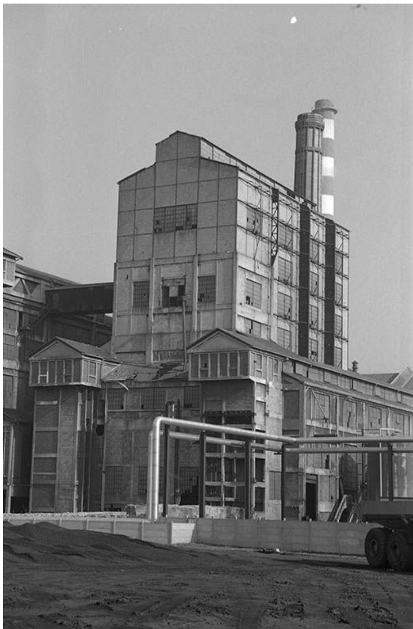
La chaufferie de Lucy II construite en 1919-1920 et son extension, pignons sud. 71, Montceau-les-Mines, 20 quai de Moulins
