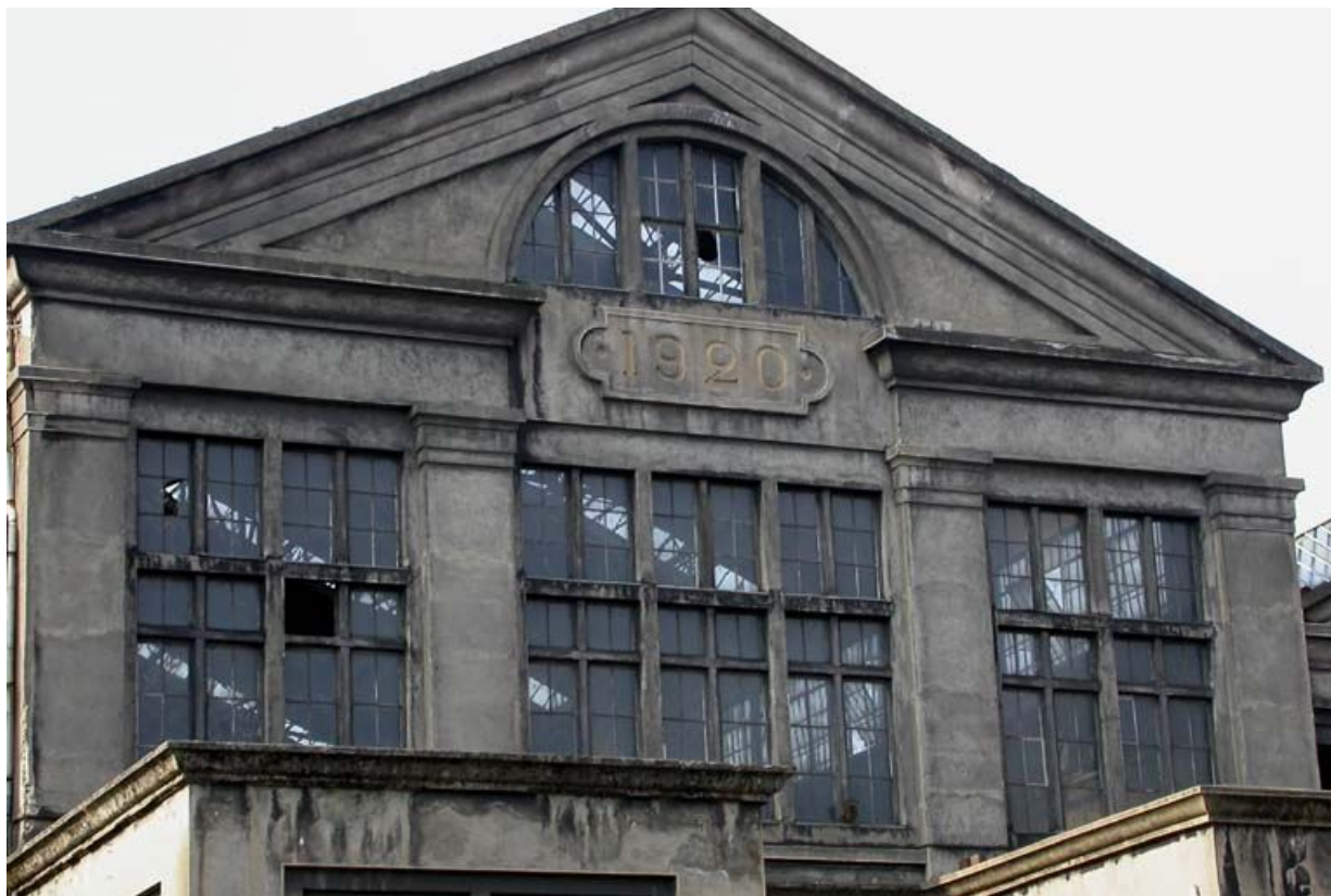
Élévation principale du bâtiments des alternateurs, détail.
