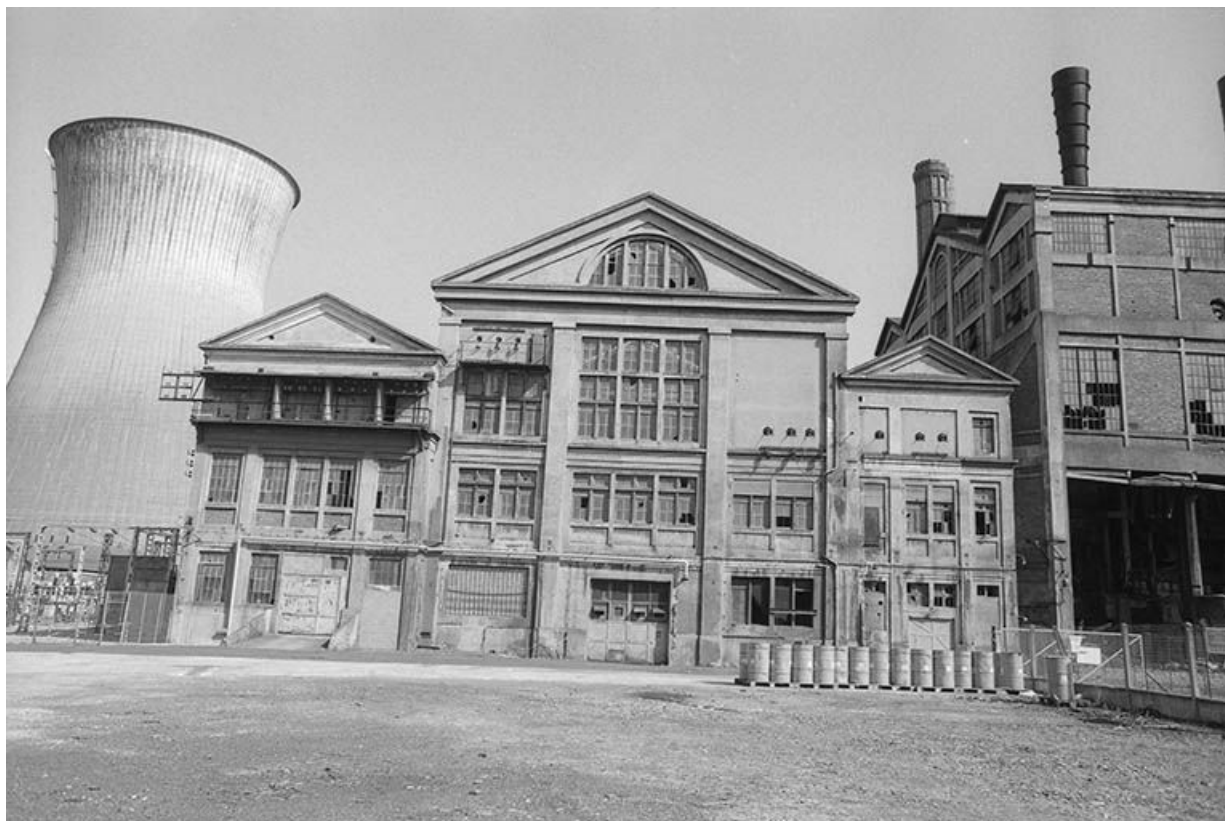
Façade postérieure de la centrale thermique de Lucy II (à droite les chaufferies, à gauche la tour de réfrigération de Lucy III). 71, Montceau-les-Mines, 20 quai de Moulins
