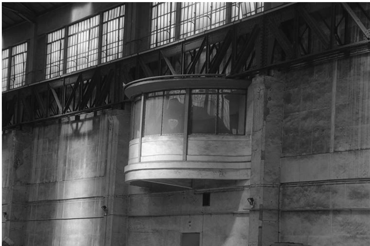
Le poste de contrôle de la salle des machines, installé dans le bâtiment des tableaux de distribution. 71, Montceau-les-Mines, 20 quai de Moulins
