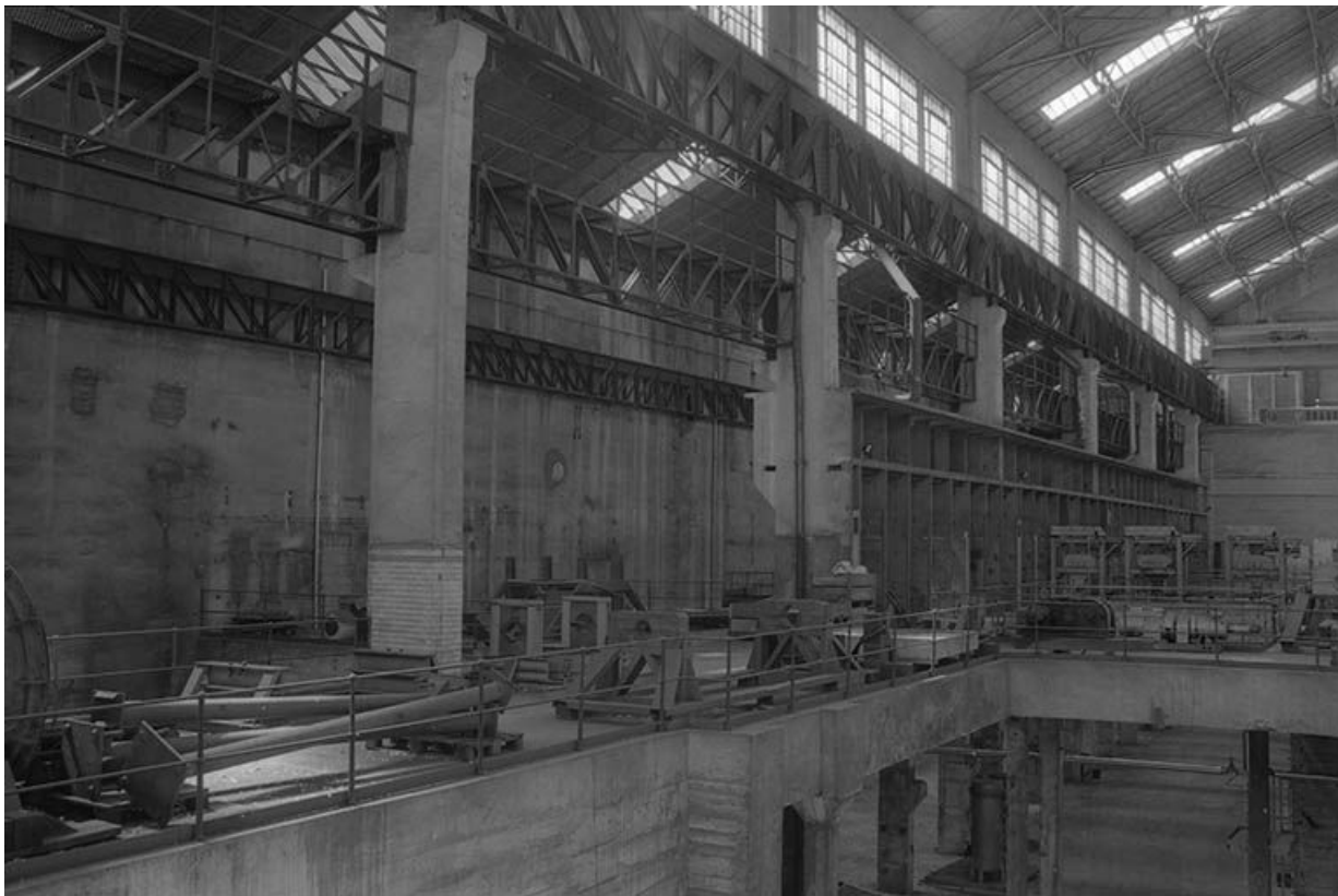
Le bâtiment des pompes vu depuis la salle des machines (ancienne plate-forme des turboalternateurs). 71, Montceau-les-Mines, 20 quai de Moulins
