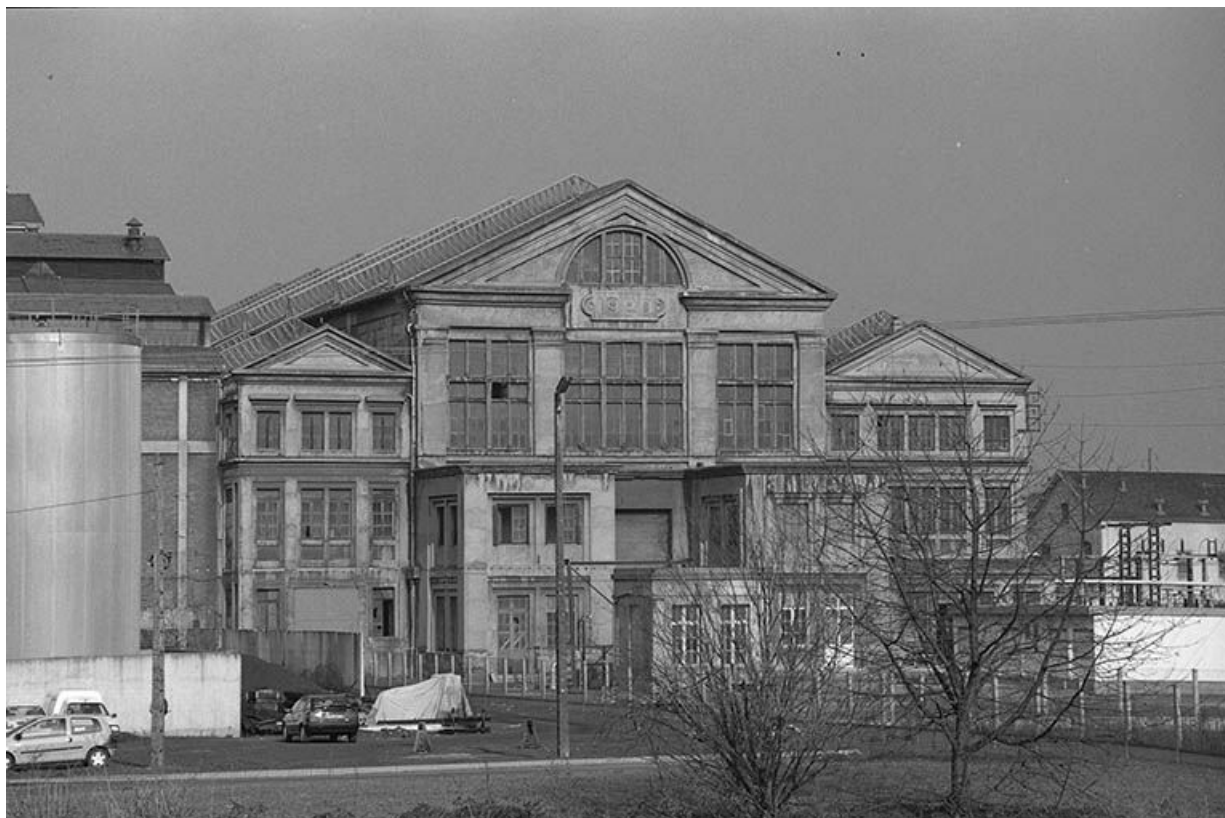
Façade antérieure de la centrale thermique de Lucy II vue depuis le canal du Centre. 71, Montceau-les-Mines, 20 quai de Moulins
