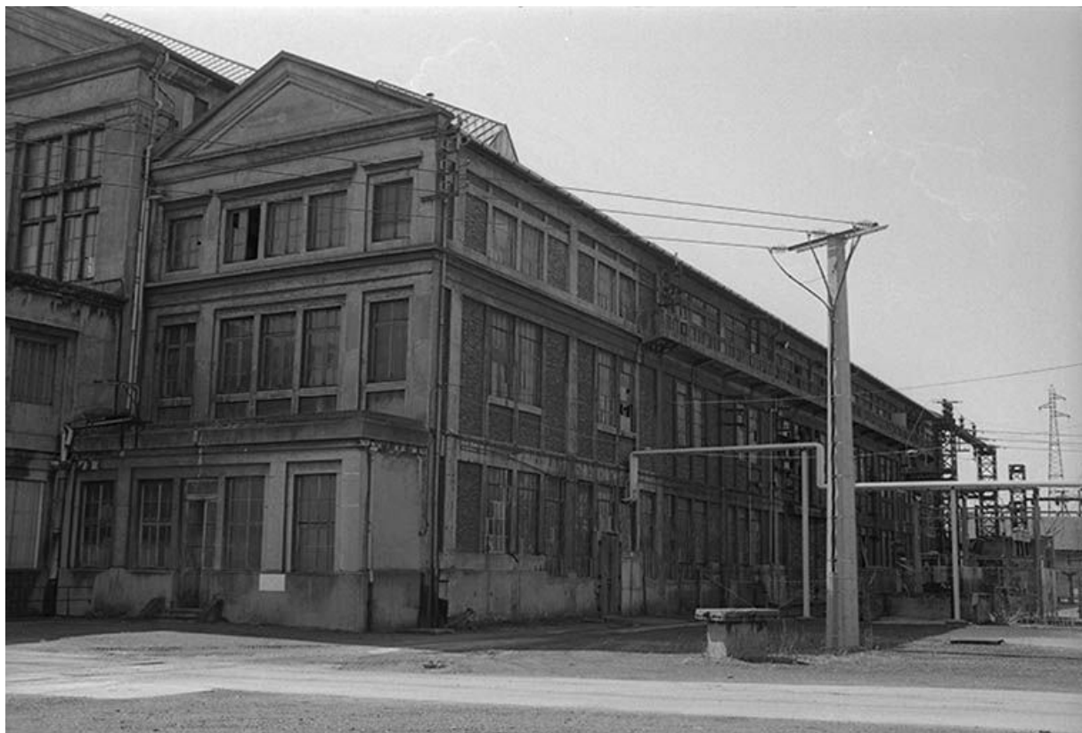
Le bâtiment des tableaux de distribution vu depuis l'est.
