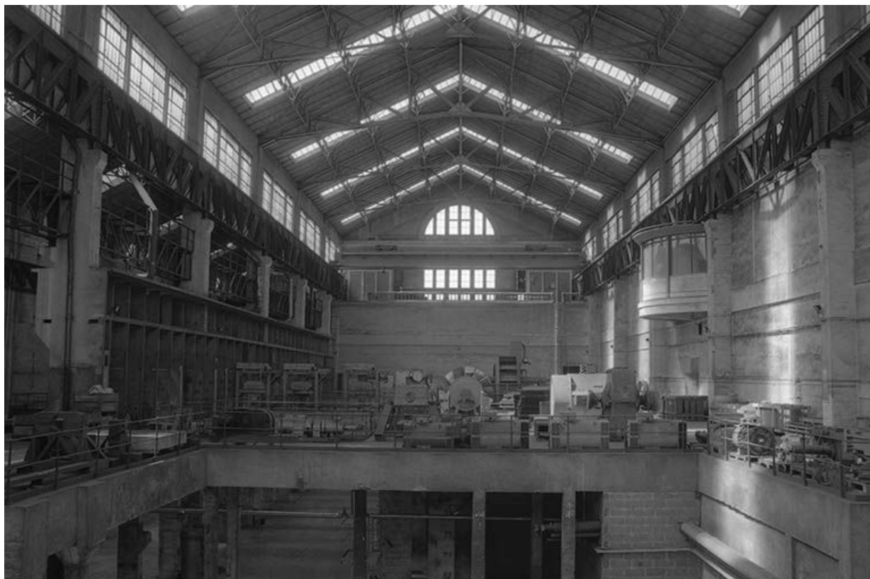
Pignon nord-ouest de la salle des machines vu depuis l'ancienne plate-forme des turboalternateurs. 71, Montceau-les-Mines, 20 quai de Moulins
