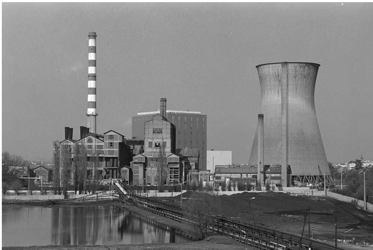
Les chaufferies de la centrale thermique de Lucy II photographiées depuis l'estacade de rebroussement du Lavoir des Chavannes (an arrière plan : cheminée, salle des machines et tour de réfrigération de Lucy III).
