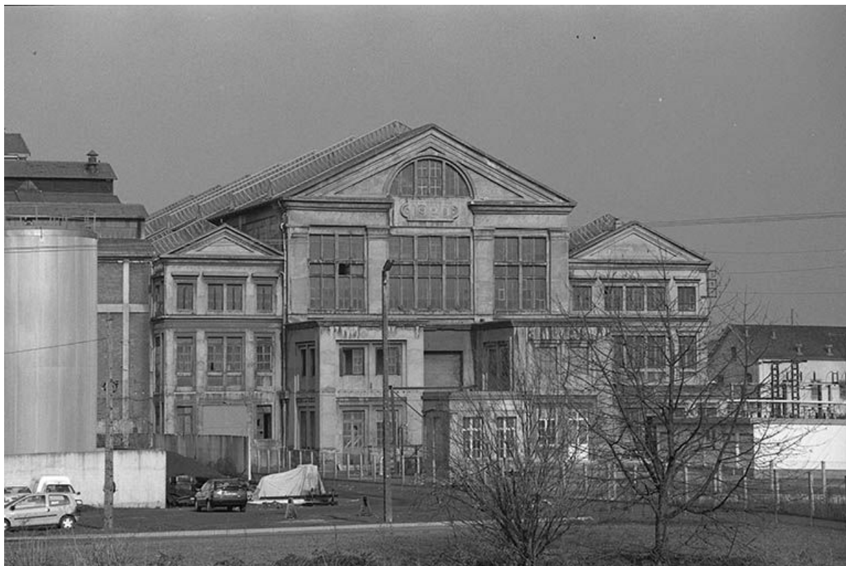
Façade antérieure de la centrale thermique de Lucy II vue depuis le canal du Centre. 71, Montceau-les-Mines, 20 quai de Moulins
