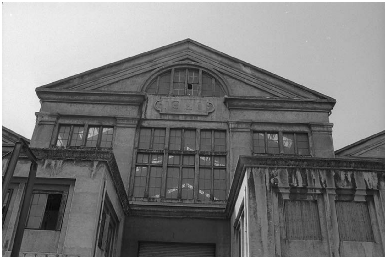
Détail de la façade de la centrale thermique de Lucy II.
