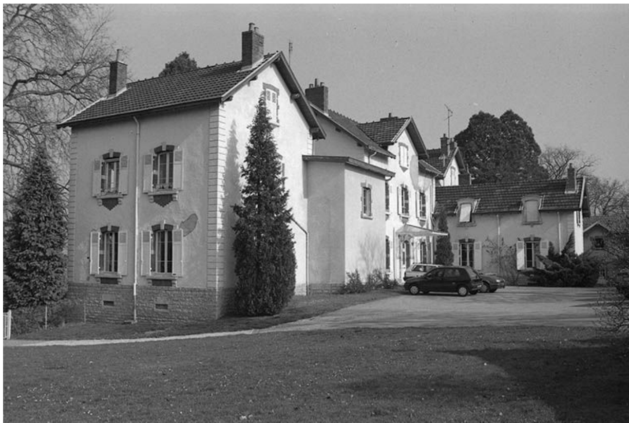
Façade antérieure du logement du directeur, vue du sud ouest.
