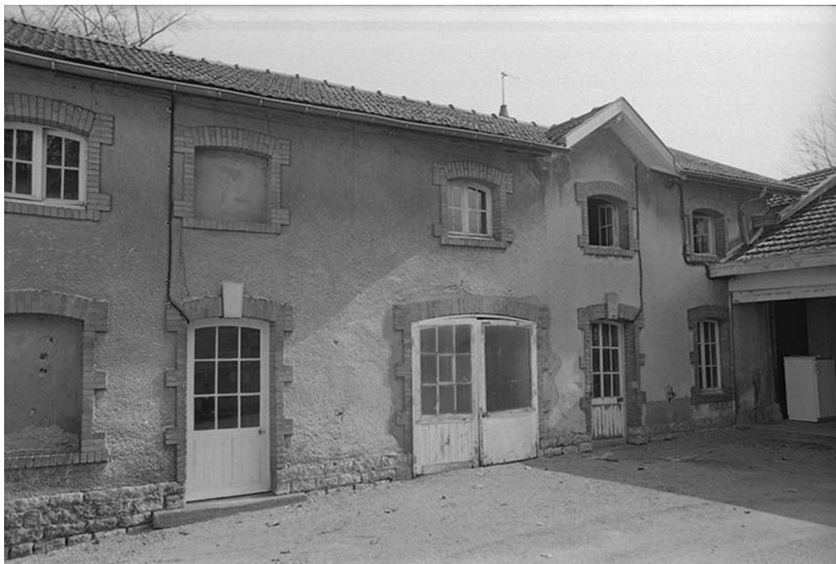
Bâtiment de la chaufferie (entrée) et des écuries, vu de l'ouest.
