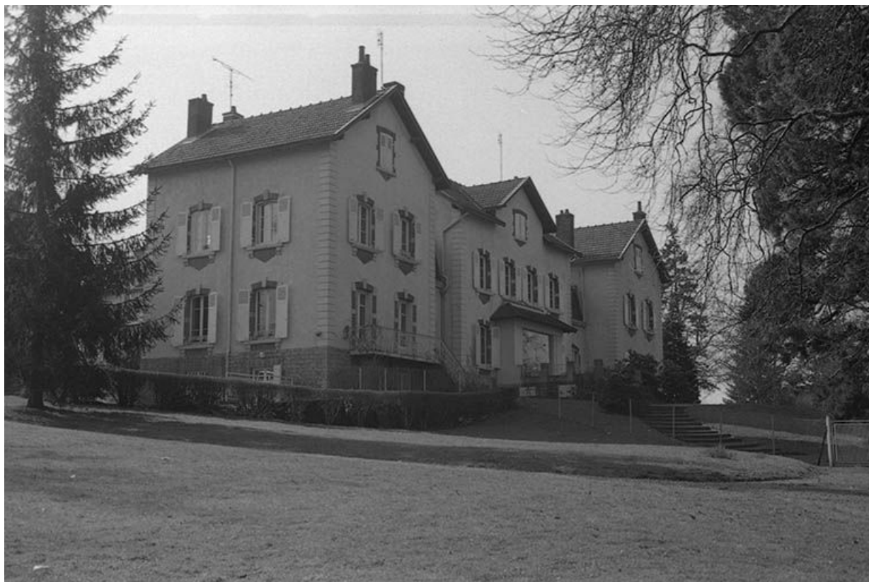
Façade postérieure du logement du directeur, vue du nord. 71, Montceau-les-Mines, 70 à 72 rue des Rompois
