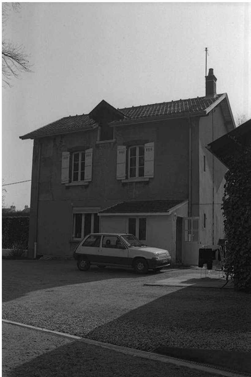
Logement du chauffeur, vu du nord ouest.
