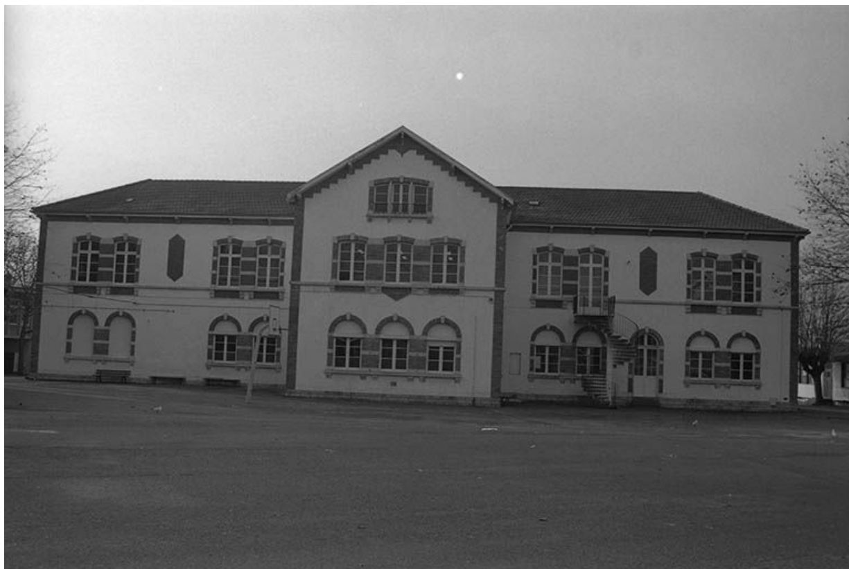
Façade postérieure de l'ancienne école de filles de l'hôpital.
