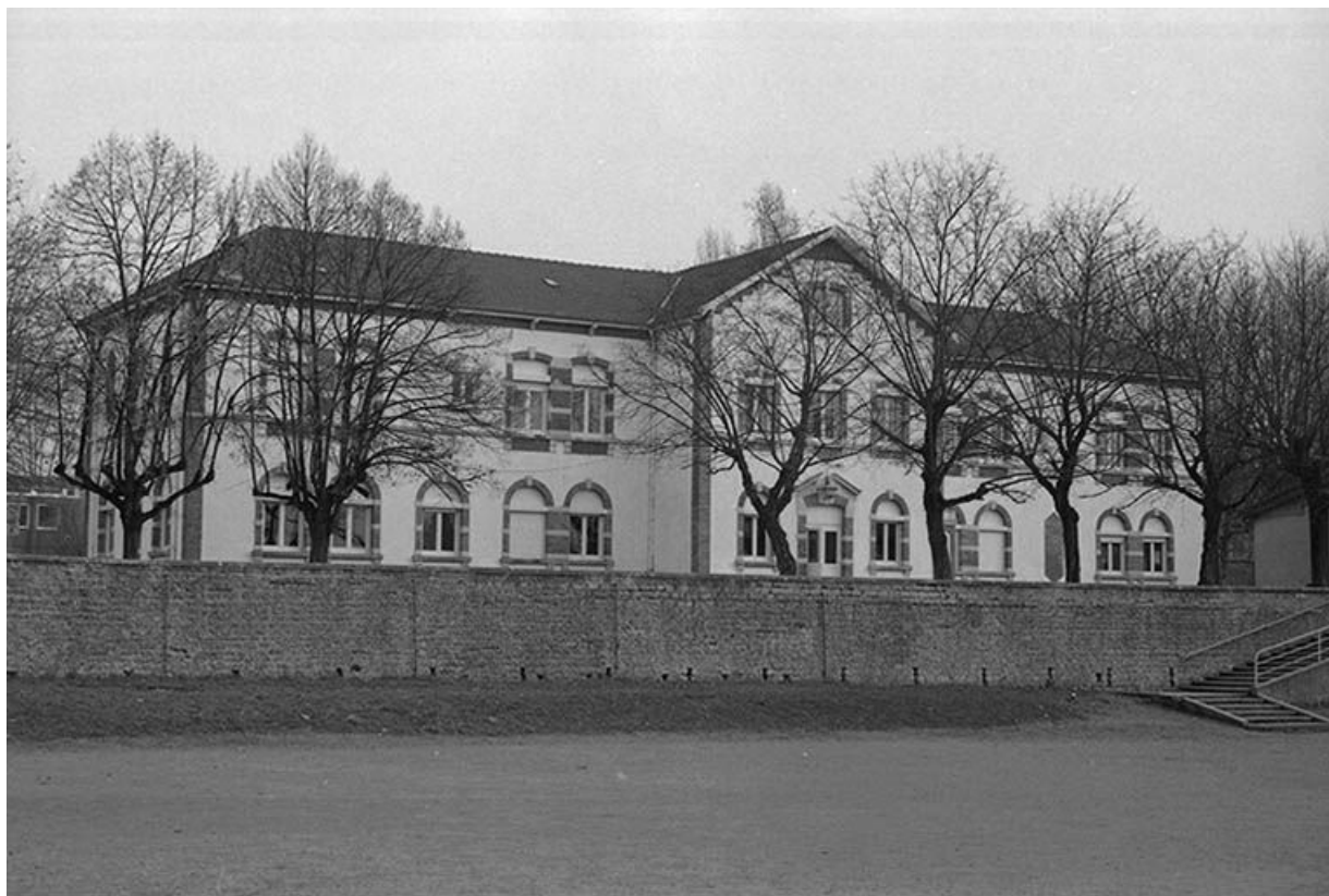
Façade antérieure de l'ancienne école de filles de l'hôpital.
