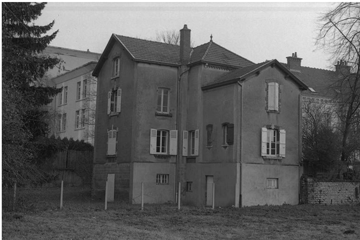
Salles de réunion , vues de l'Ouest.
