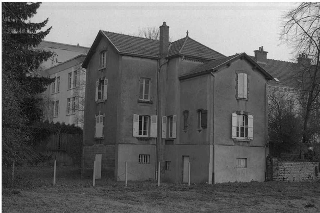
Salles de réunion , vues de l'Ouest.
