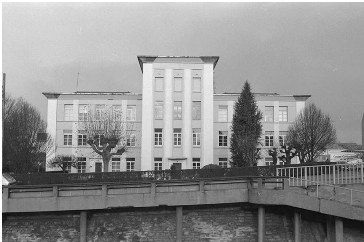
Façade antérieure de l'école de garçons de la 9ème écluse, actuel siège de la Direction Départementale de l'Equipement. 71, Montceau-les-Mines, 2-8 quai Jules Chagot
