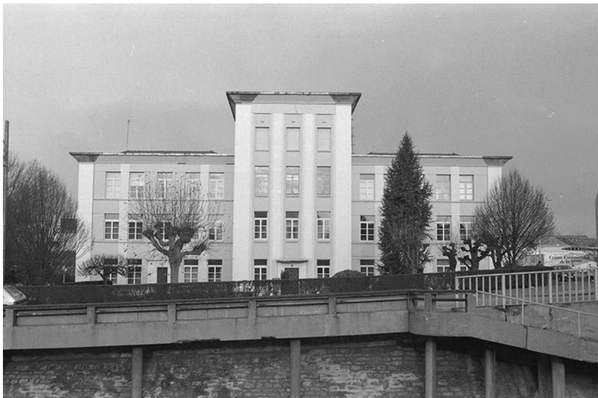
Façade antérieure de l'école de garçons de la 9ème écluse, actuel siège de la Direction Départementale de l'Équipement. 71, Montceau-les-Mines, 2-8 quai Jules Chagot
