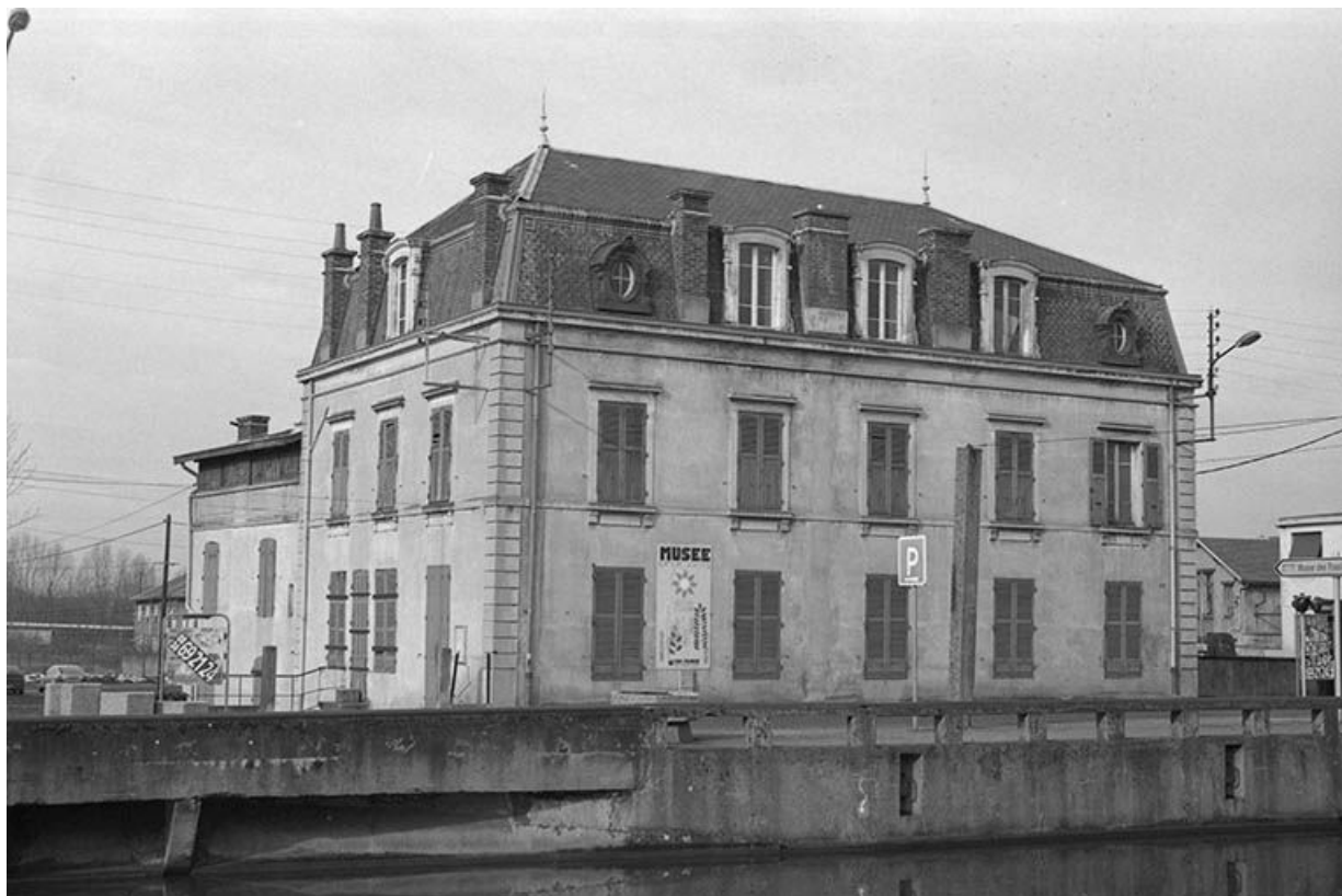
Logement d'ingénieur construit en 1847-50 : vue d'ensemble.
