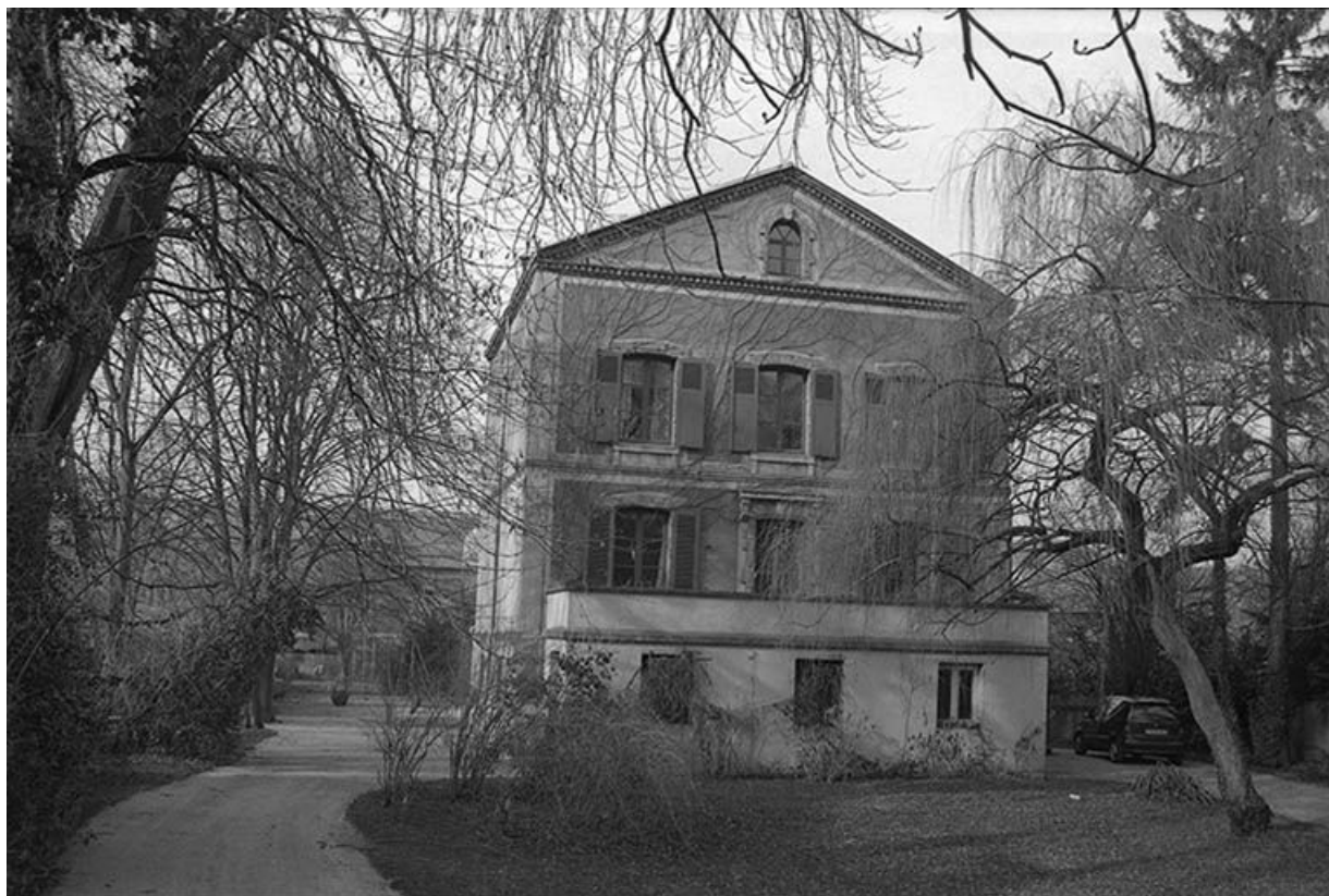
Logement du secrétaire général, construit vers 1870-75 : vue d'ensemble.
