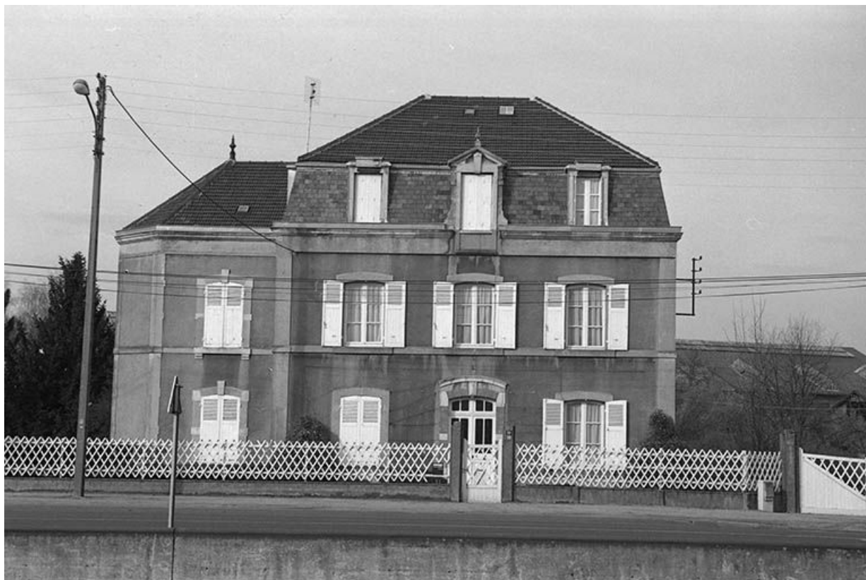
Logement du directeur commercial ou de l'architecte, construit vers 1865 : vue d'ensemble.
