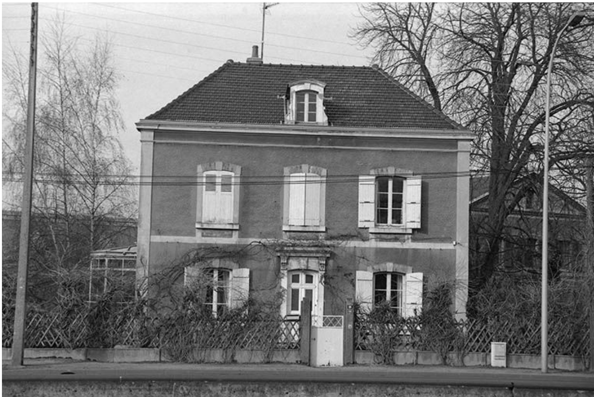
Logement du directeur commercial ou de l'architecte, construit vers 1865 : vue d'ensemble. 71, Montceau-les-Mines, 76-90 quai Jules Chagot
