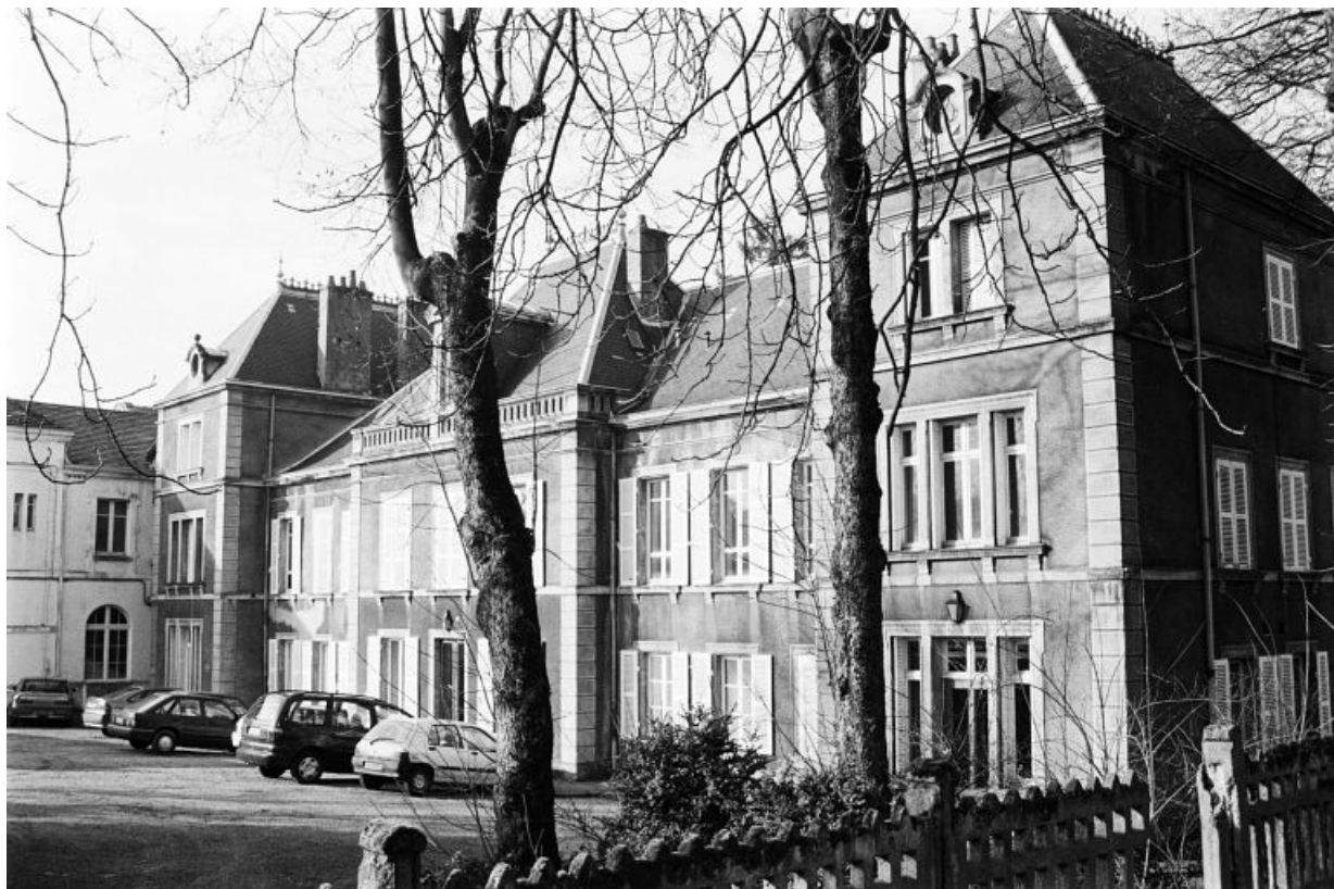
Façade antérieure de la " maison d'administration ".
