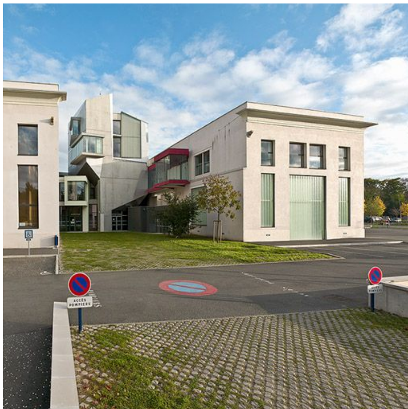
Vue extérieure, façade postérieure.
