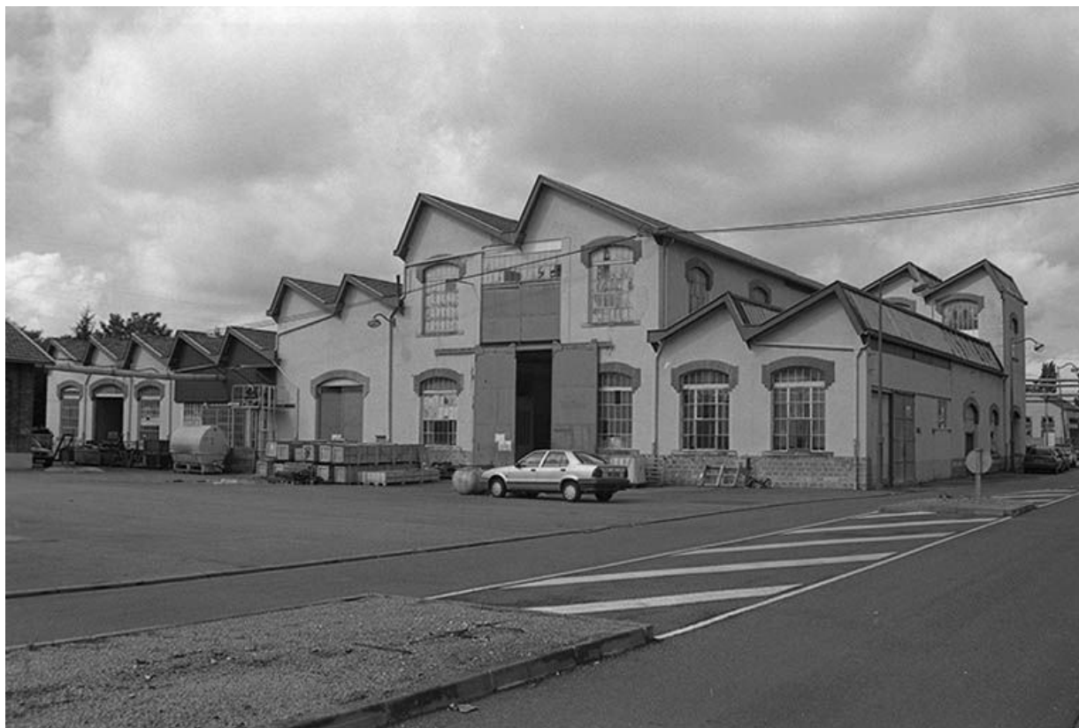
Fonderie (construite en 1928), vue du Sud Est.
