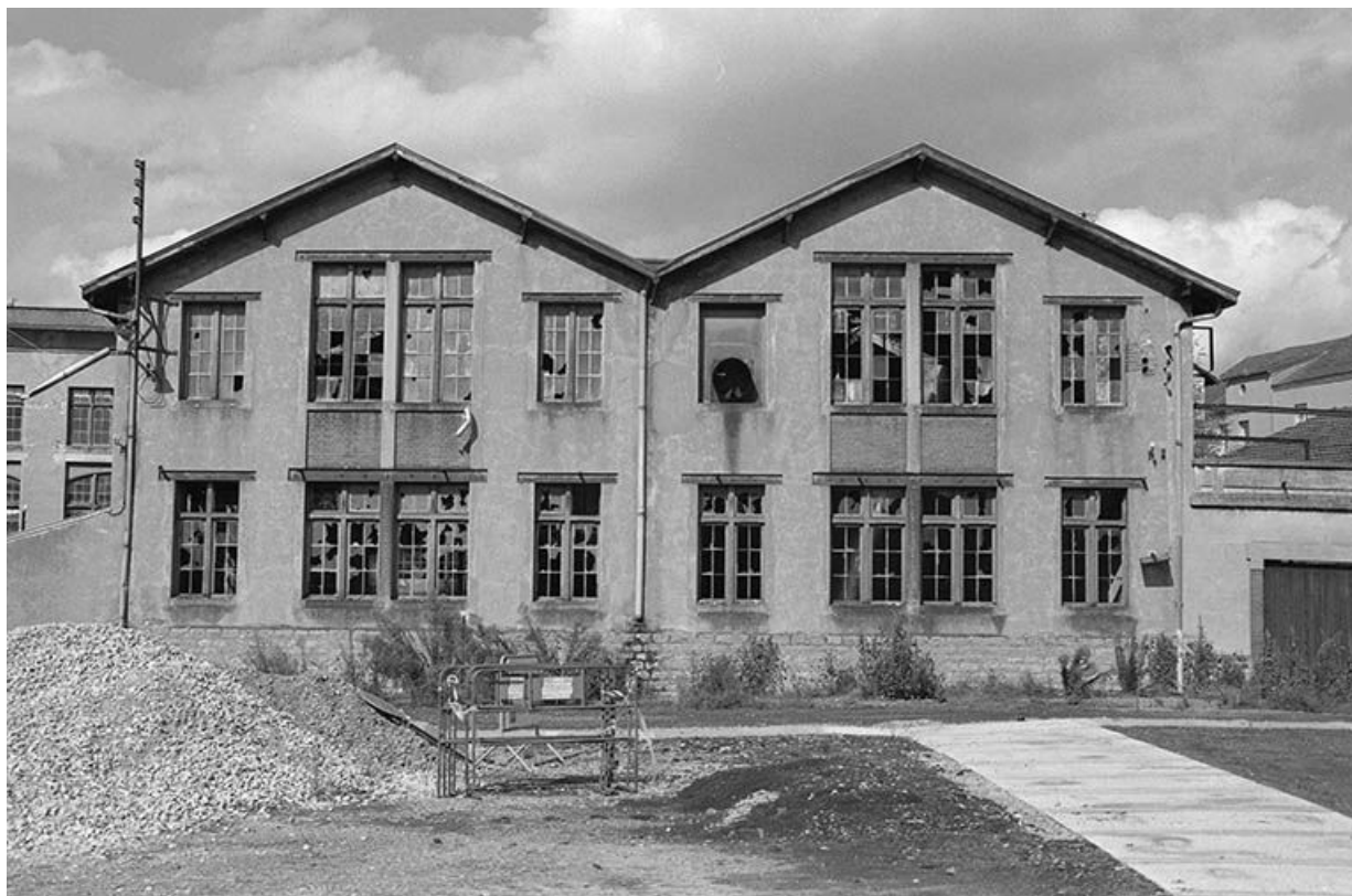
Atelier de perforation puis d'ajustage (construit en 1908-18), pignon Sud. 71, Montceau-les-Mines quai Jules Chagot, lieudit : le Montceau
