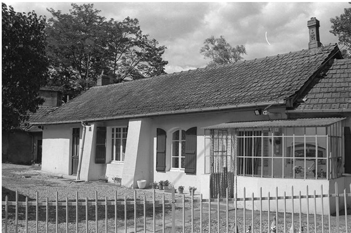
Anciens logements ouvriers (?) vus du Sud Est, façade antérieure.
