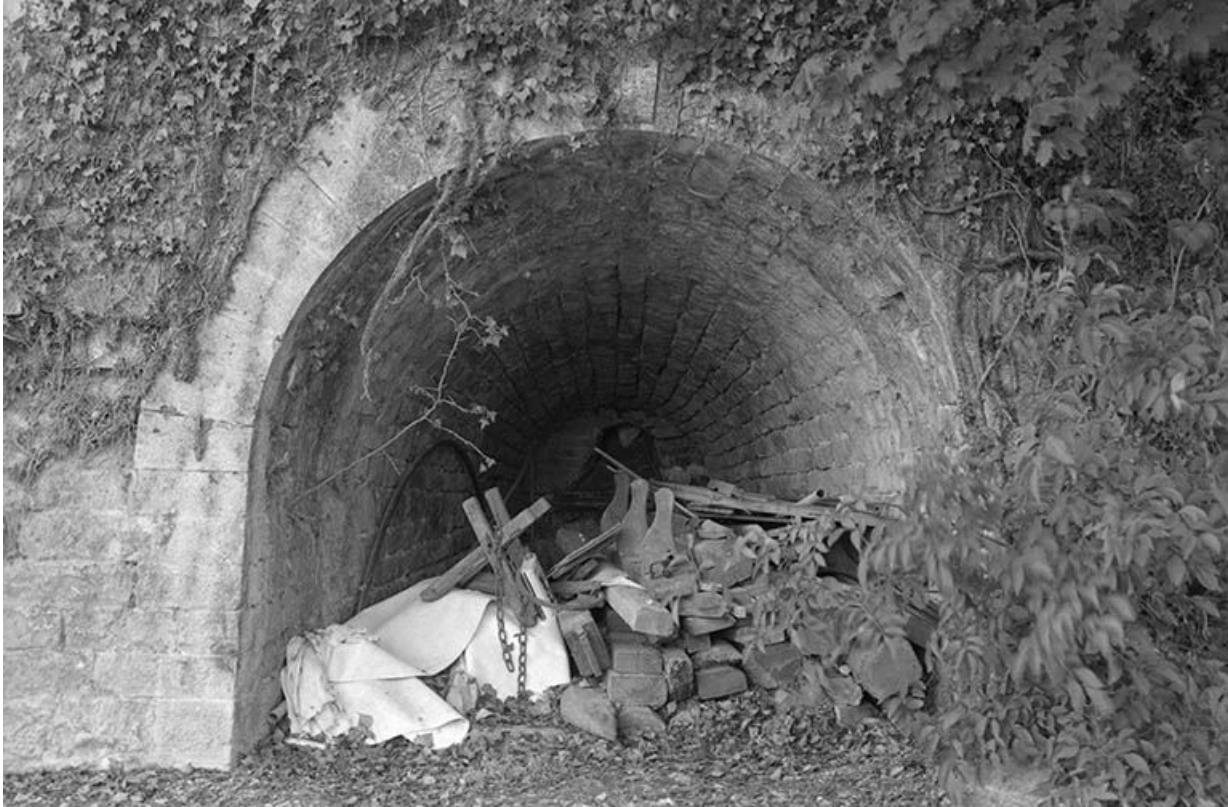
Orifice d'enfournement Nord du four à chaux de 1858. 71, Blanzly, 23.25 route de Montchanin, lieudit : la Plaine
