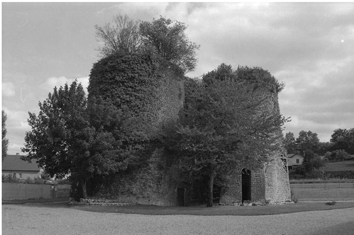
Fours à chaux de 1870 (à droite) et de 1858 (à gauche), vus du Nord Ouest.
