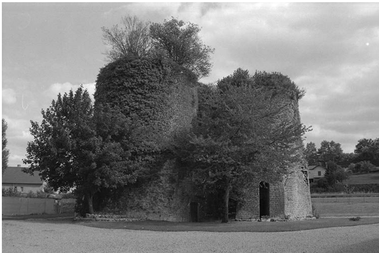
Fours à chaux de 1870 (à droite) et de 1858 (à gauche), vus du Nord Ouest.
