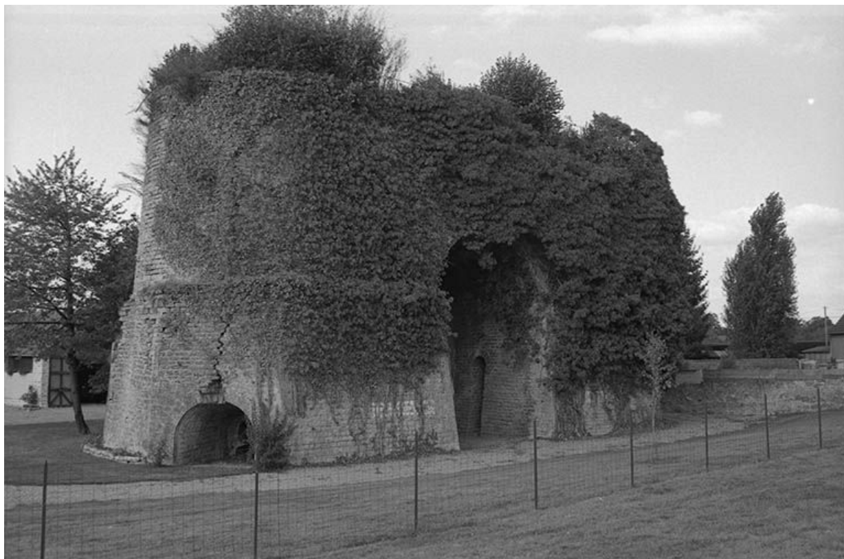
Fours à chaux de 1870 reliés par une arche donnant accès à l'orifice de défournement Sud du four de 1858.
