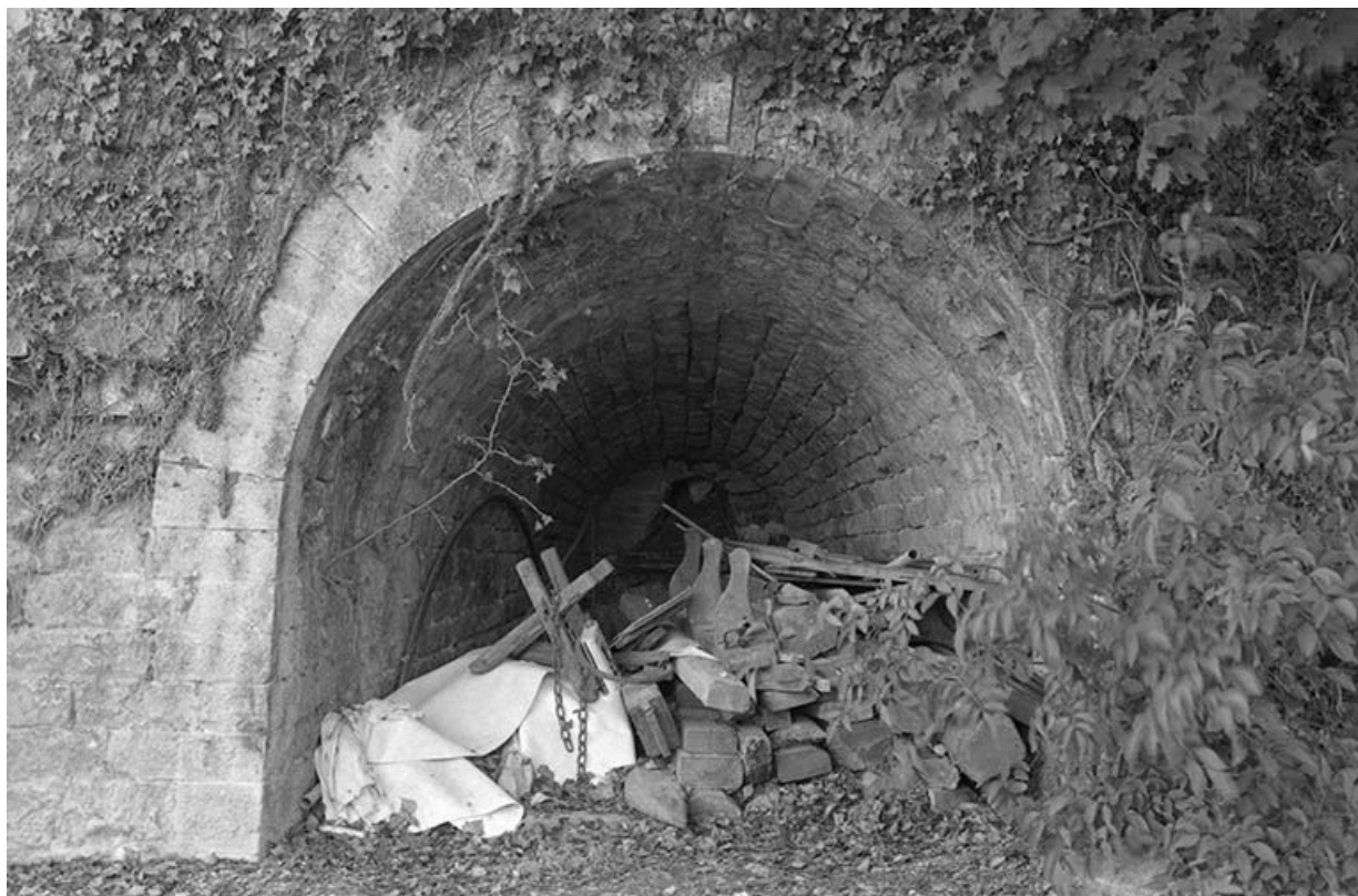
Orifice d'enfournement Nord du four à chaux de 1858.
