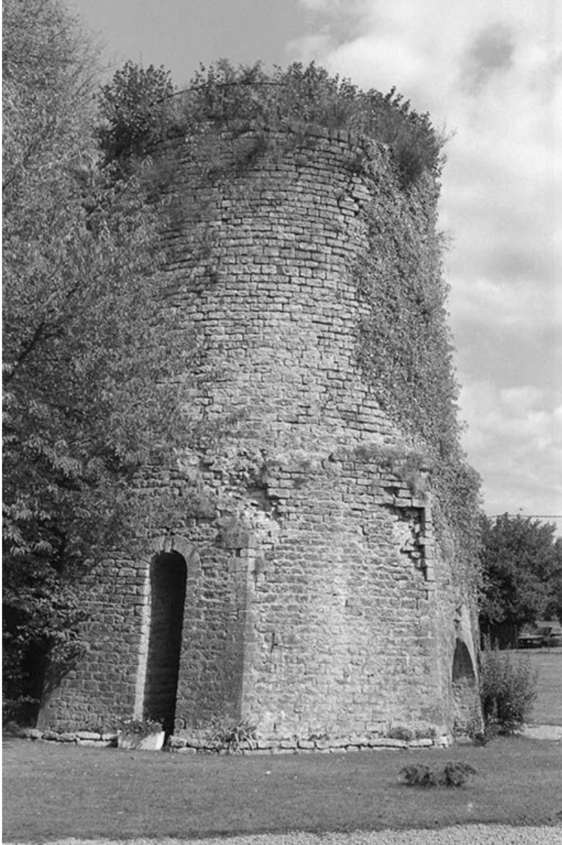
Le four à chaux de 1858 vu du Nord Est.
