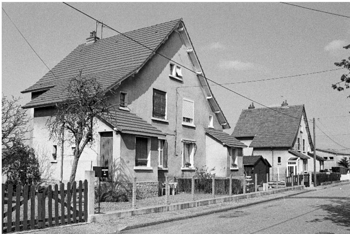
Bâtiment à logements " type 14 ", 1939-1945.
