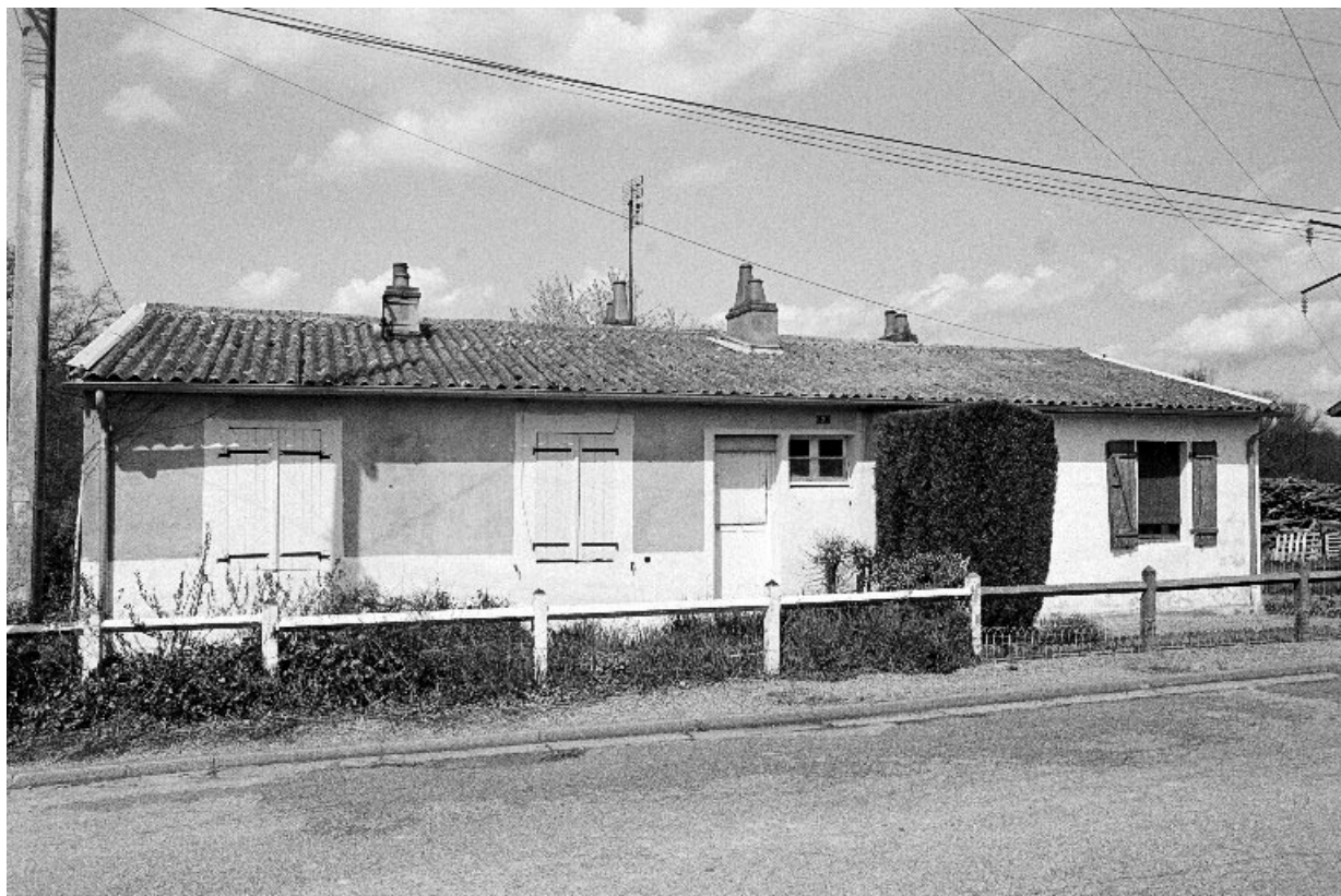
Bâtiment à 3 logements " type R ", 1939-1945.
