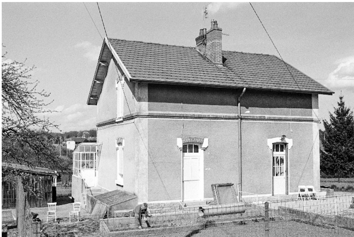
Bâtiment à 2 logements " type 8 ", 1938-1939.
