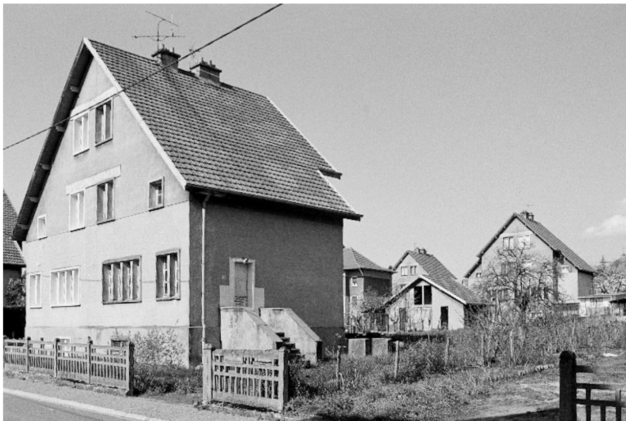
Bâtiment à 2 logements " type 16 " à meneaux, 1946-1948.
