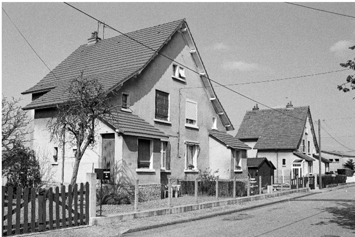
Bâtiment à logements " type 14 ", 1939-1945. 71, Ciry-le-Noble, lieudit : Rozelay
