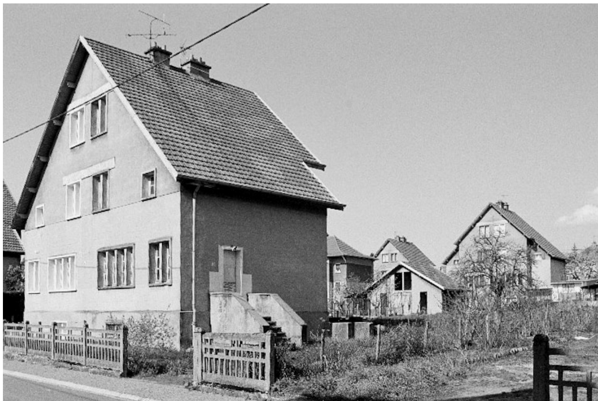
Bâtiment à 2 logements " type 16 " à meneaux, 1946-1948.
