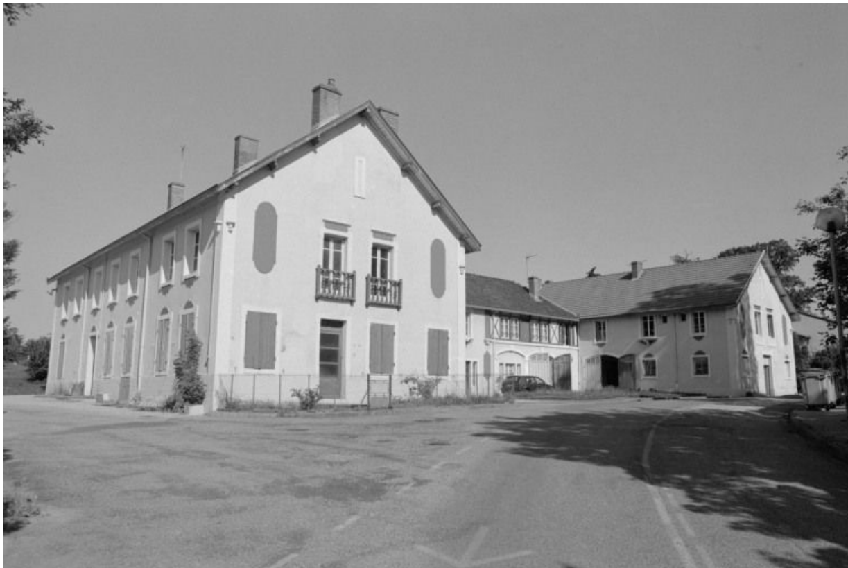
Logement des domestiques et écurie du Château de Galuzot (bâtiment d'administration et écuries de 1837-40 transformés en 1859-63).
