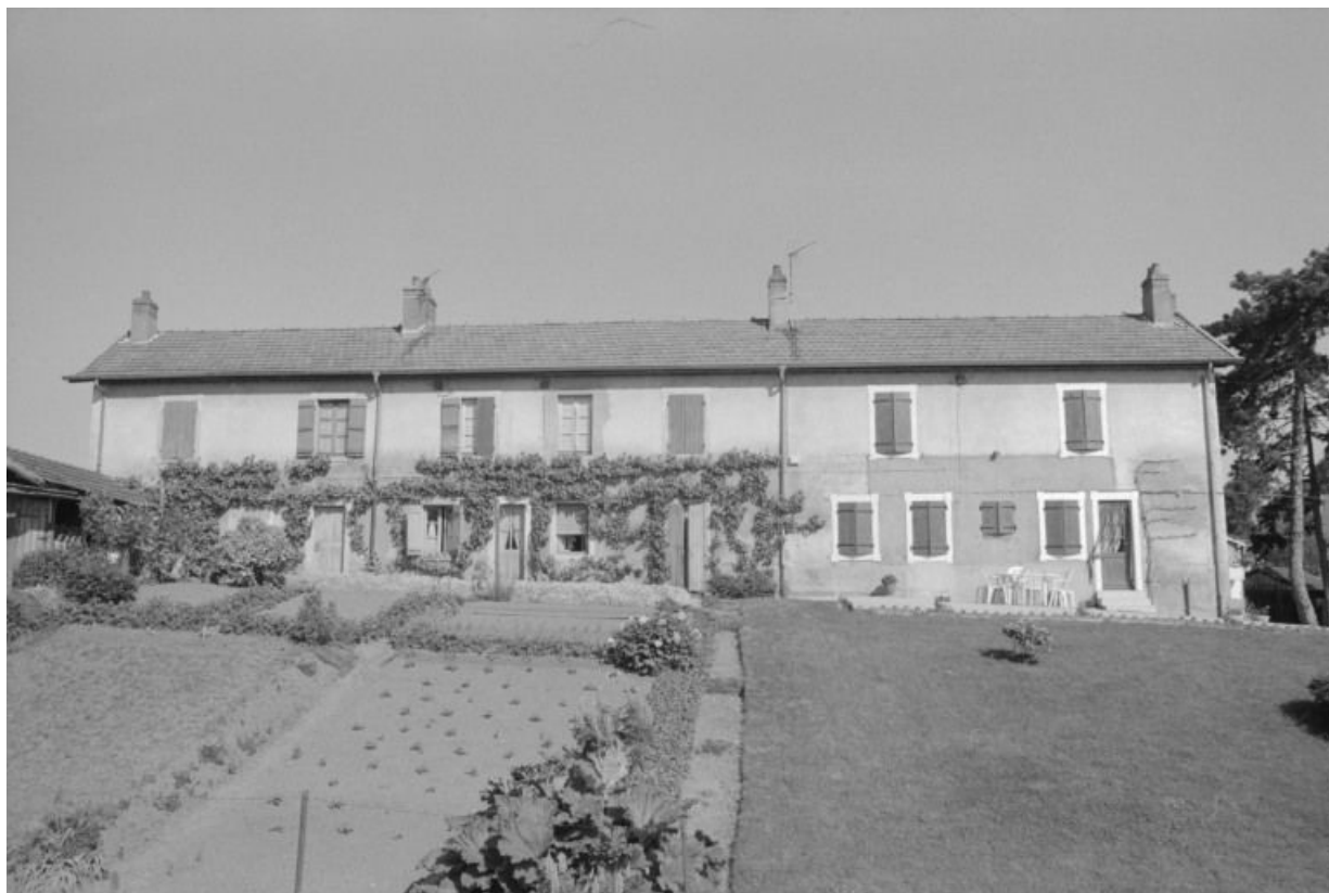
Ferme du Château de Galuzot (anciens logements ouvriers des années 1830 transformés vers 1860 - façade Sud). 71, Saint-Vallier, lieudit : l' Hospice
