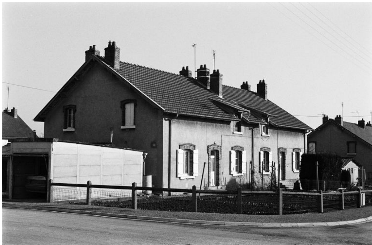
Habitation à quatre logements de quatre pièces de "type 1" (1913).
