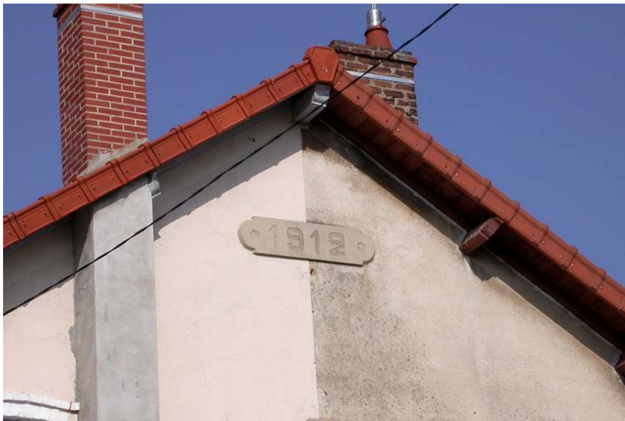
Détail d'un pignon de maison jumelée, porte la date.
