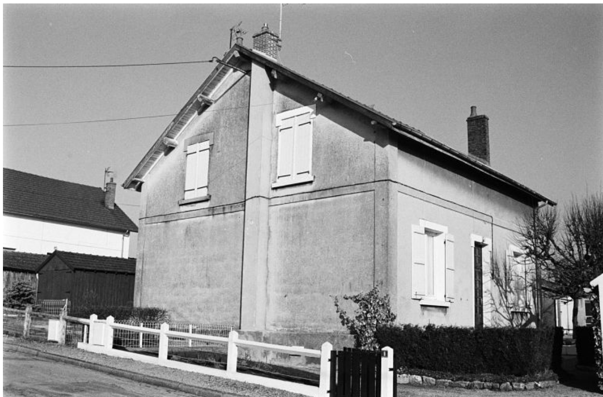
Habitation à deux logements de quatre pièces de " type 3 " (1920-21). 71, Sanvignes-les-Mines, lieudit : les Essarts
