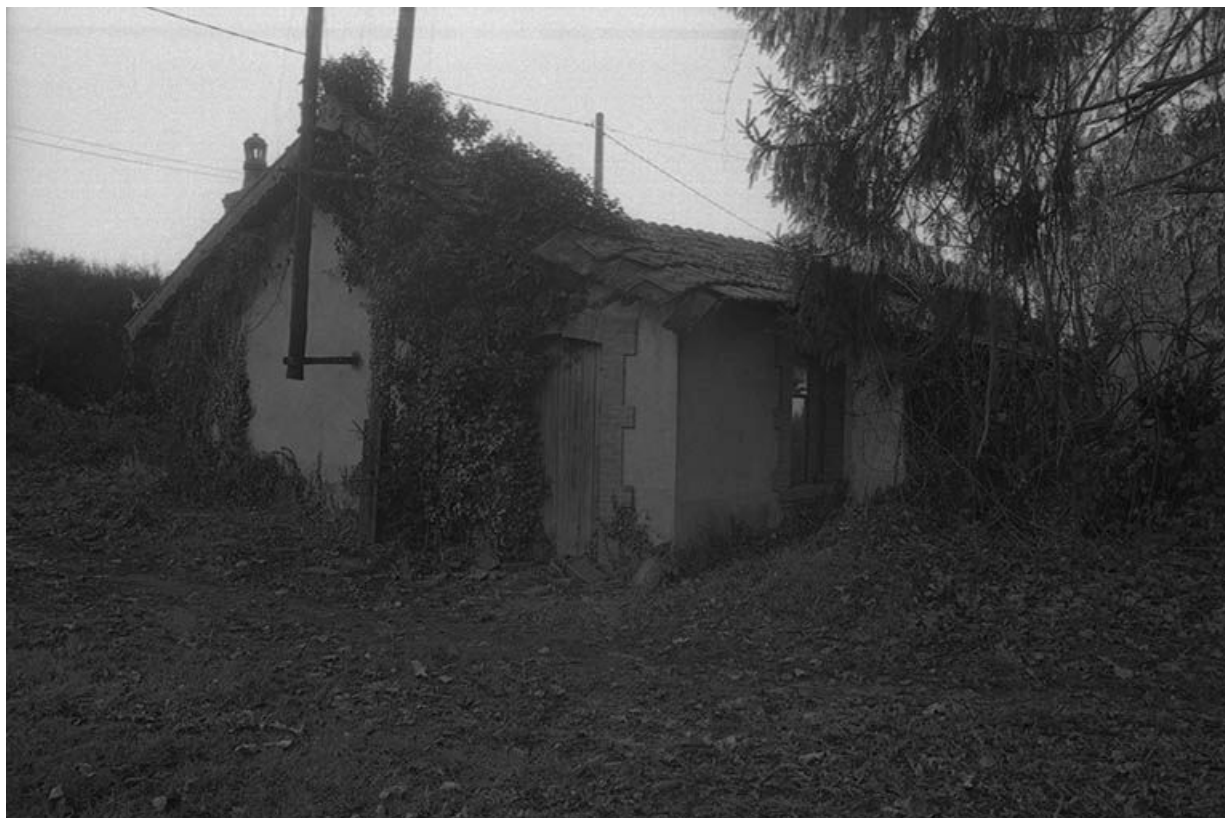
Le bâtiment d'eau abritant turbine et générateur, vu du nord-est.
