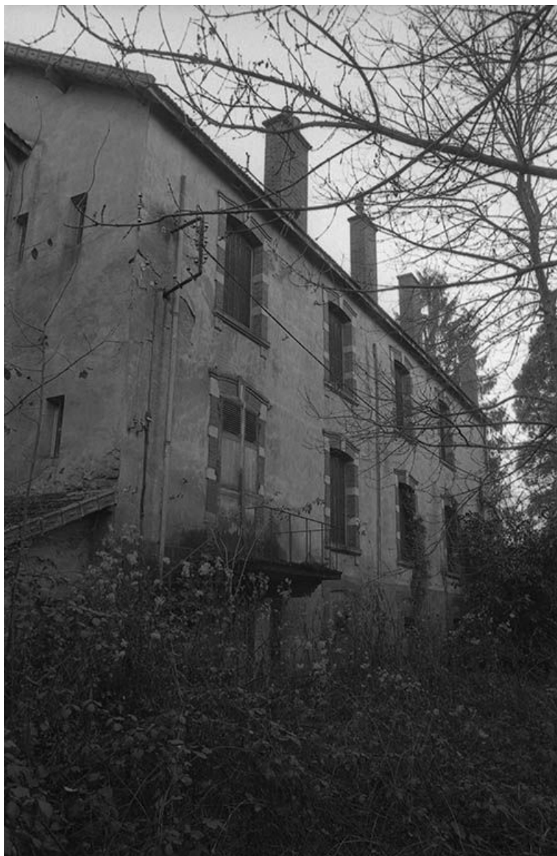
L'ancien bâtiment des fours et séchoirs, transformé en habitation Façade postérieure, vue du nord-est. 71, Ciry-le-Noble, lieudit : Les Touillards
