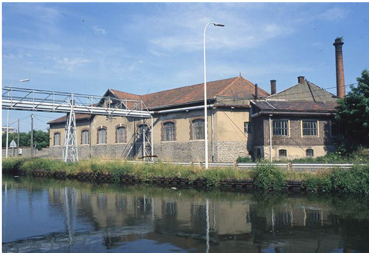
Façade postérieure de l'atelier d'ajustage et de tournage vue depuis les quais. 71, Montceau-les-Mines, 2 rue de Gilly
