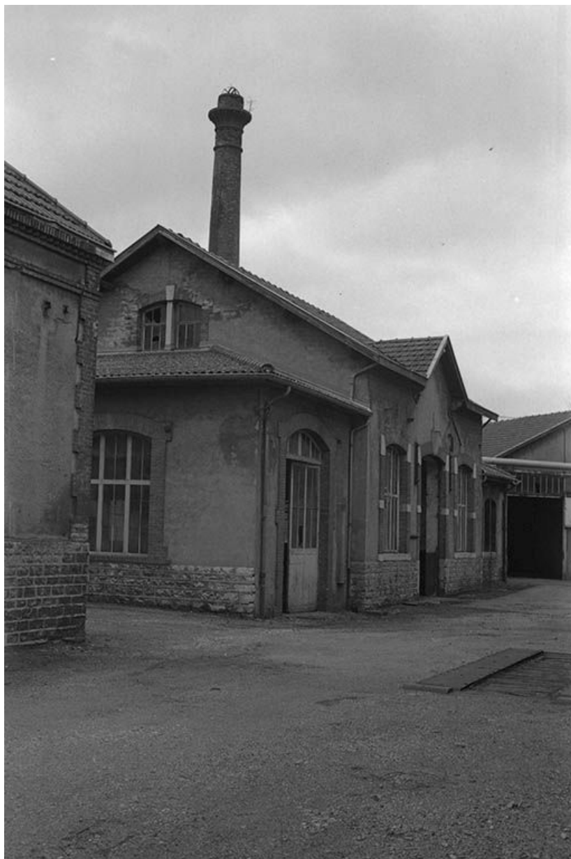
Façade antérieure de l'atelier de montage.
