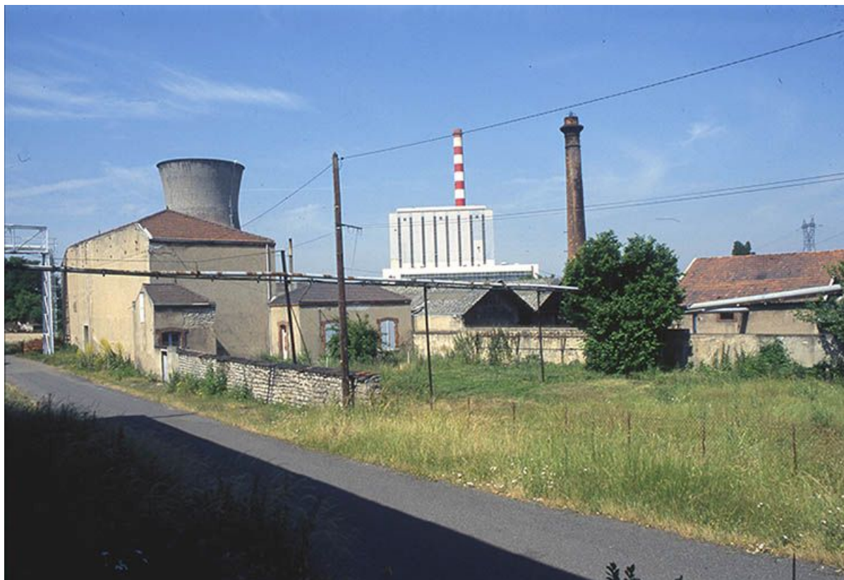
Le site des Ateliers de Constructions mécaniques Aillot vu depuis la rue des Prés. 71, Montceau-les-Mines, 2 rue de Gilly
