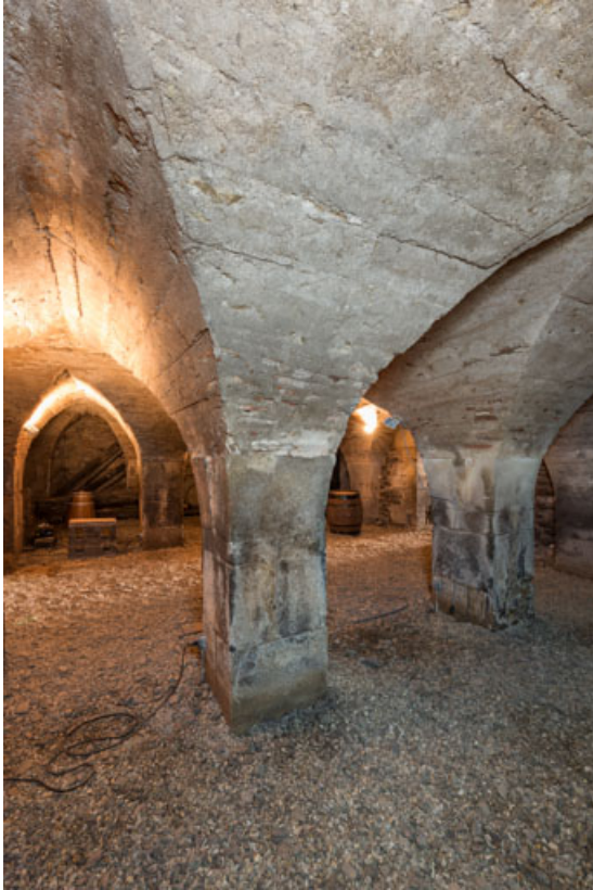
Pavillon occidental : cave à l'étage de soubassement. 71, Sully, 4 rue du Château
