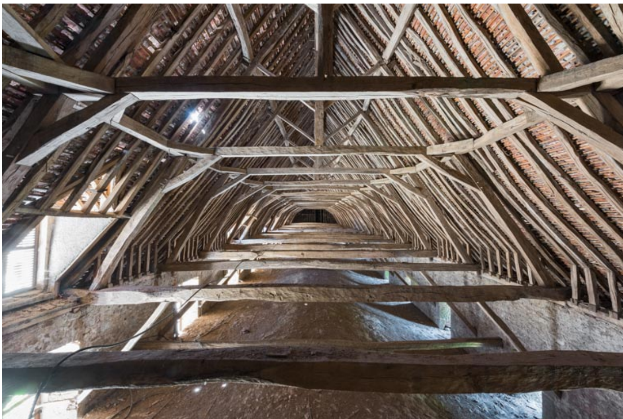
Ecurie, étage de comble : charpente.
