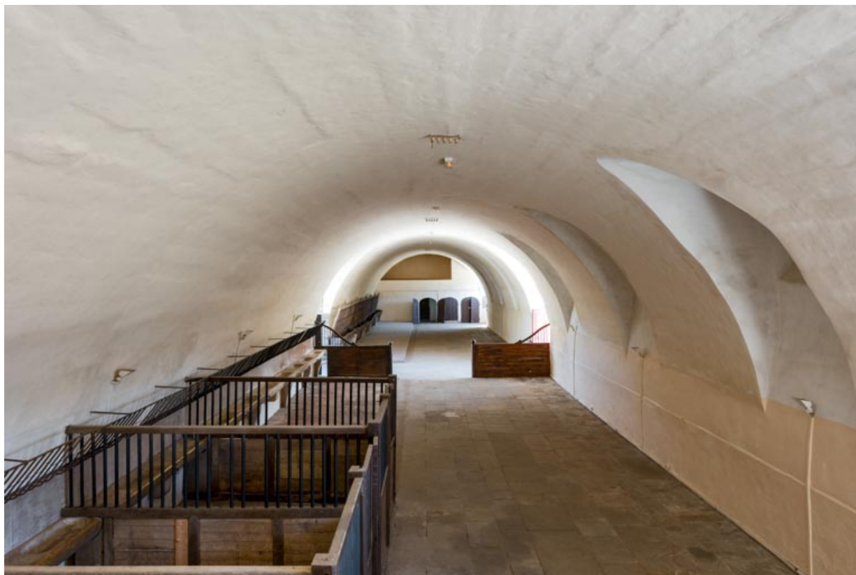
Ecurie : la voûte depuis la tribune occidentale.
