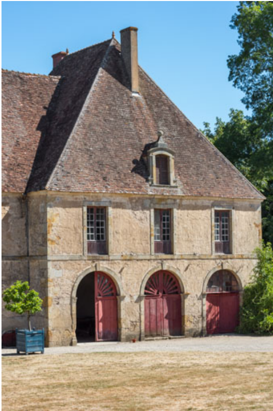
Façade antérieure : pavillon oriental (remises).
