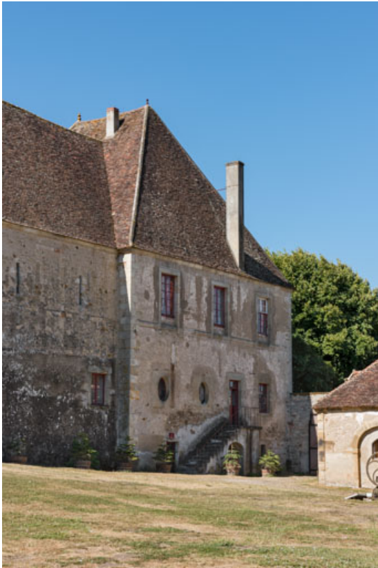
Façade postérieure : pavillon occidental.
