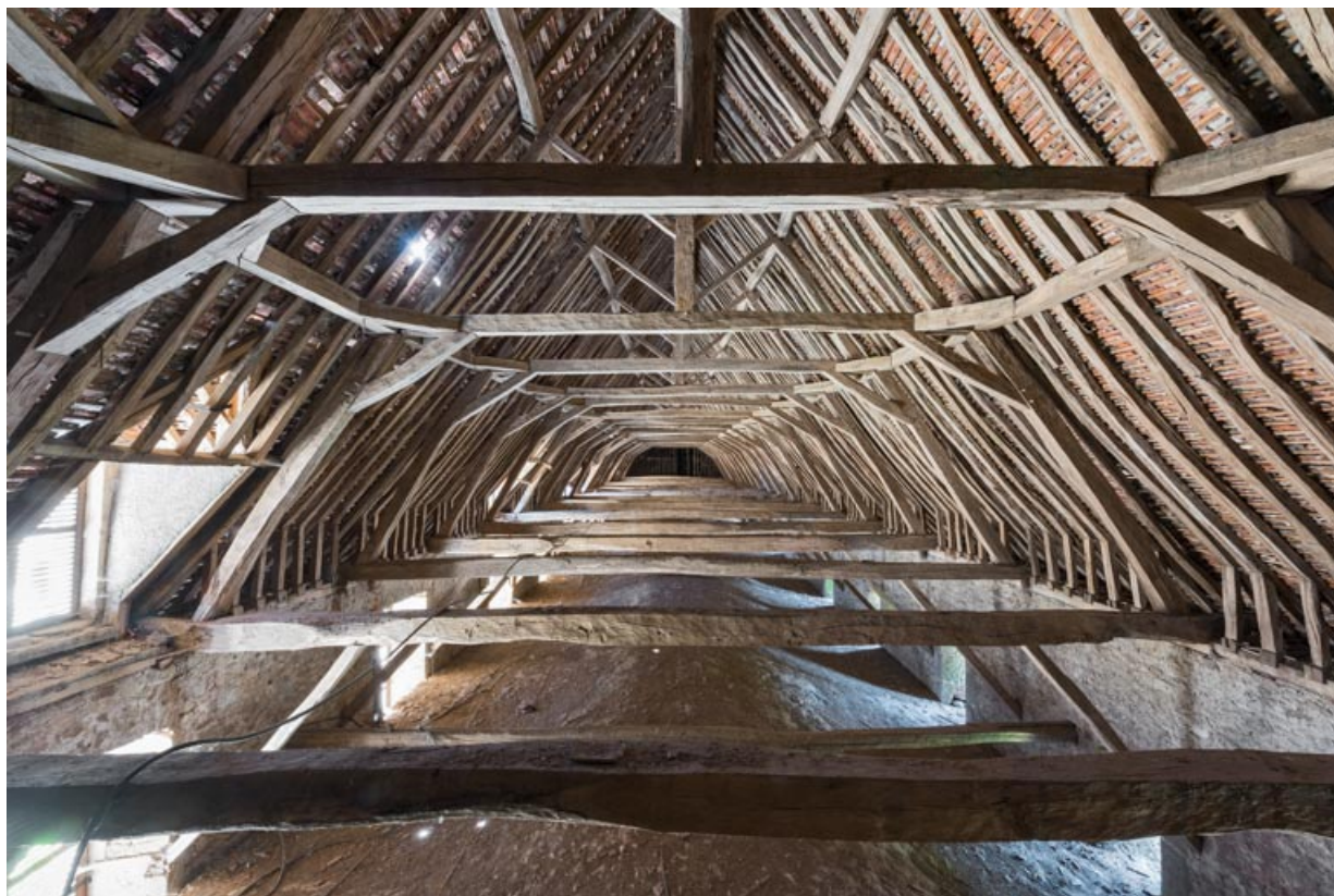
Ecurie, étage de comble : charpente.
