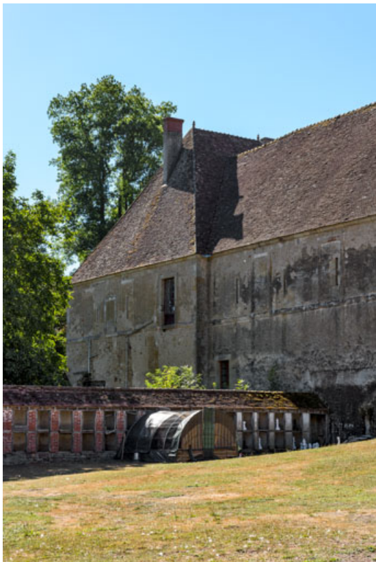
Façade postérieure : pavillon oriental.
