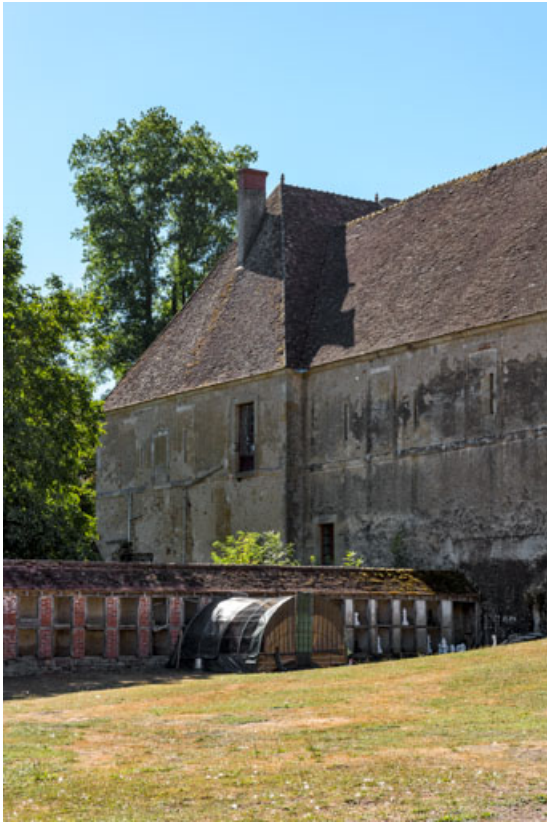
Façade postérieure : pavillon oriental.
