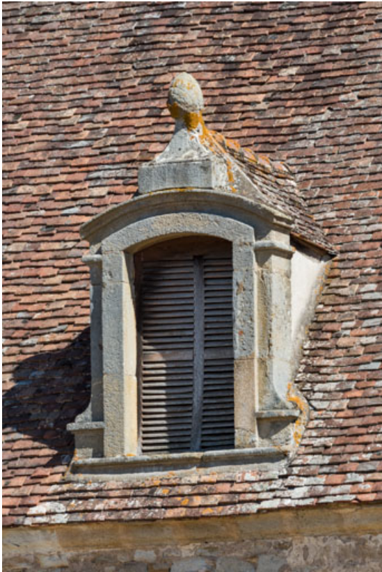
Façade antérieure : lucarne avec motif d'amortissement en pomme de pin. 71, Sully, 4 rue du Château
