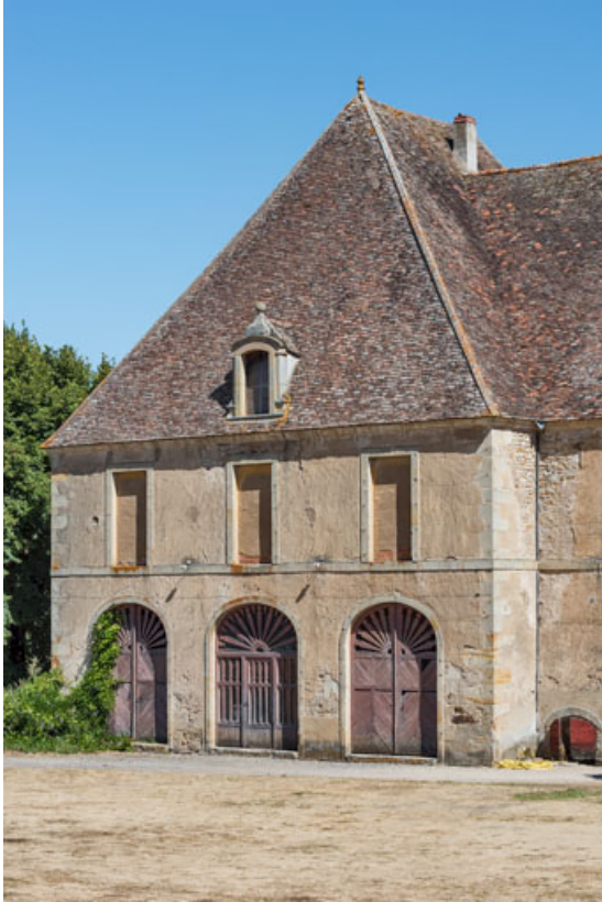
Façade antérieure : pavillon occidental (théâtre).
