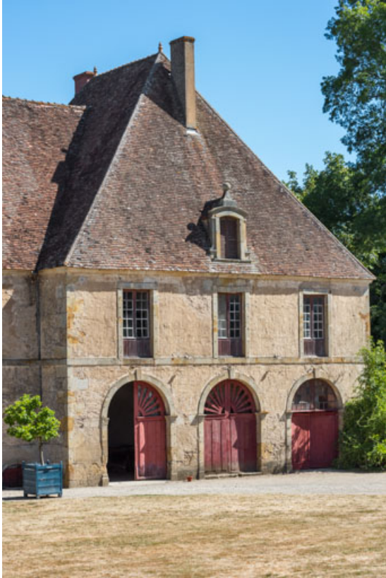
Façade antérieure : pavillon oriental (remises).
