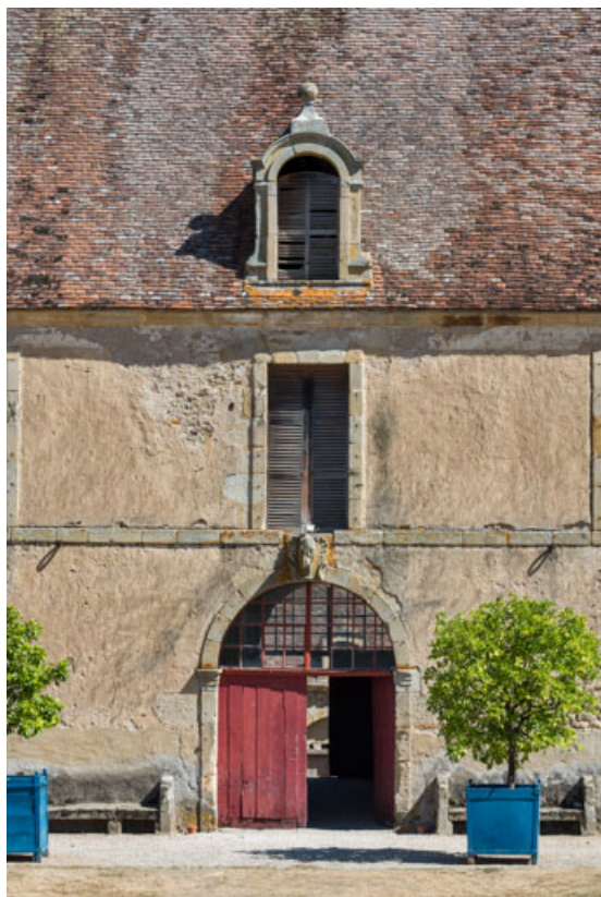
Façade antérieure : travée centrale.
