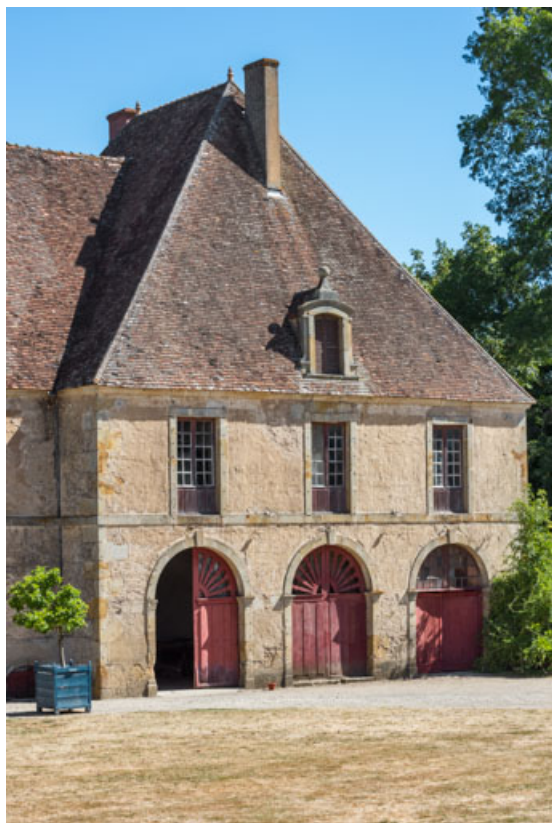
Façade antérieure : pavillon oriental (remises).
