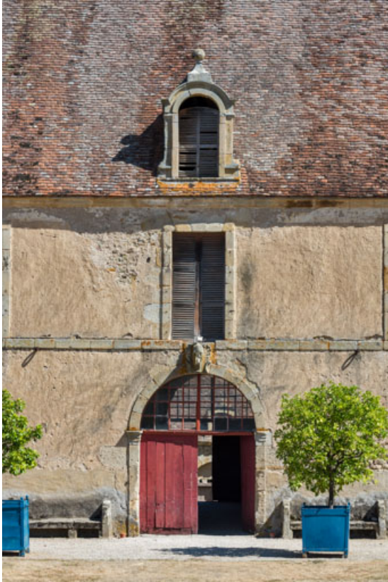
Façade antérieure : travée centrale.
