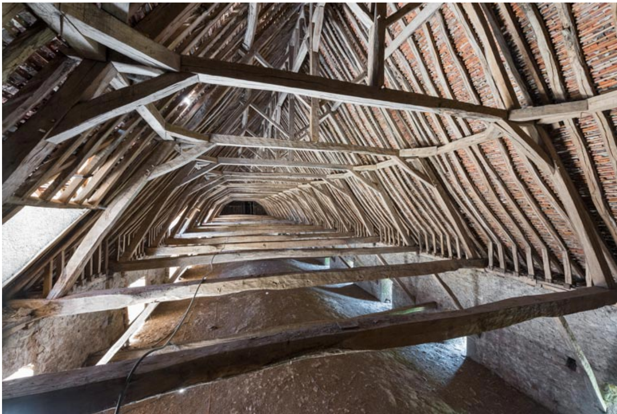
Ecurie, étage de comble : charpente, vue de trois quarts.
