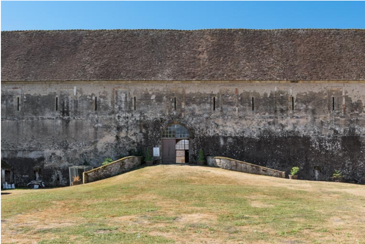
Façade postérieure : corps central.
