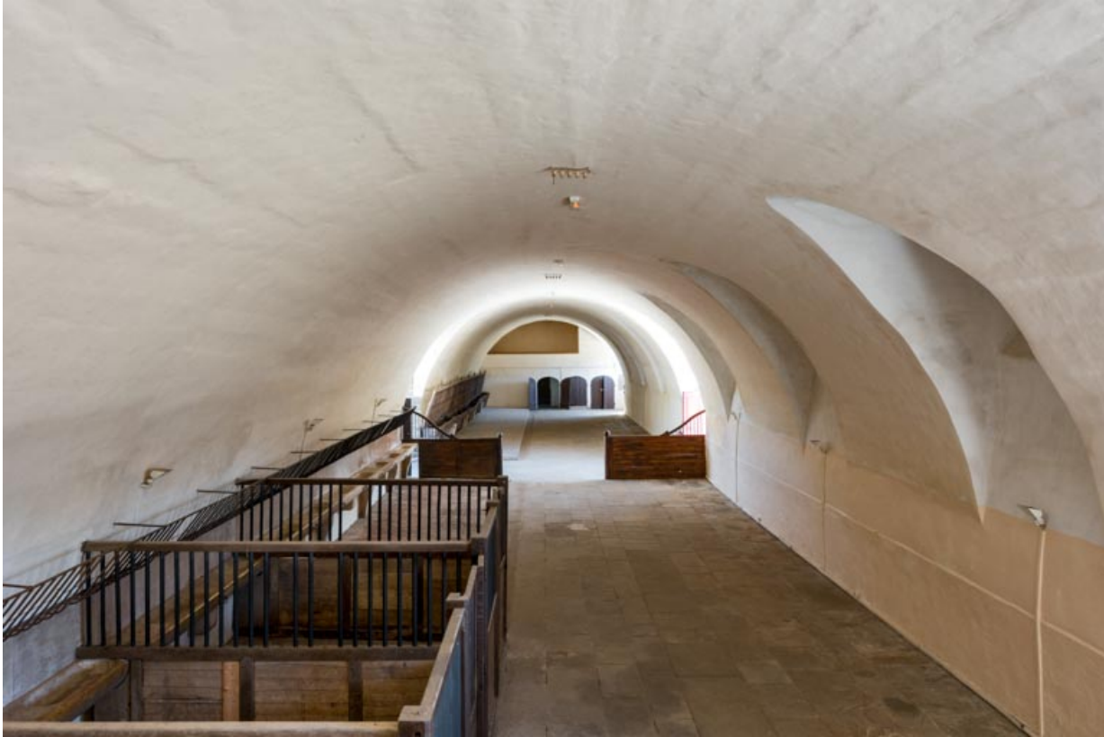
Ecurie : la voûte depuis la tribune occidentale.
