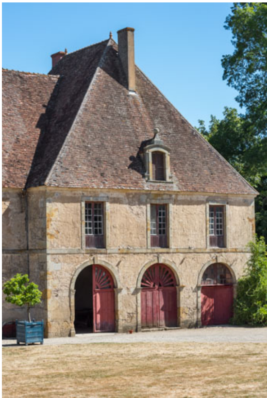
Façade antérieure : pavillon oriental (remises).
