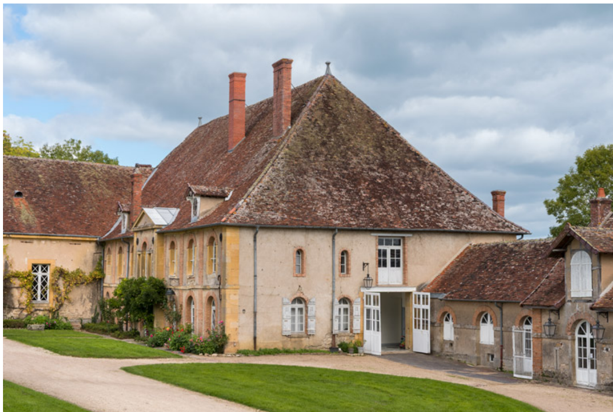
Façades antérieure et latérale droite.
