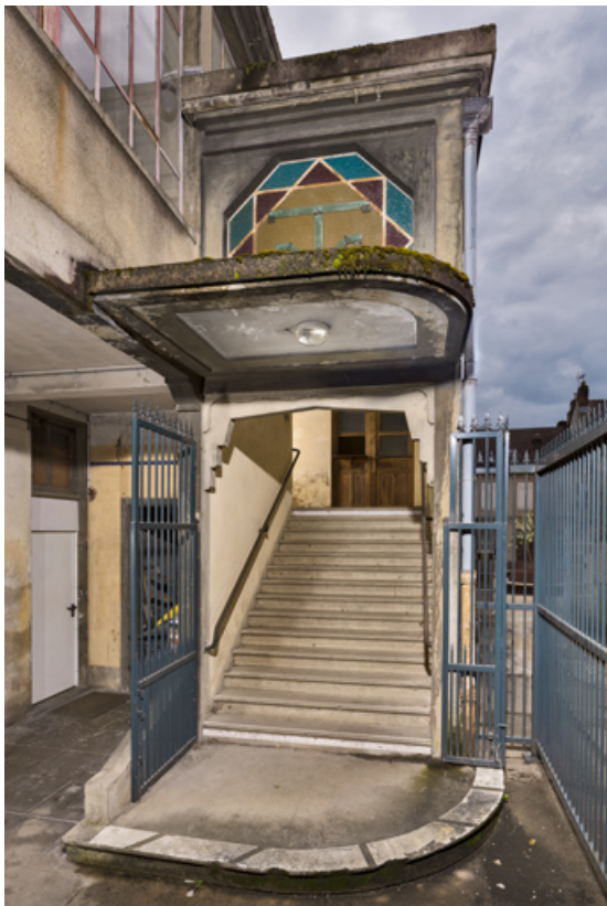
Cage de l'escalier principal.
