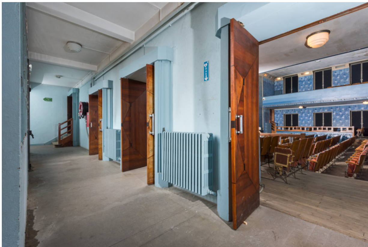
Galerie vitrée et entrée de la salle.
