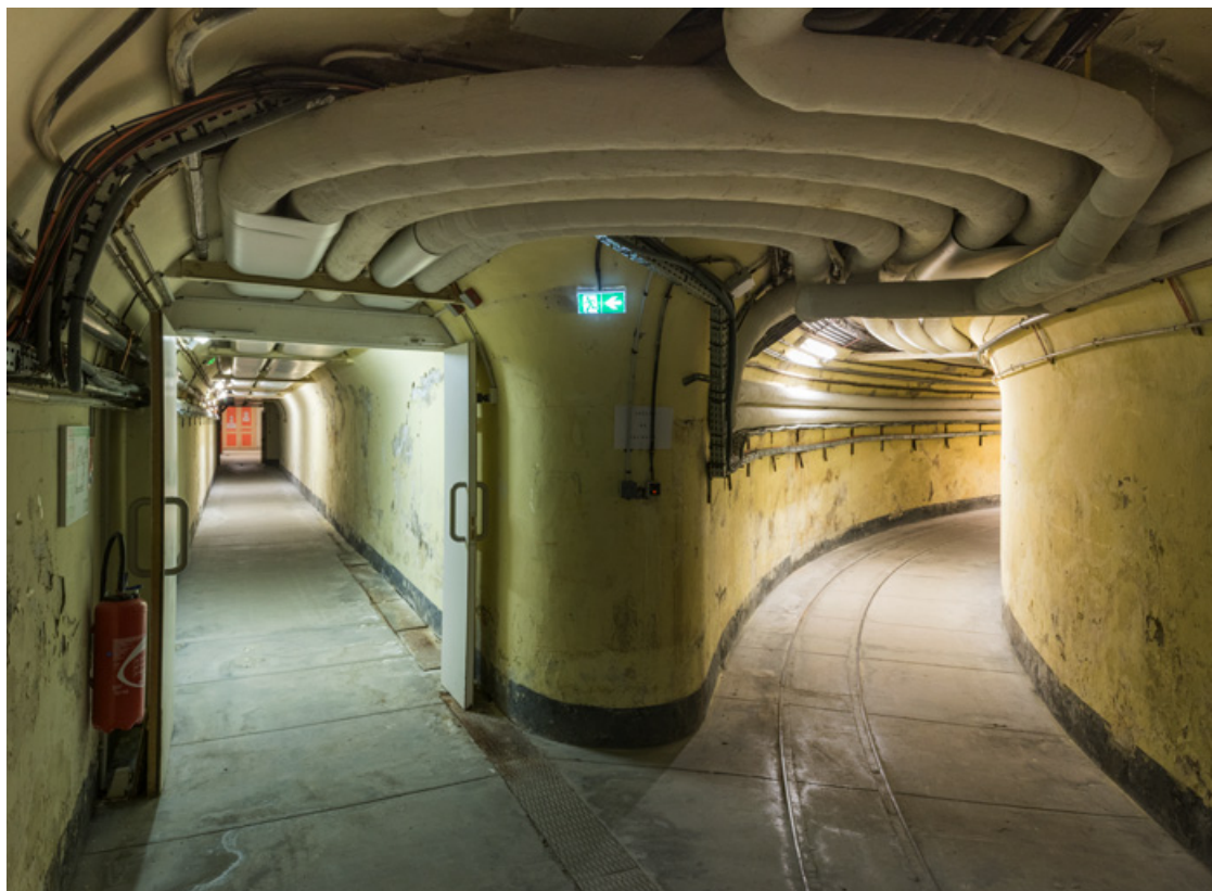
Sous-sol : couloir souterrain. A gauche desserte de la salle du jeu de paume (actuel Pavillon de l'Industrie), à droite de l'aile de la Marine.
