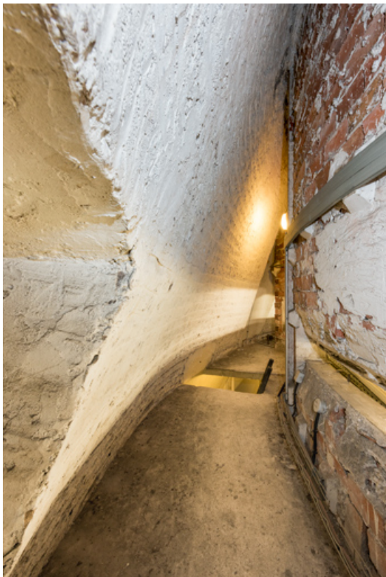
Galerie entre la paroi extérieure (à gauche) et le tambour de la coupole. 71, Le Creusot rue Jules Guesde
