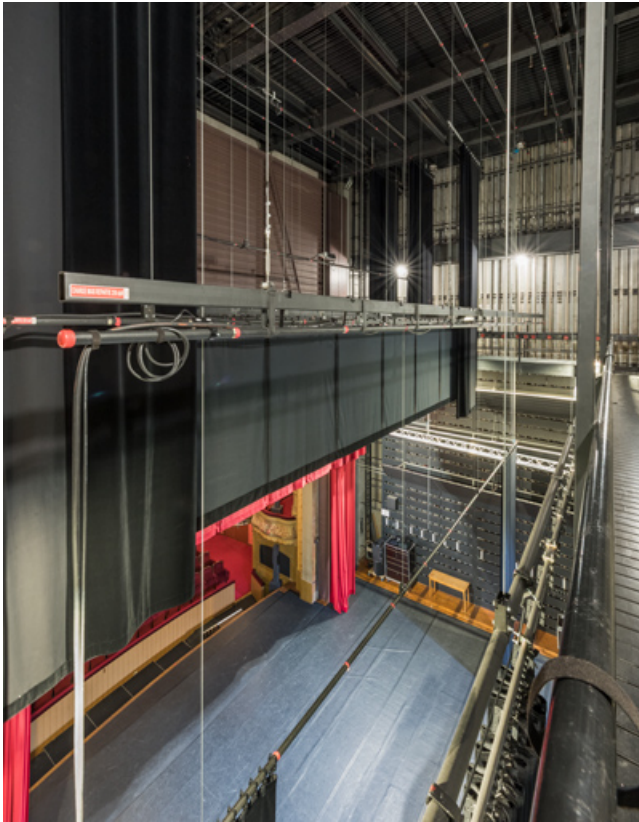
Cage de scène : vue plongeante sur le plateau depuis une passerelle. 71, Autun place du Champ de Mars
