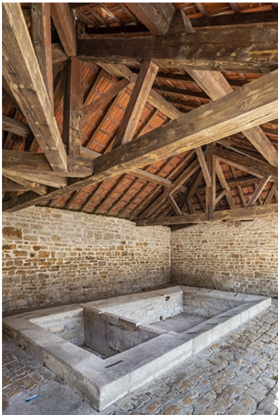
L'ensemble de l'intérieur du lavoir.
