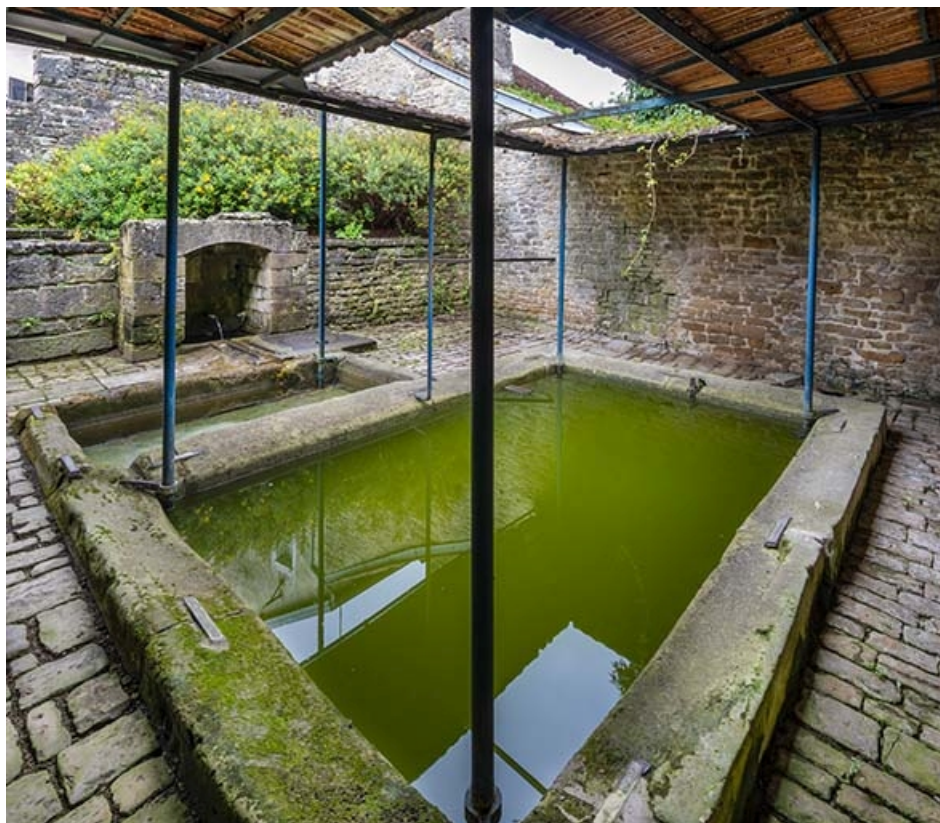
Vue intérieure des bassins.
