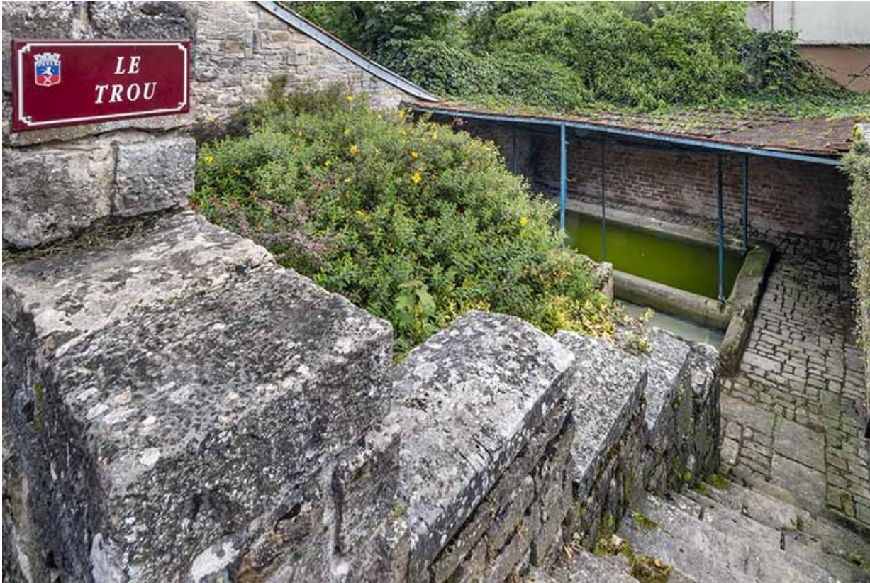
L'escalier et les bassins depuis la rue.
