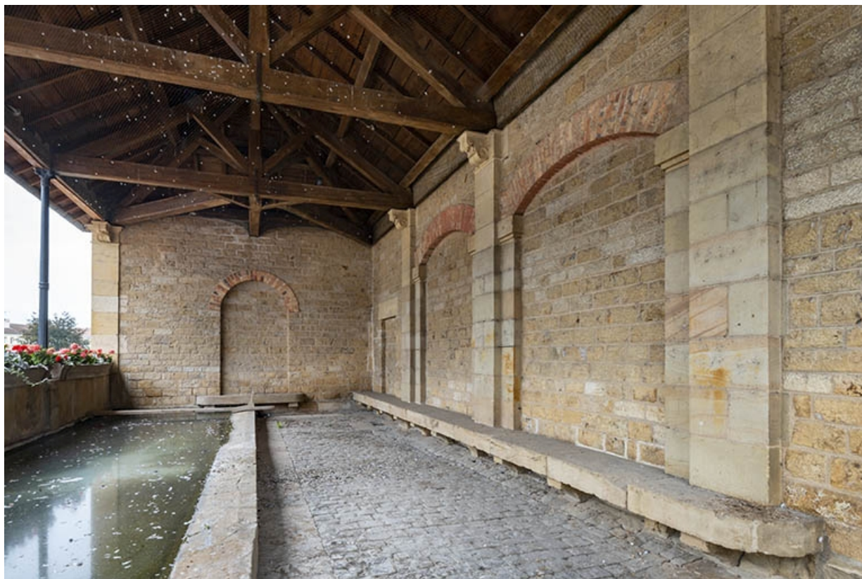
L'intérieur du lavoir en biais, depuis l'entrée.
