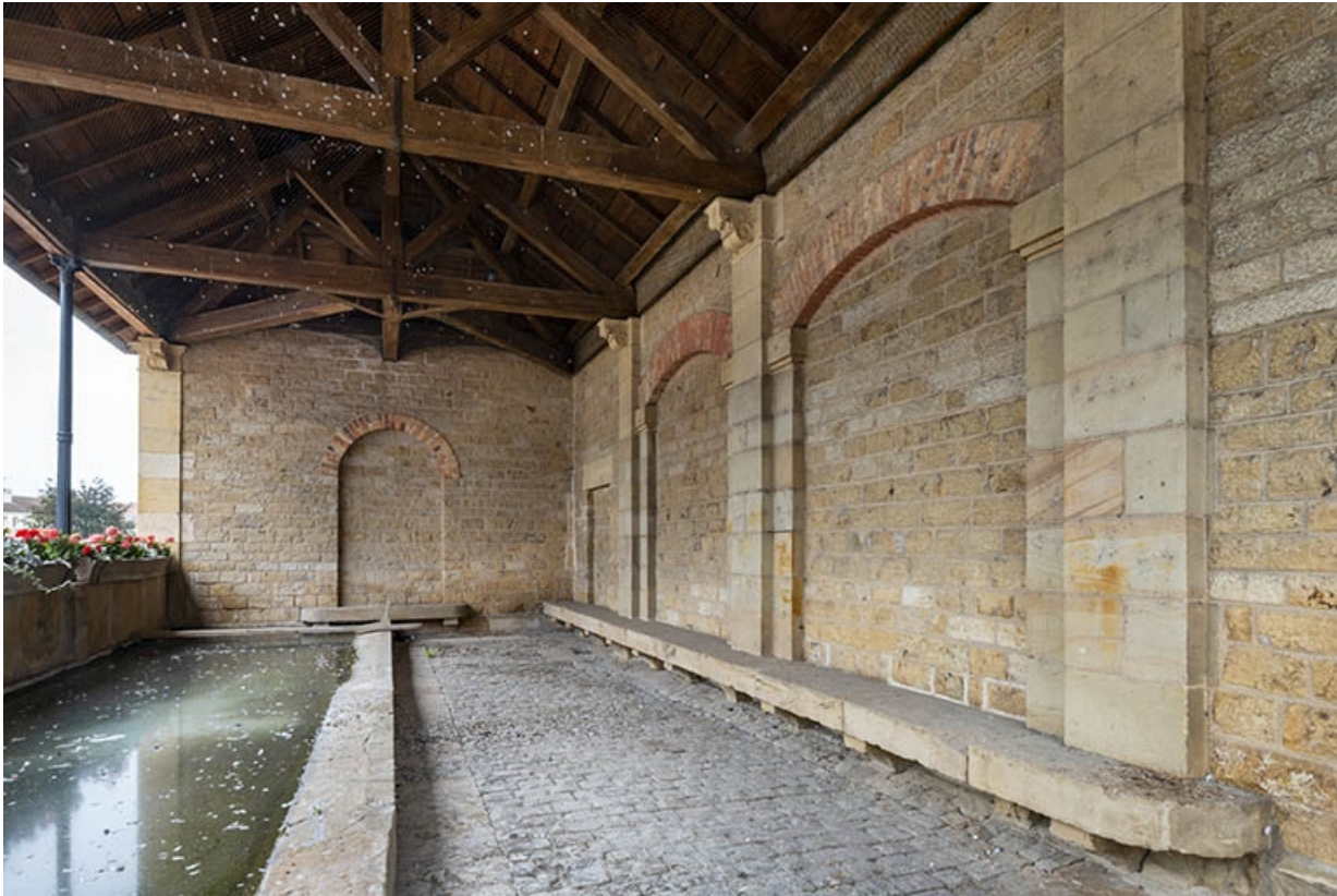
L'intérieur du lavoir en biais, depuis l'entrée. 70, Jussey rue de l' Hôtel-de-Ville
