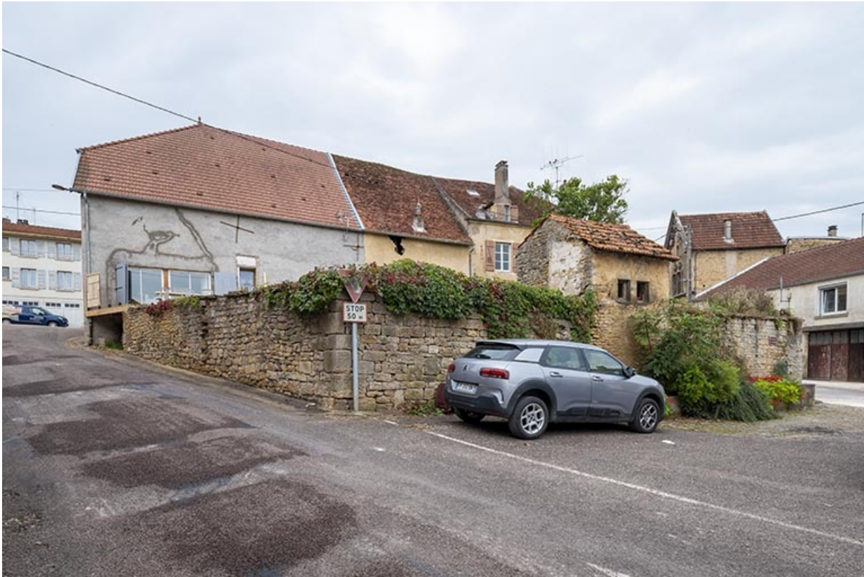
L'arrière de la ferme et le mur de soutènement du jardin.
