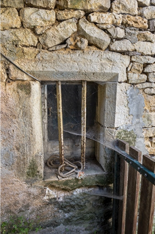
Baie chanfreinée au rez-de-chaussée.
