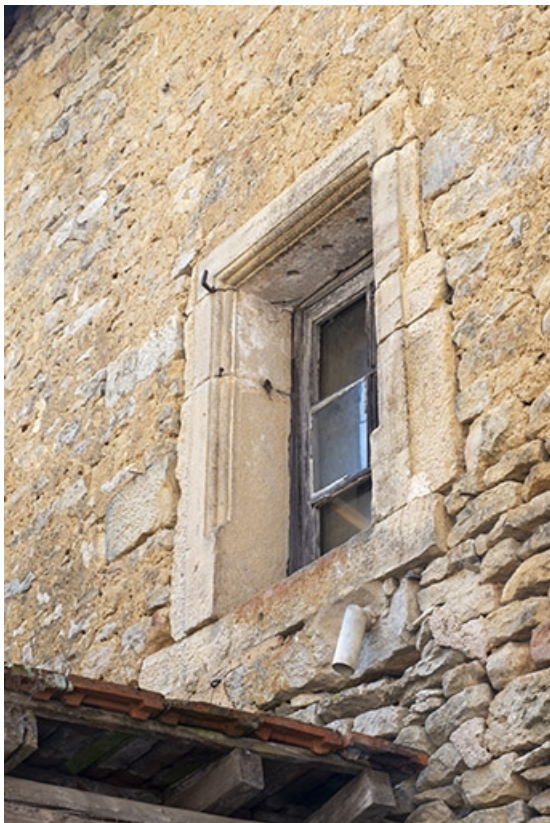
Une baie de l'étage, côté cour.
