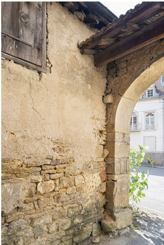
Détail de maçonnerie depuis la cour.
