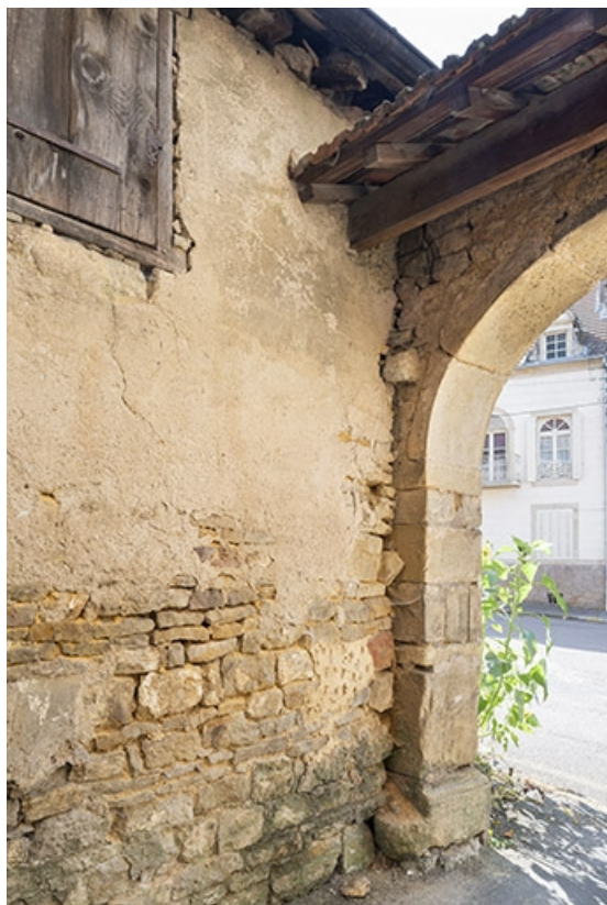
Détail de maçonnerie depuis la cour.
