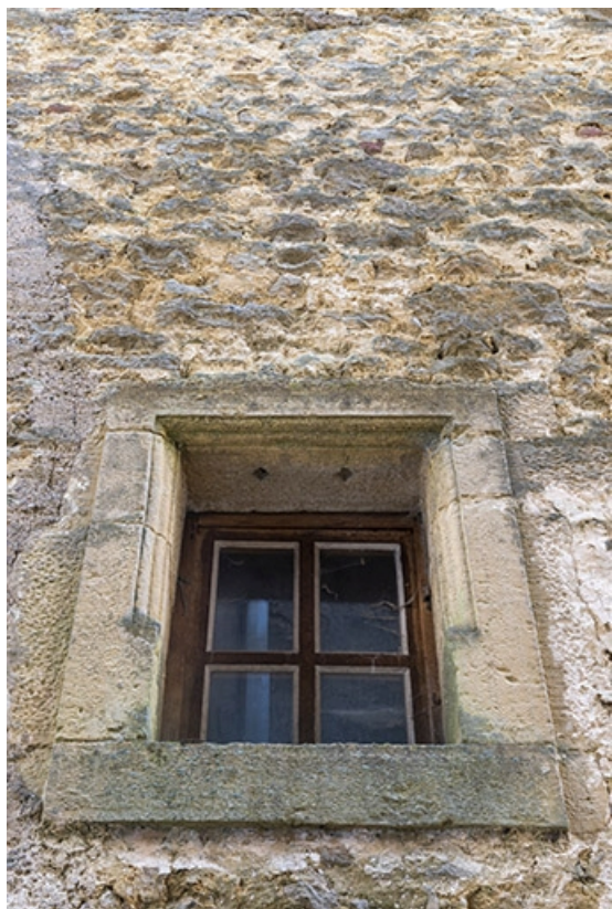
Une baie de l'étage, côté cour.
