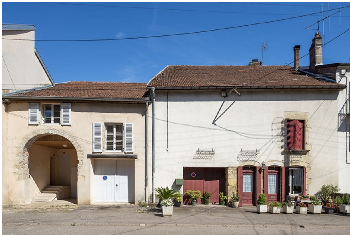
Les n° 27 et 29 de la rue Thiers.
