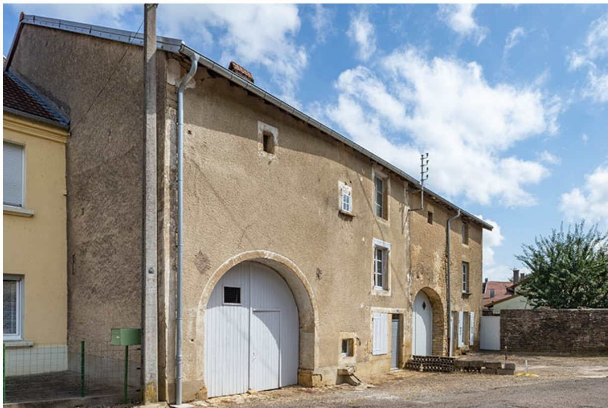
Les n° 21 et 23 rue de l'Aître, de trois quarts gauche. 70, Jussey rue du Parlement
