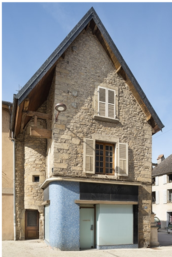
Le pignon et l'escalier, depuis la rue Gambetta. 70, Jussey, 19 rue Gambetta
