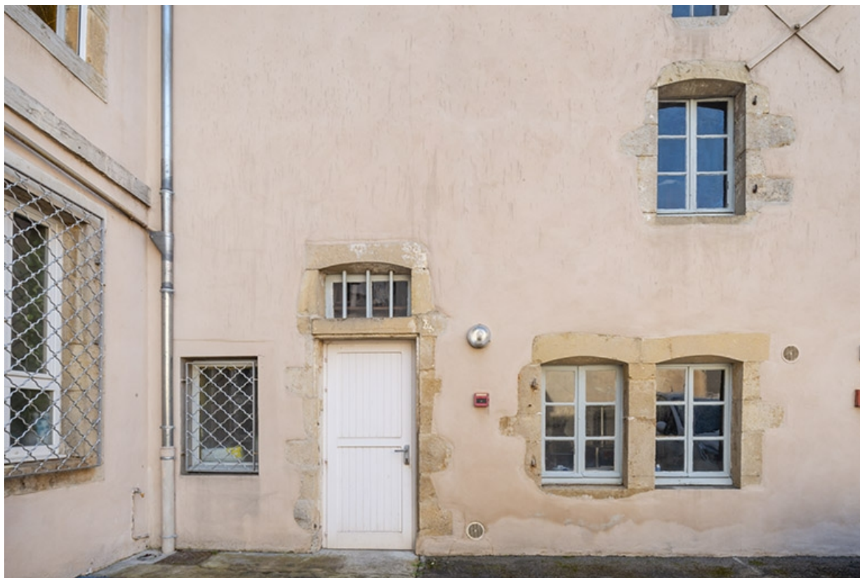
Détail de la façade gauche dans la cour.
