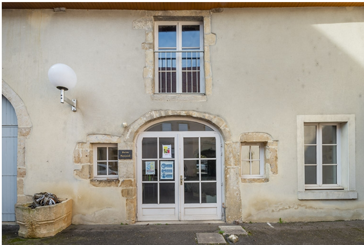
Détail de la façade du bâtiment au fond de la cour.
