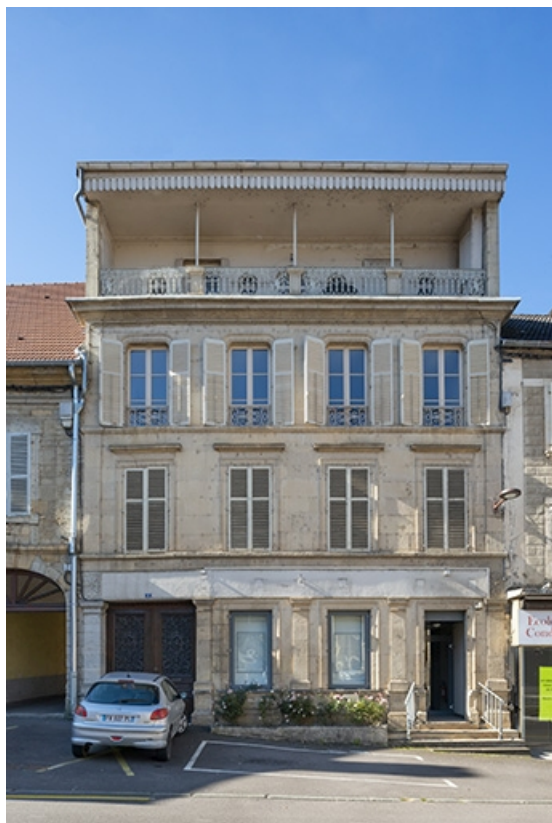
Façade de l'immeuble sur la rue.
