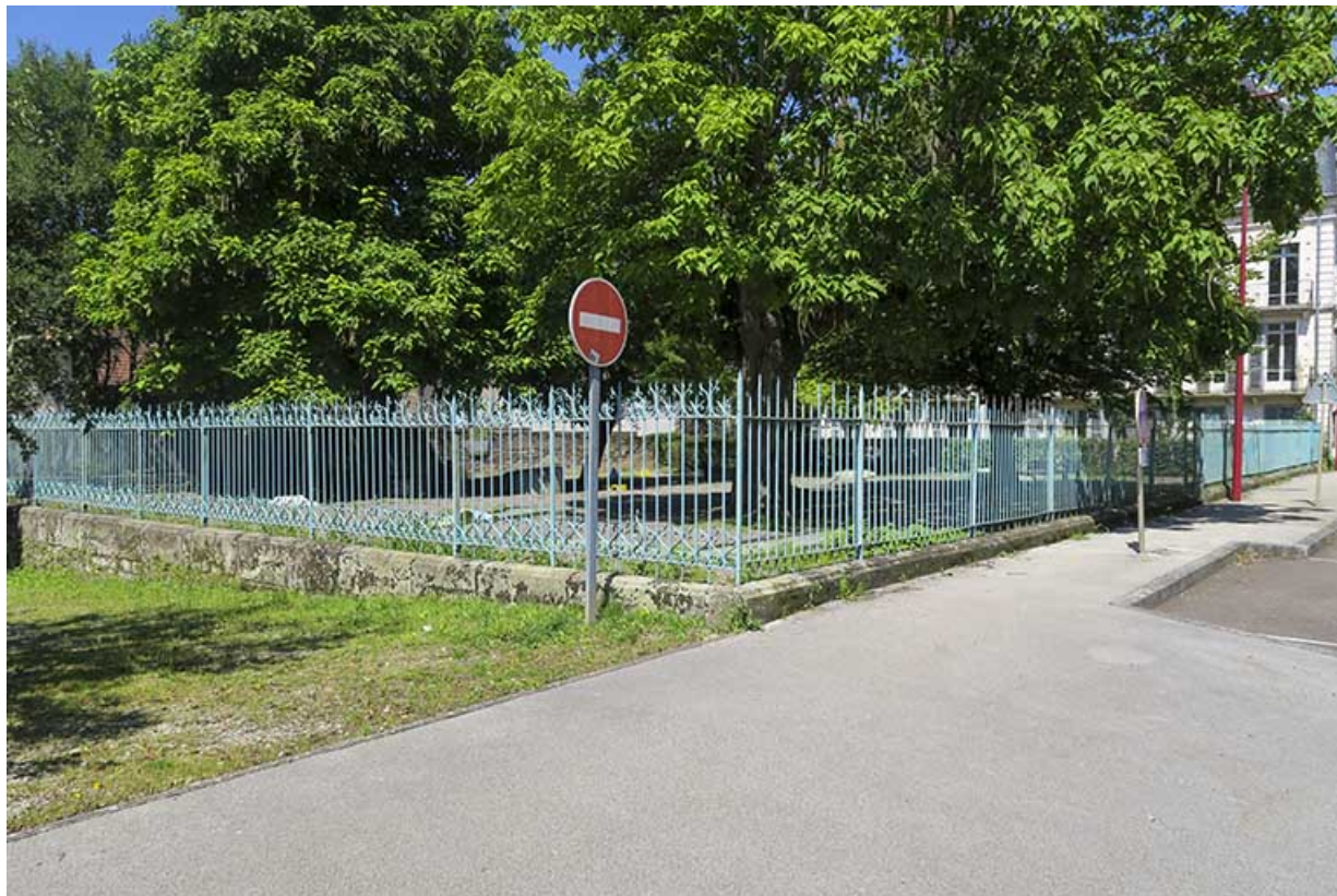
Clôture encore en place, vue depuis le boulevard Richet.
