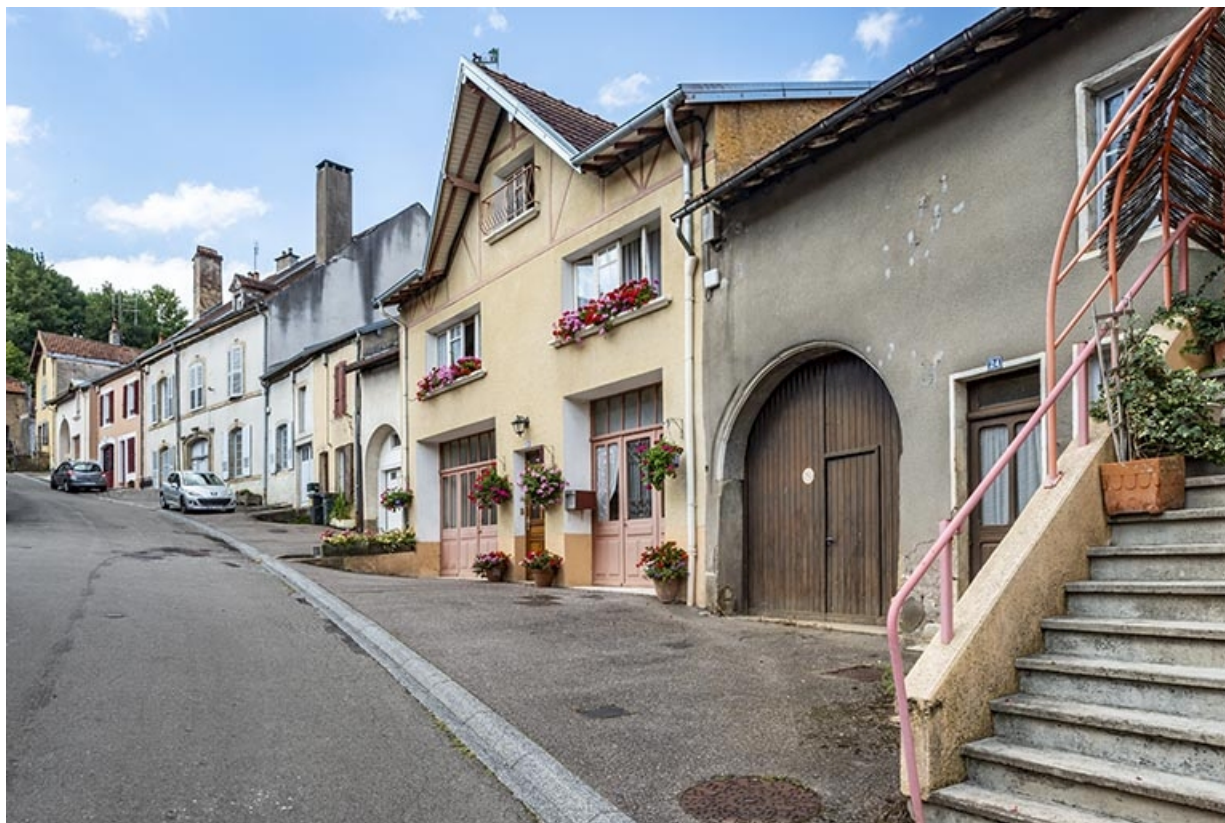
Vue d'ensemble des façades de la rive des numéros pairs de la rue Decaen, vers le sud-ouest. 70, Jussey rue Decaen
