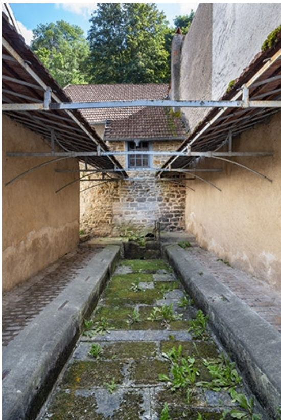
L'intérieur de la fontaine-lavoir.
