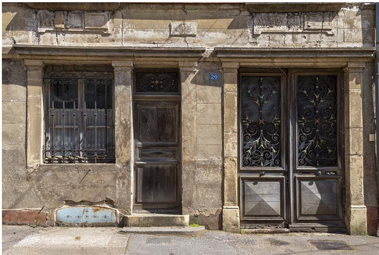
Pilastres, ferronnerie, menuiserie, bas-relief sur la façade.
