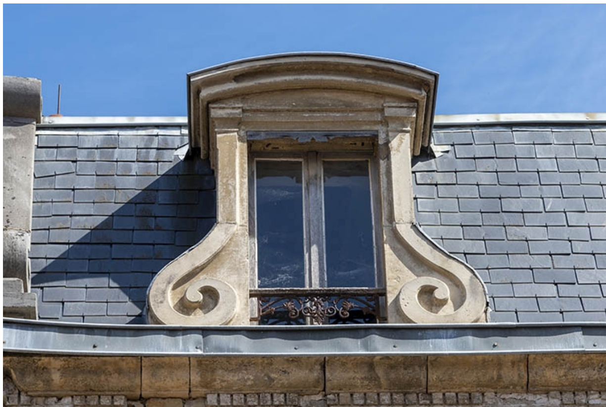
Détail de la lucarne sur brisis, à gauche.
