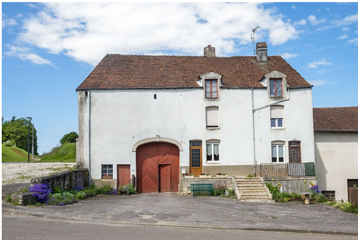
La façade antérieure depuis la rue.
