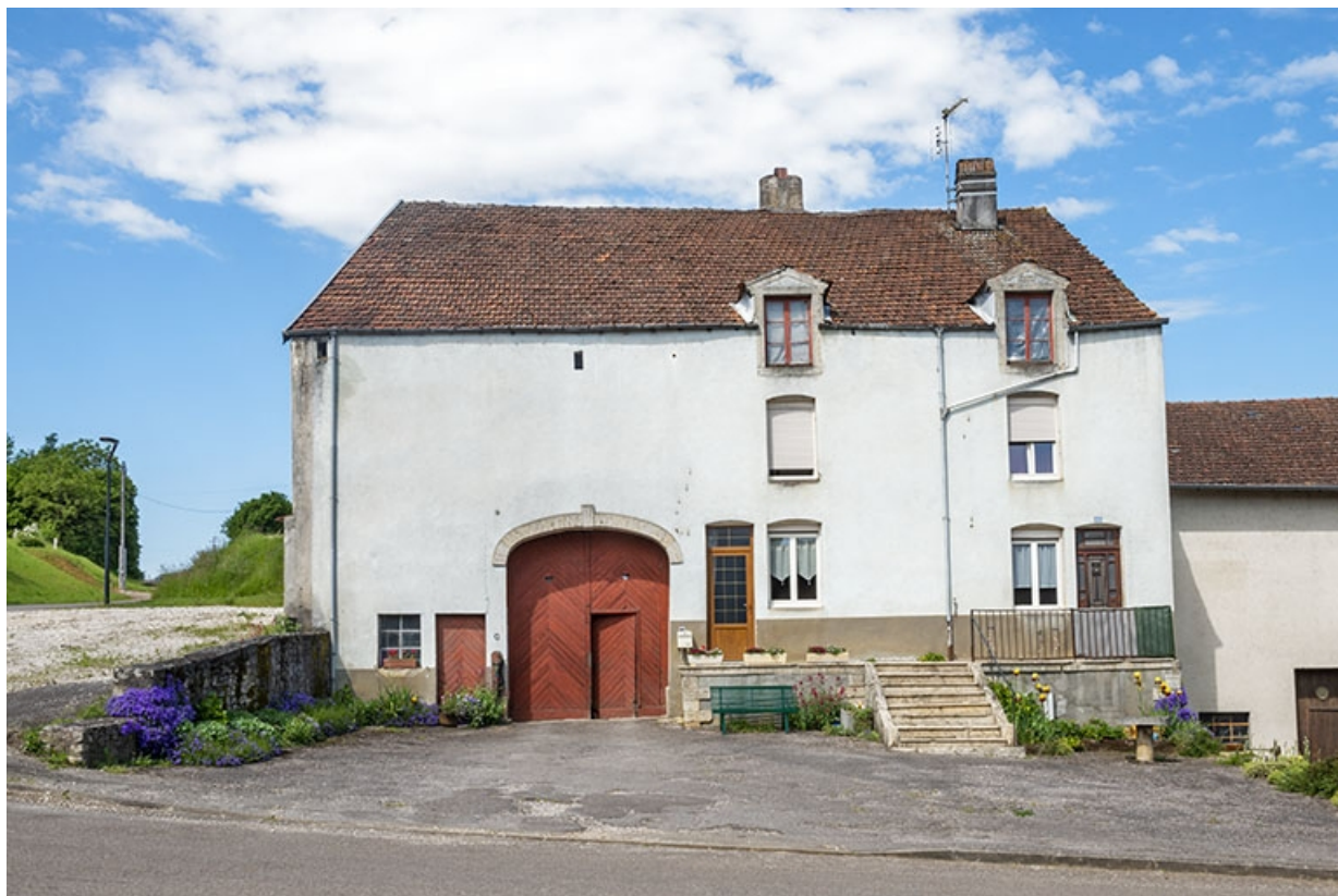
La façade antérieure depuis la rue.
