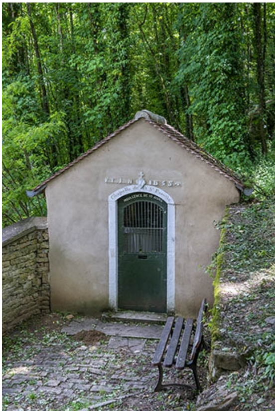
Vue de la façade antérieure de la chapelle de la sainte famille. 70, Jussey
