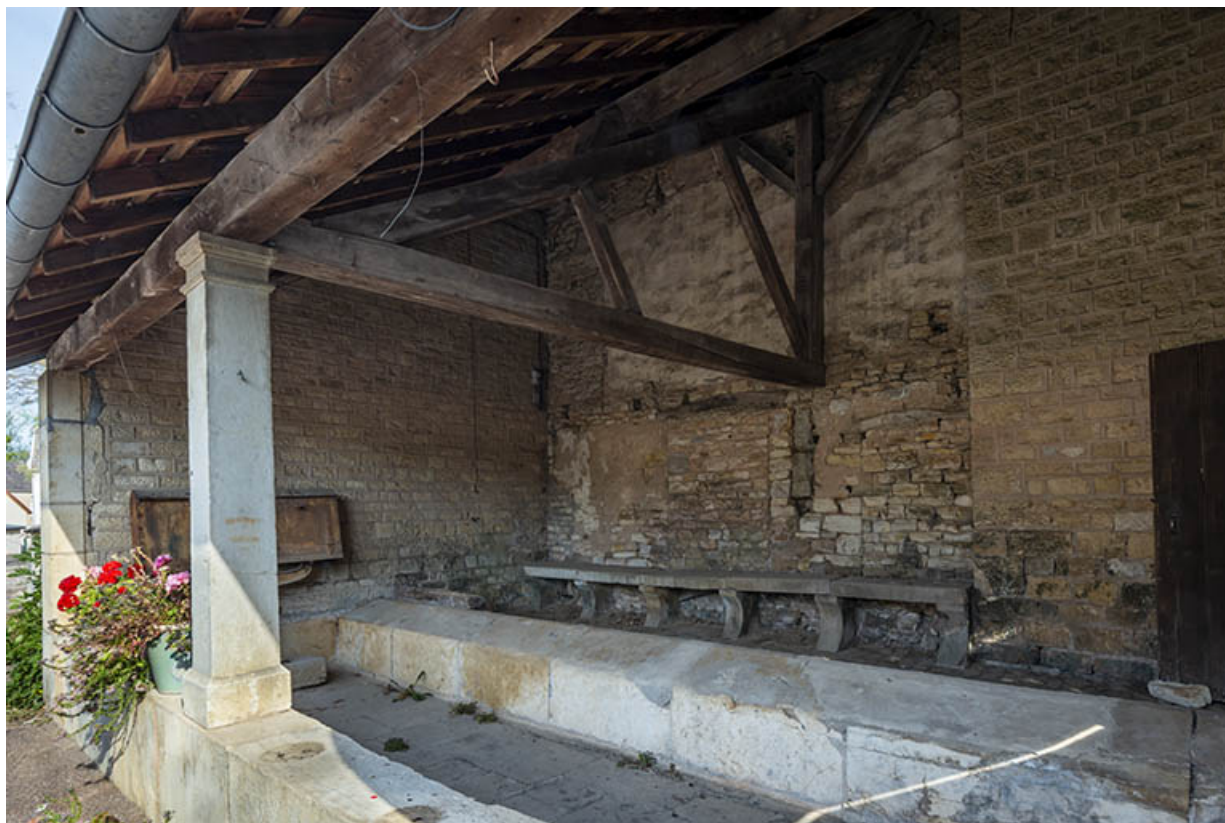
Petite fontaine, vue du lavoir depuis la rue.
