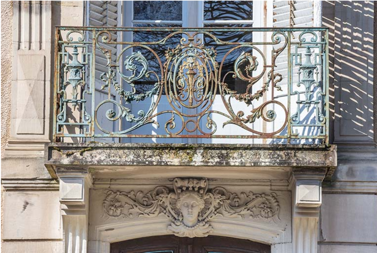
Façade est, détail : balcon.
