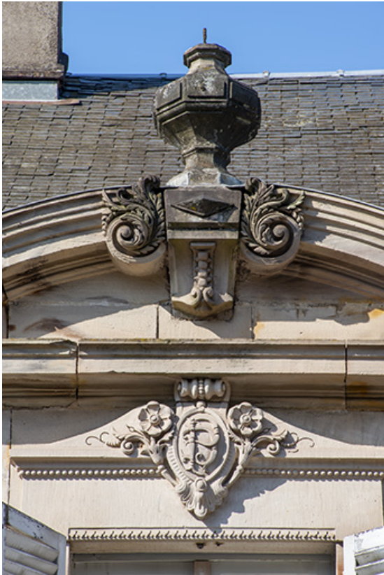
Façade est, détail : décor sculpté du fronton. 70, Luxeuil-les-Bains, 5 rue de Grammont
