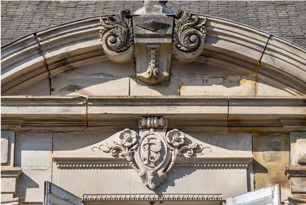
Façade est, détail : décor sculpté du fronton. 70, Luxeuil-les-Bains, 5 rue de Grammont
