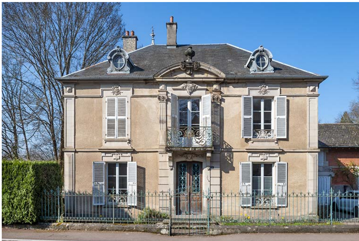
Façade est, vue de face.
