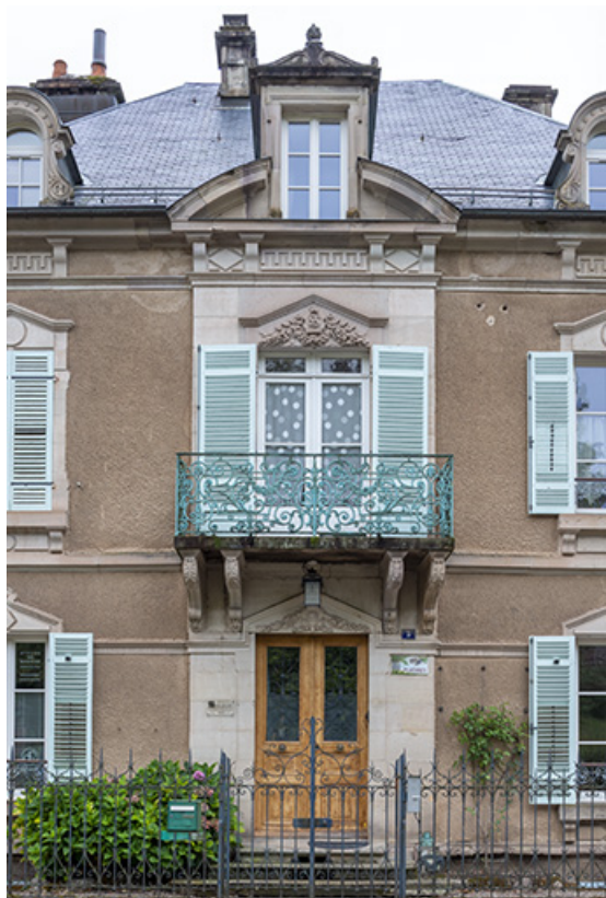
Façade principale (est) sur la rue de Grammont, travée centrale. 70, Luxeuil-les-Bains, 3 rue de Grammont
