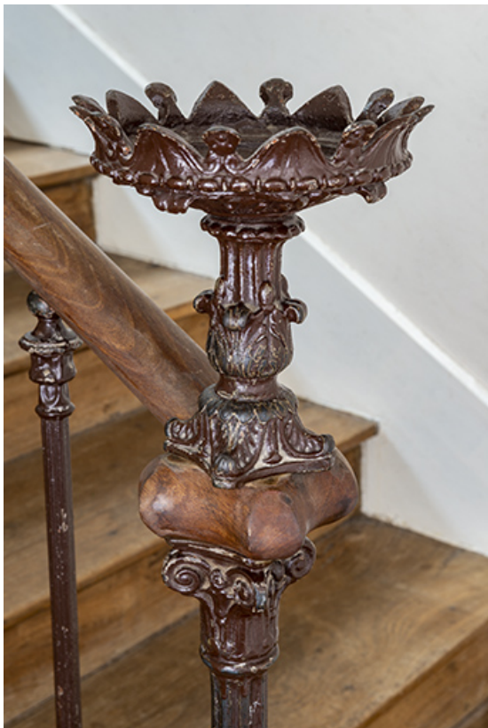
Ornement en fonte de la main-courant de l'escalier. 70, Luxeuil-les-Bains, 3 rue de Grammont
