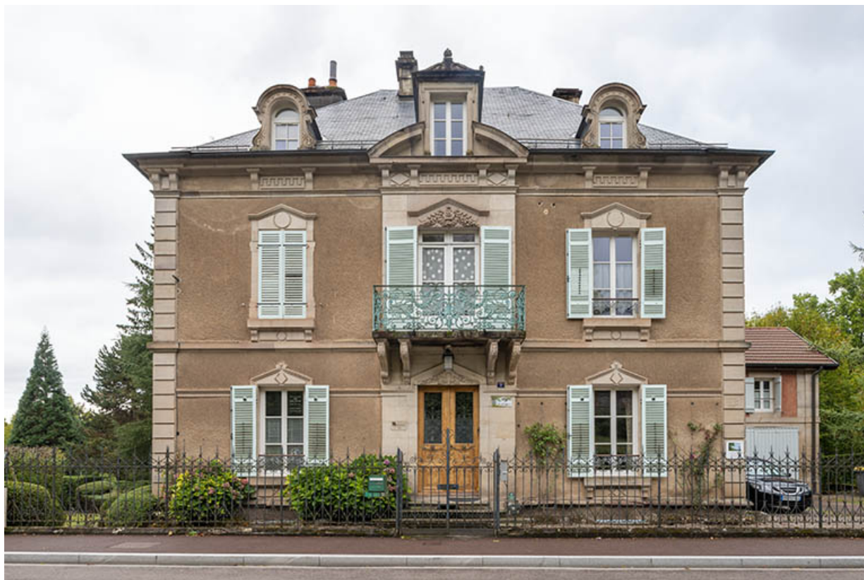
Façade principale (est) sur la rue de Grammont.
