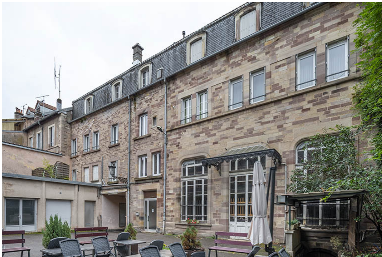
Façade sur la cour du corps côté rue.
