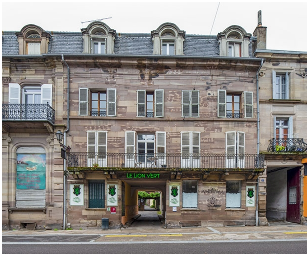
Façade sur la rue du corps de bâtiment construit par François Richard en 1835. 70, Luxeuil-les-Bains, 16 rue Carnot
