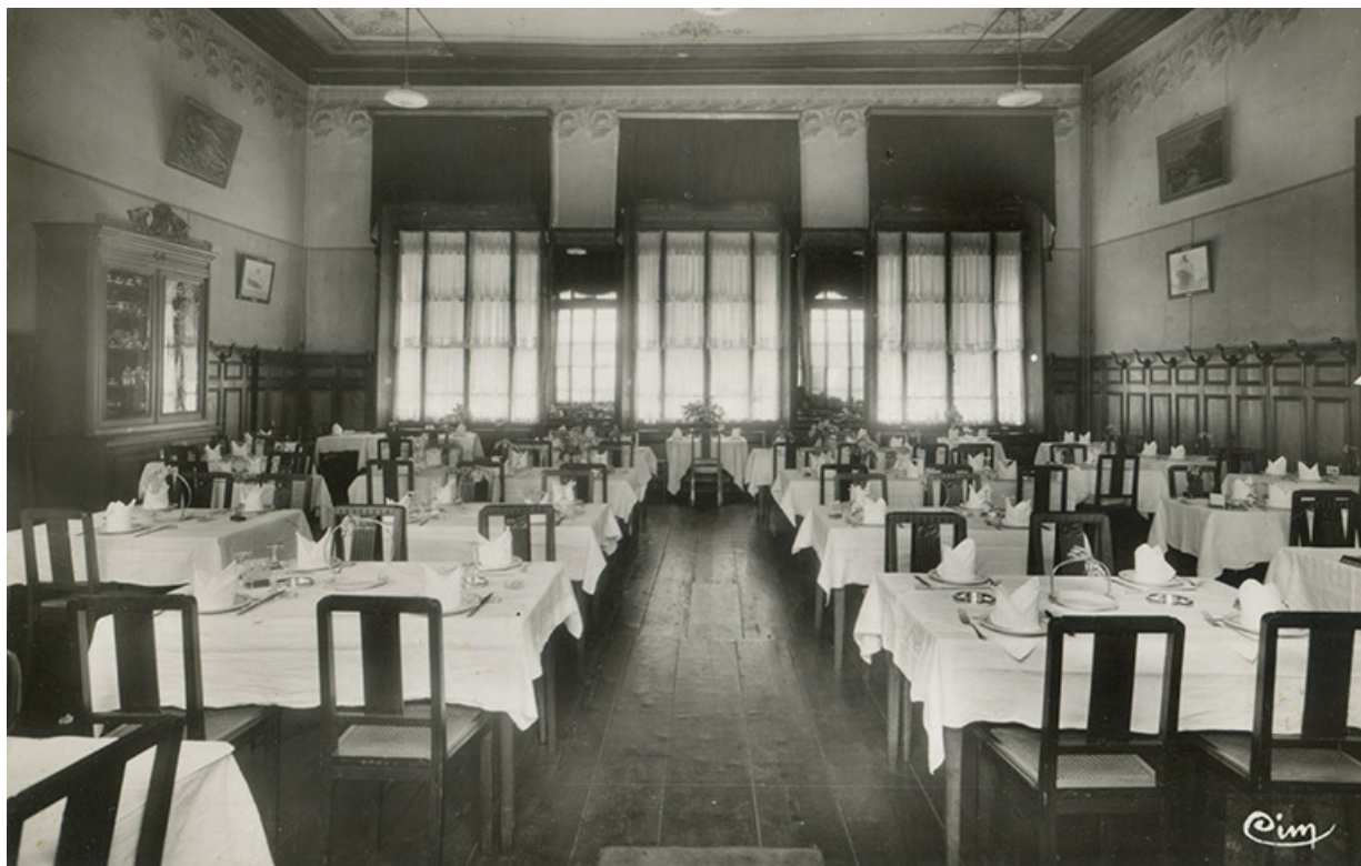
Vue ancienne du restaurant. 70, Luxeuil-les-Bains, 16 rue Carnot
