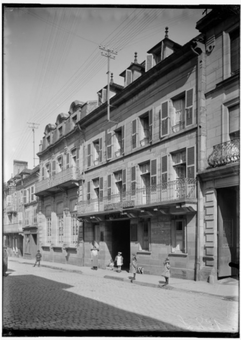
Vue ancienne de la façade sur la rue Carnot.
