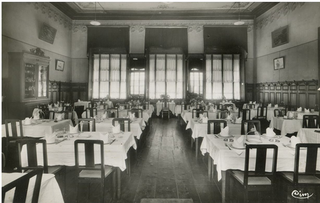
Vue ancienne du restaurant. 70, Luxeuil-les-Bains, 16 rue Carnot
