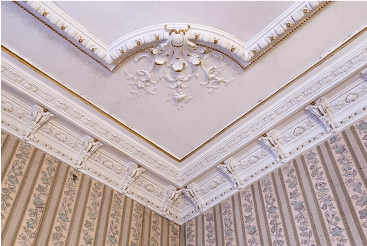
Détail des moulures du plafond du salon du rez-de-chaussée.
