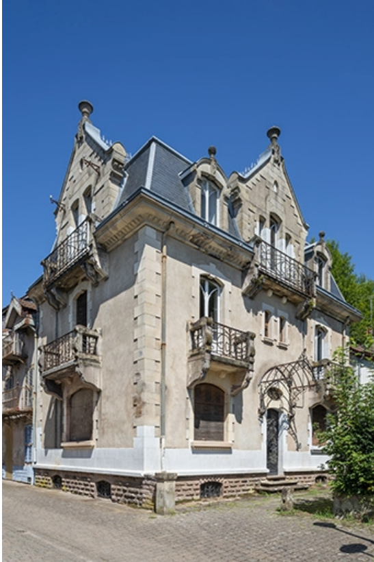
Vue d'ensemble depuis l'allée des Romains.
