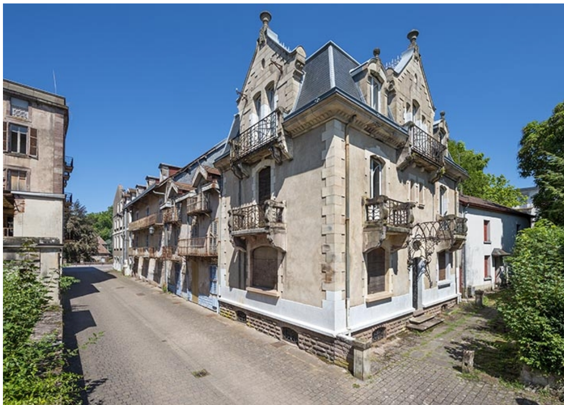
Vue d'ensemble depuis l'allée des Romains.
