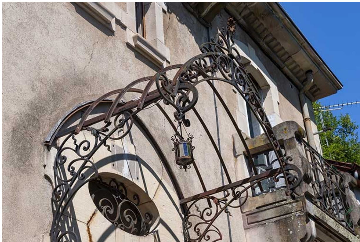
Marquise au-dessus de la porte d'entrée. 70, Luxeuil-les-Bains, 10 allée des Romains
