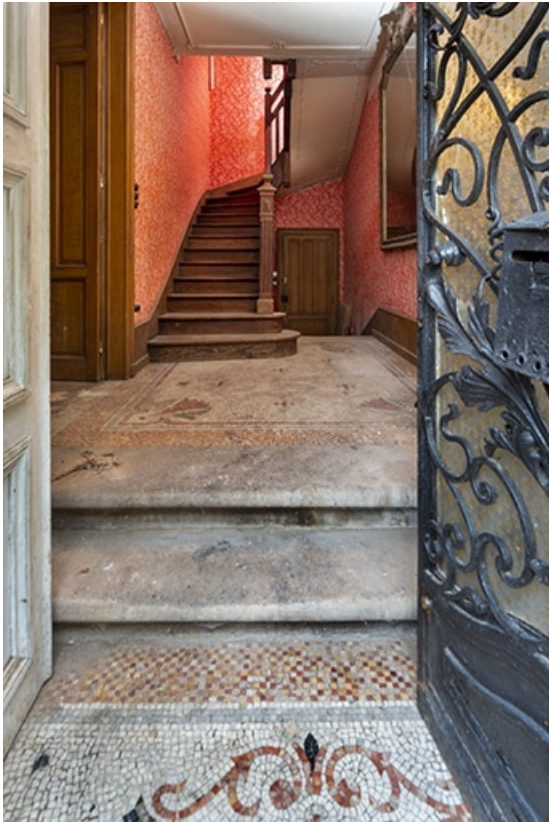
Vestibule et escalier, vue depuis la porte d'entrée.
