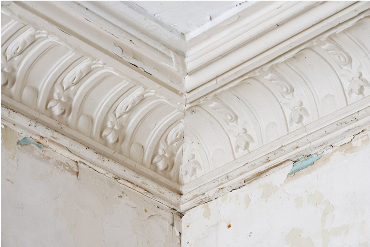
Détail des moulures du plafond de la chambre sud-est du premier étage. 70, Luxeuil-les-Bains, 10 allée des Romains
