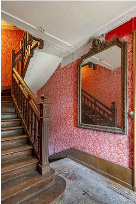
Escalier, vue depuis le palier du rez-de-chaussée.
