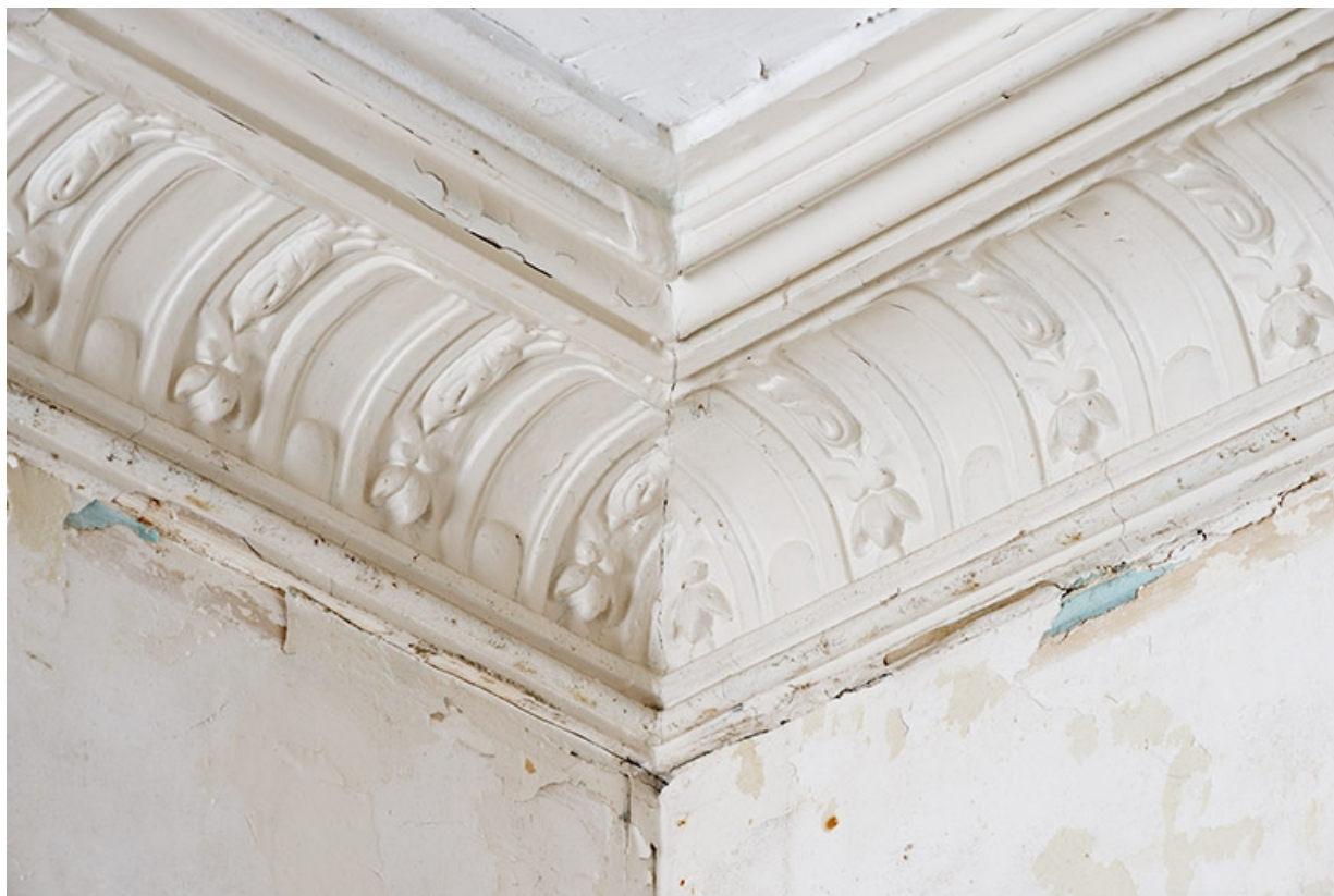
Détail des moulures du plafond de la chambre sud-est du premier étage.
