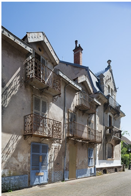
Ancienne maison, avec la Villa des Tilleuls (à droite). 70, Luxeuil-les-Bains, 10 allée des Romains
