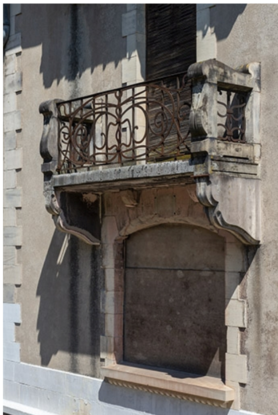
Fenêtre du rez-de-chaussée et balcon du premier étage.
