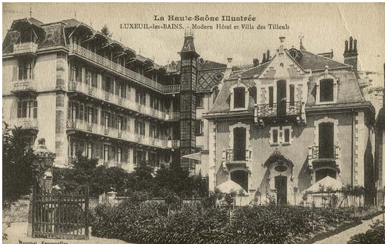
Vue ancienne (deuxième quart du 20e siècle). 70, Luxeuil-les-Bains, 10 allée des Romains
