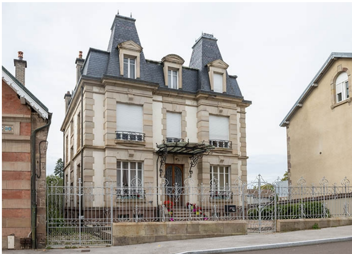
Façade principale, vue de trois quarts depuis le sud-est.
