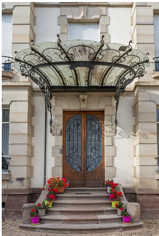
Porte d'entrée surmontée d'une marquise, vue de face. 70, Luxeuil-les-Bains, 11B rue de Grammont
