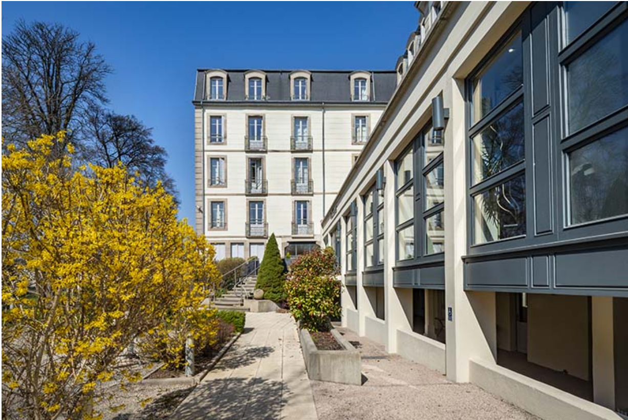
Extension en rez-de-chaussée côté parc. 70, Luxeuil-les-Bains, 2 avenue Jean Moulin
