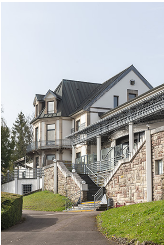
Maison, vue depuis le nord.
