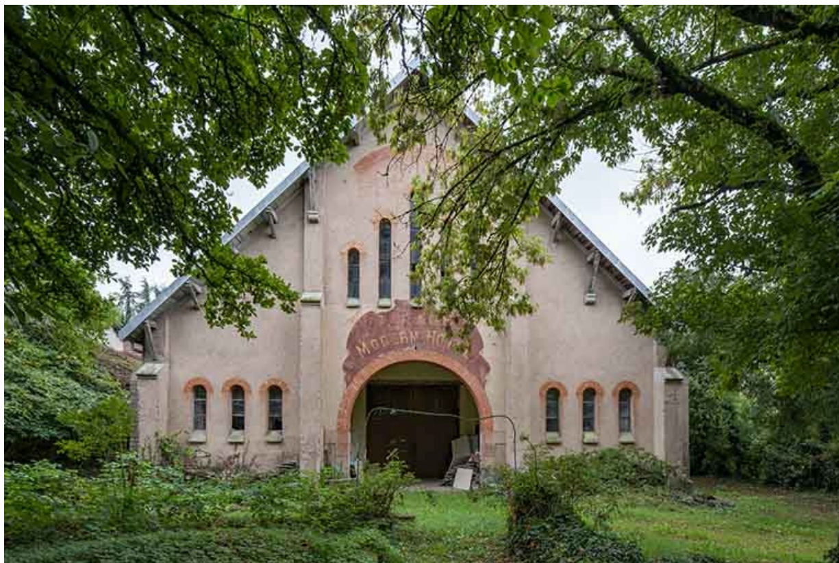
Mur-pignon nord, vue de face.
