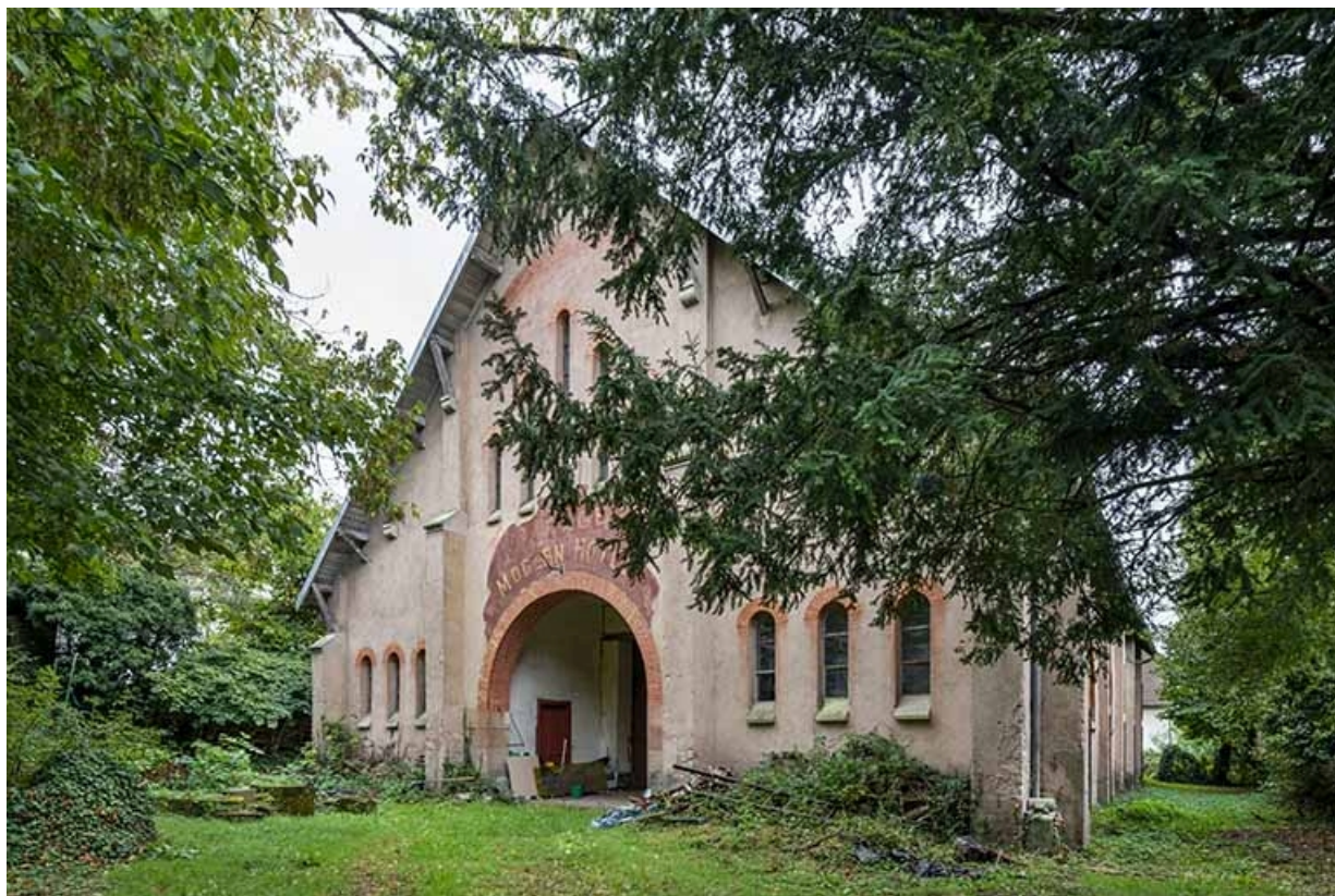
Mur-pignon nord, vue de trois quarts.
