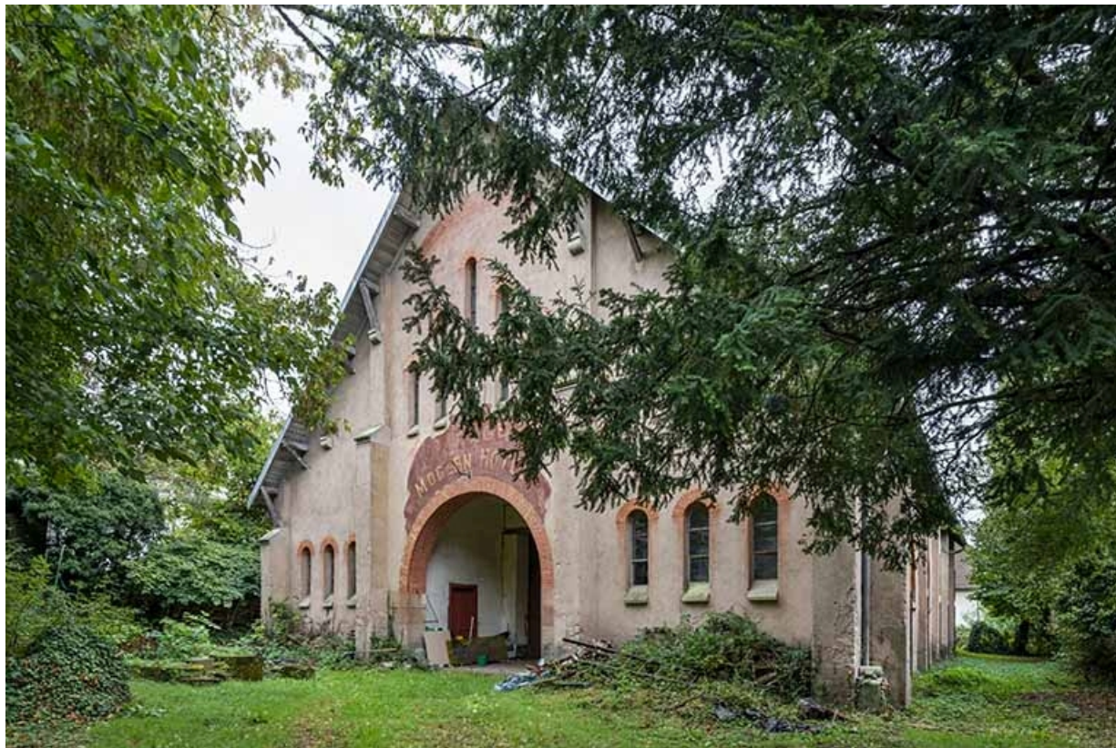
Mur-pignon nord, vue de trois quarts.
