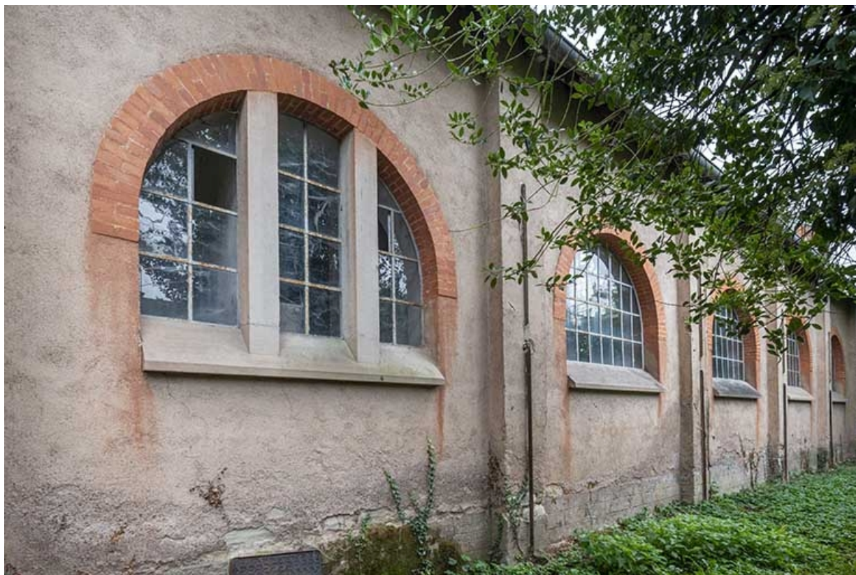
Mur-gouttereau ouest, fenêtre thermale.
